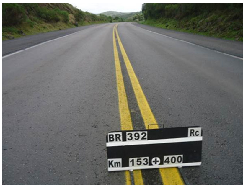
Figura 02 – Manutenção do Pavimento – BR-392/RS
