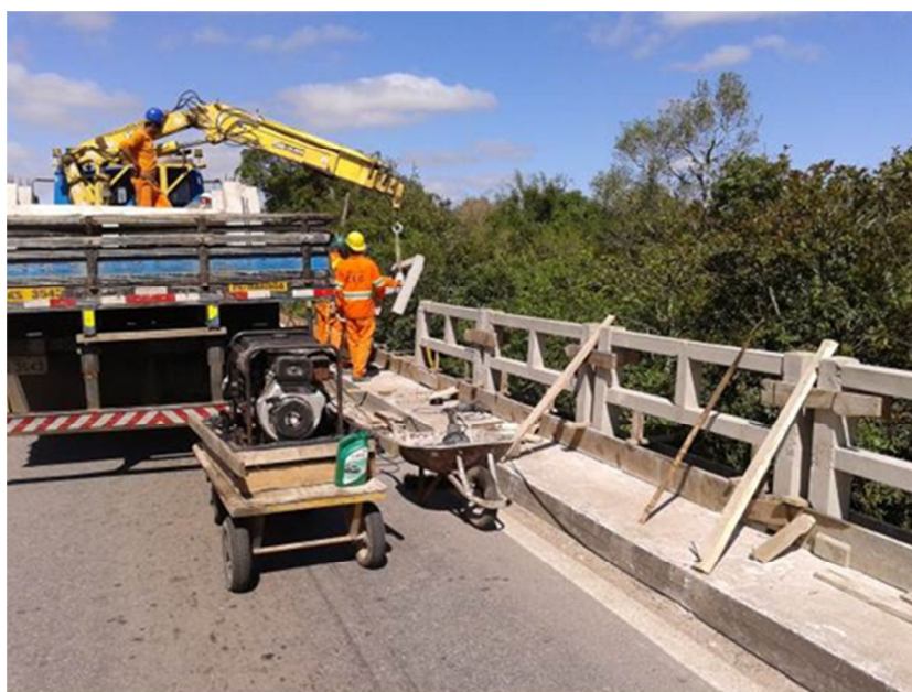
Figura 05 – Recuperação Ponte Sobre o Arroio Grande – BR-116/RS
