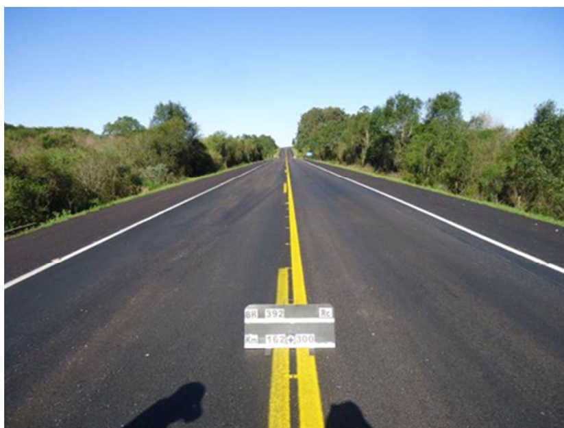
Figura 03 – Manutenção do Pavimento – BR-392/RS
