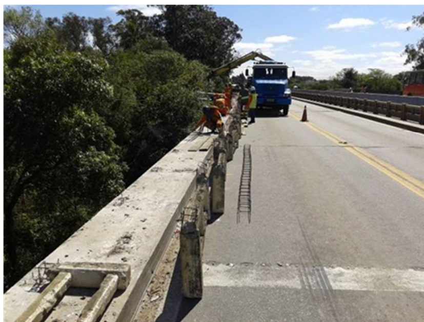
Figura 04 – Recuperação Ponte Sobre o Arroio Grande – BR-116/RS
