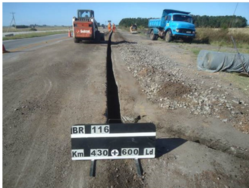
Figura 04 – Implantação drenos de pavimento – BR-116/RS
