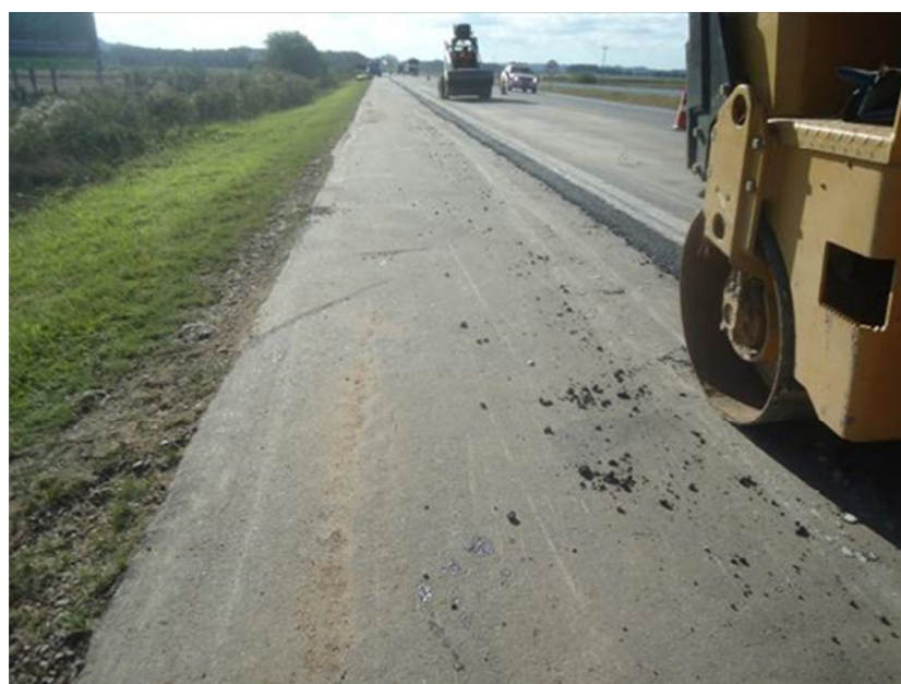
Figura 05 – Implantação drenos de pavimento – BR-116/RS
