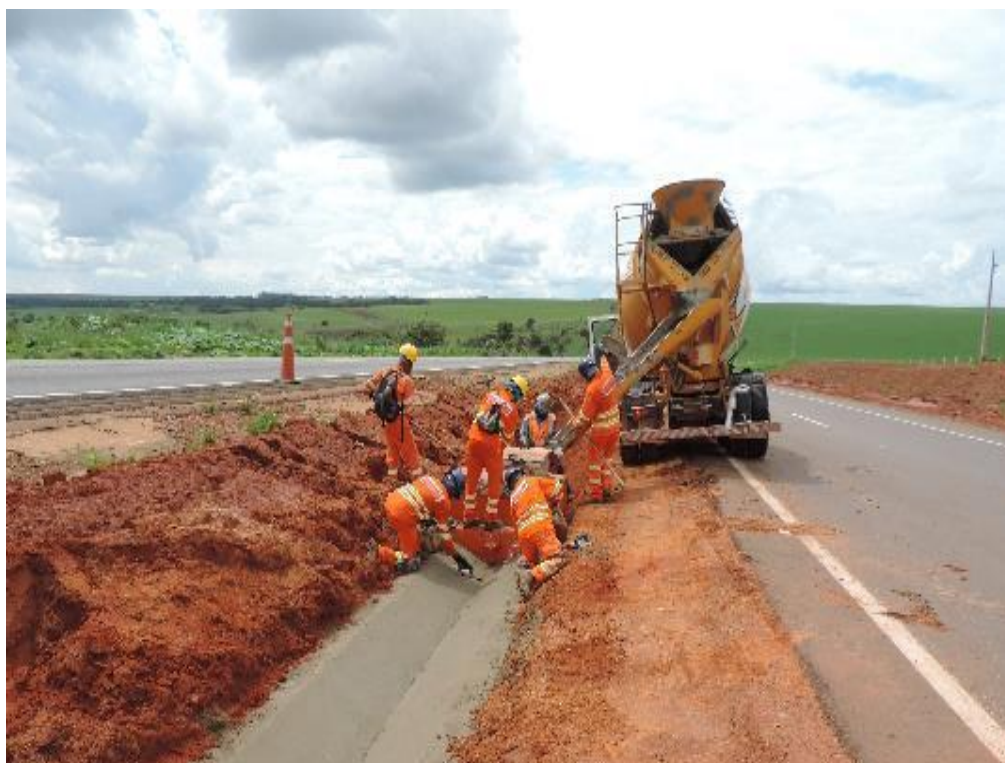
Figura 13 – Sarjeta e canteiro central na duplicação – km 91+200
