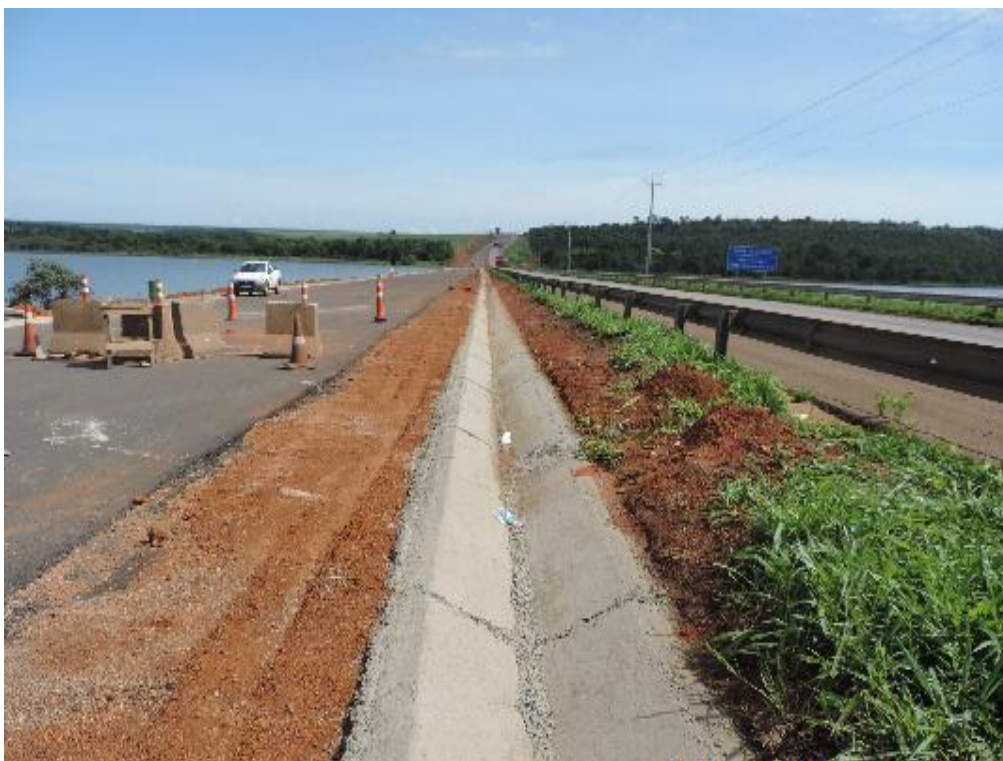
Figura 1 – Sarjeta de canteiro central na duplicação - km 0+020
