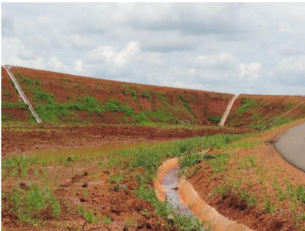
Figura 5 – Drenagem superficial na alça direita Retorno em desnível 1 – km 32+000
