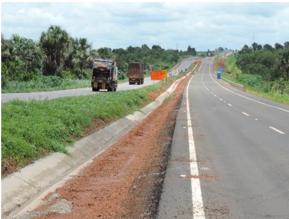
Figura 8 – Sarjeta de canteiro central na duplicação – km 44+200
