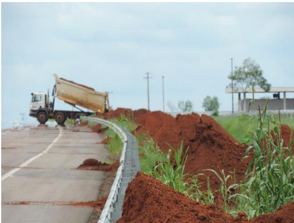
Figura 7 – Conformação de caixa de empréstimo – km 40+400
