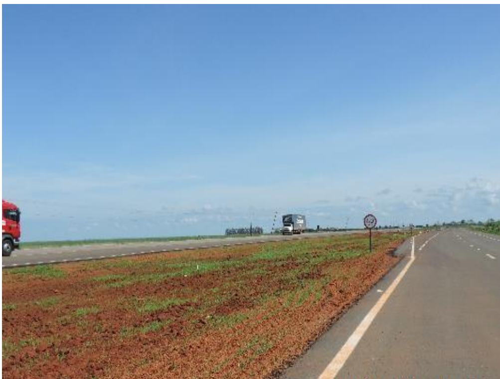
Figura 2 – Hidrossemeadura na alça sul Retorno em nível 1 - km 8+000
