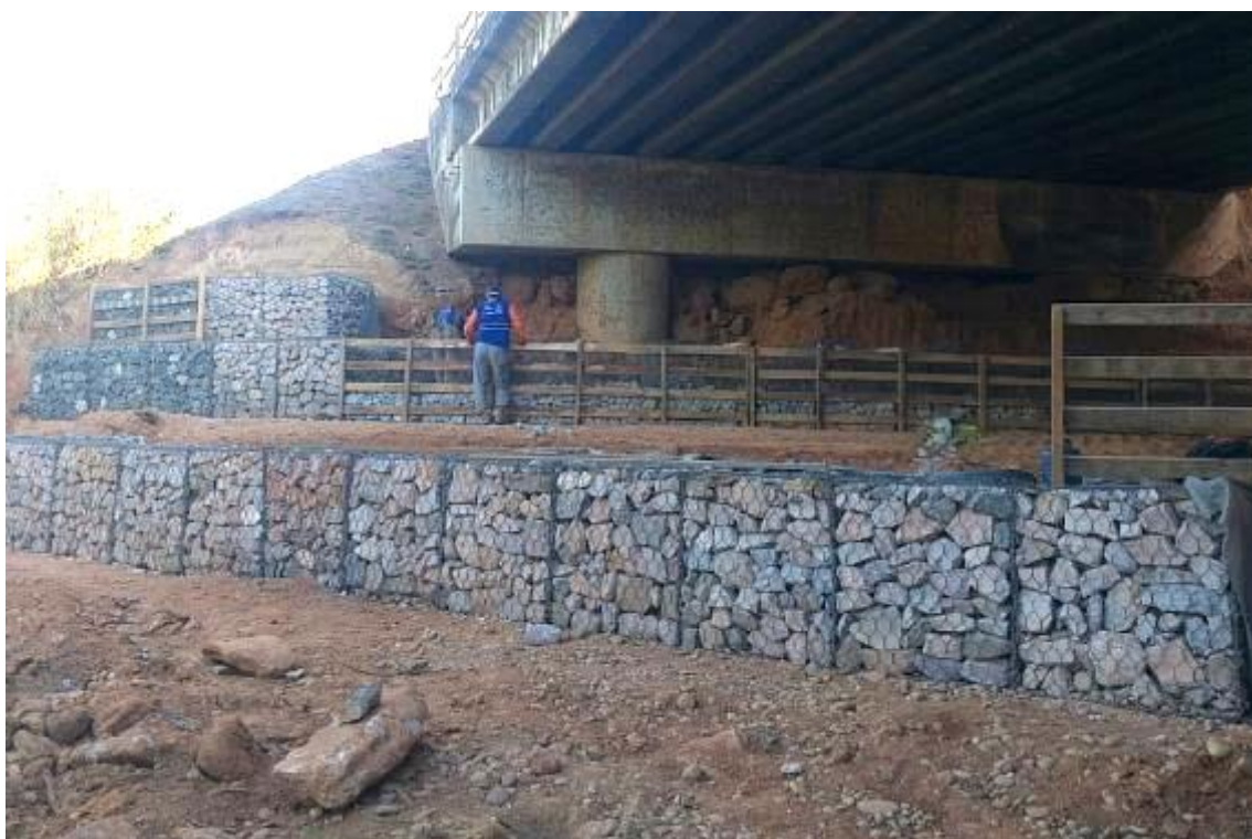
Figura 27: Execução de Gabião para contenção e proteção dos pilares da ponte do Rio Lira. (BR-163) Km 755
