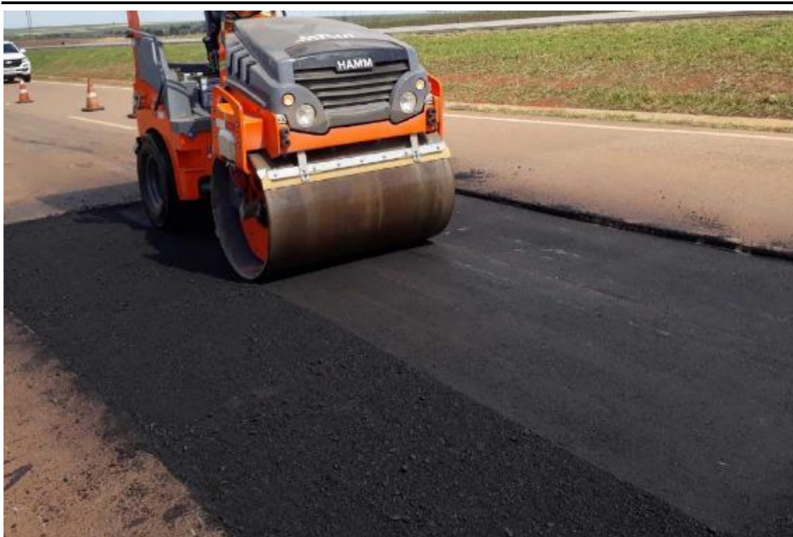
Figura 4: Execução de reparos localizados. (BR-163) Km 56 AO 57
