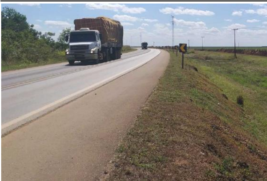
Figura 26: Execução de roçada manual. (BR-163) Km 714 ao 728
