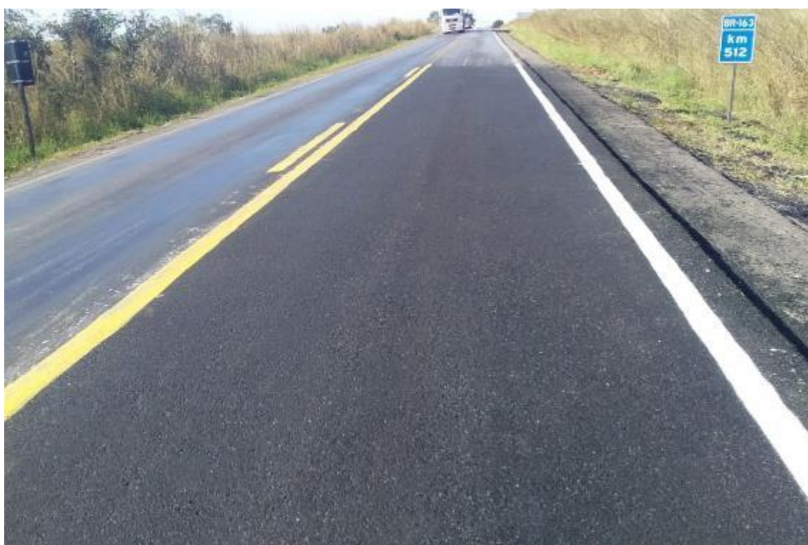
Figura 21: Execução de reparo localizado. (BR-163) Km 512
