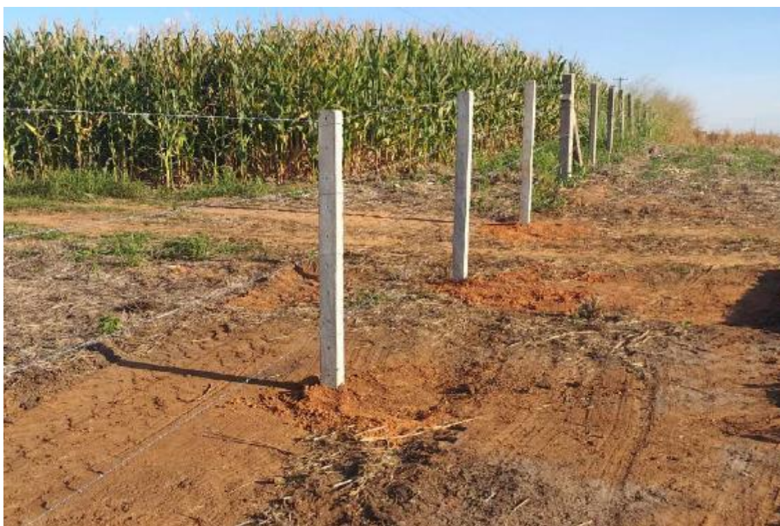
Figura 25: Implantação de cerca para faixa de domínio. (BR-163) Km 684
