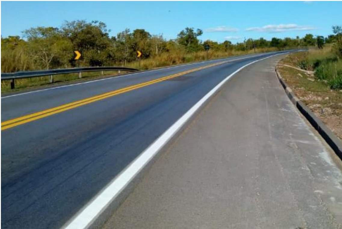
Figura 12: Revitalização de sinalização horizontal. (BR-364) Km 458
