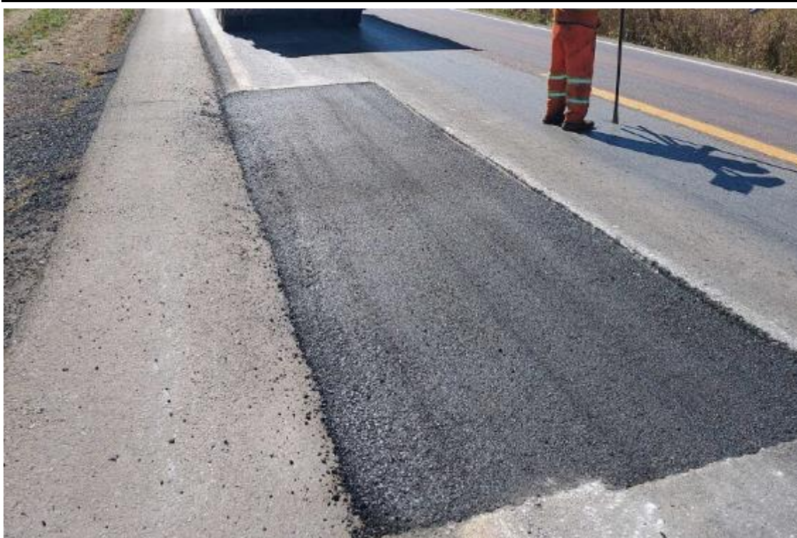
Figura 20: Execução de reparo localizado. (BR-163) Km 508,600
