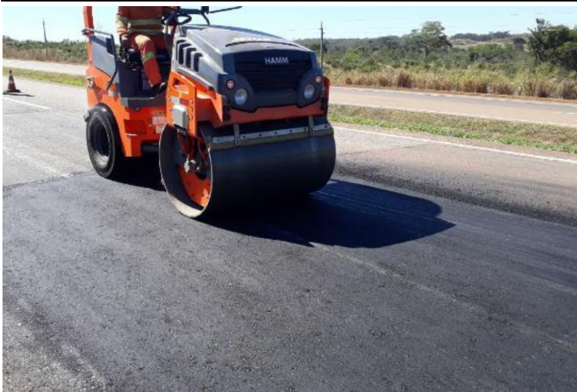
Figura 6: Execução de reparo localizado. (BR-163) Km 82,300
