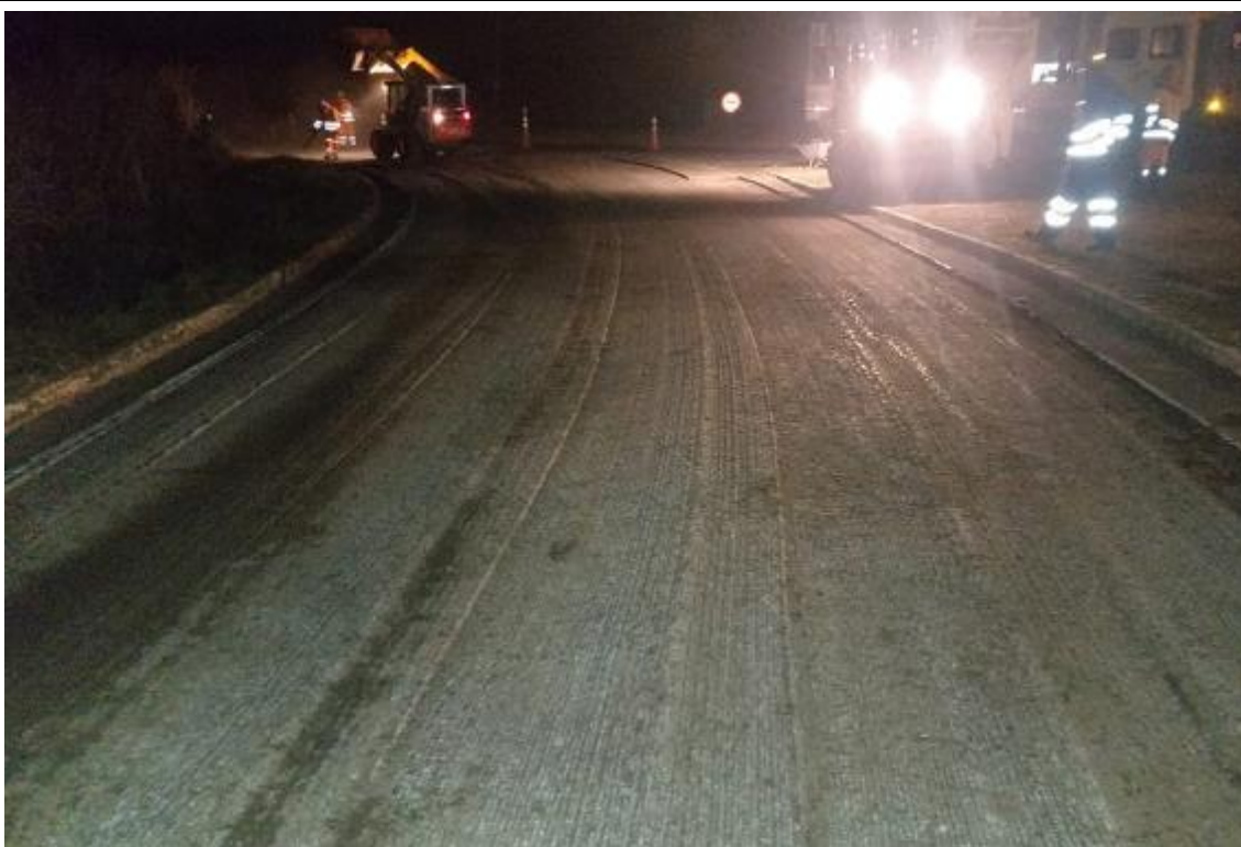
Figura 10: Execução de fresagem e recomposição com CBUQ. (BR-364) Km 434,600
