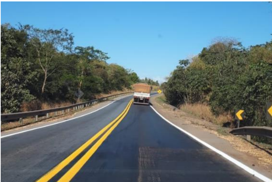
Figura 13: Revitalização de sinalização horizontal. (BR-364) Km 474
