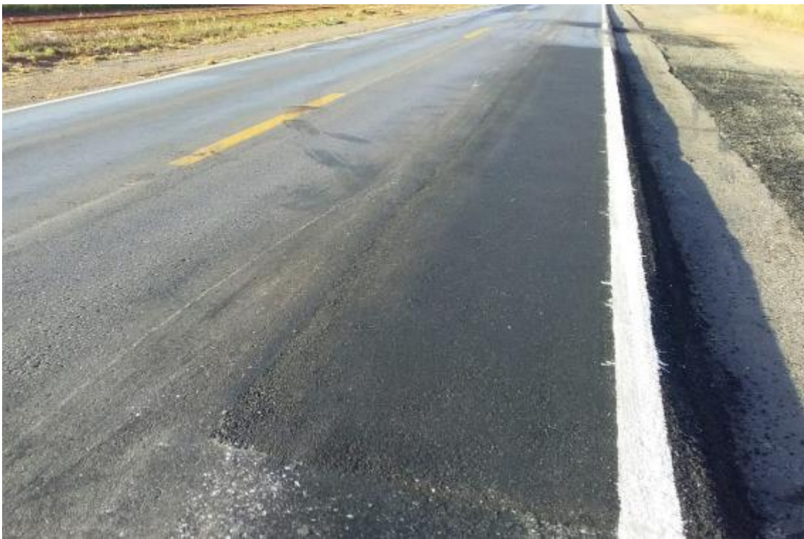
Figura 22: Execução de reparo localizado. (BR-163) Km 514,200
