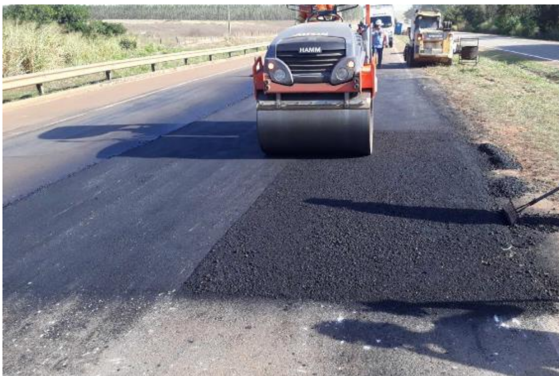
Figura 5: Execução de reparo localizado. (BR-163) Km 81,400
