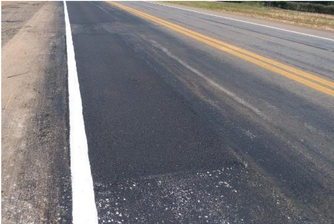
Figura 28: Execução de reparo localizado. (BR-163) Km 797,800
