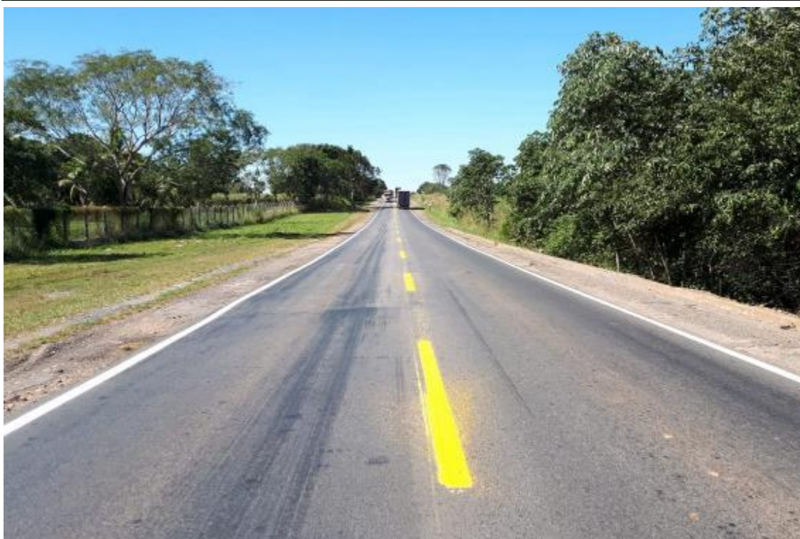
Figura 14: Revitalização de sinalização horizontal. (BR-070) Km 508
