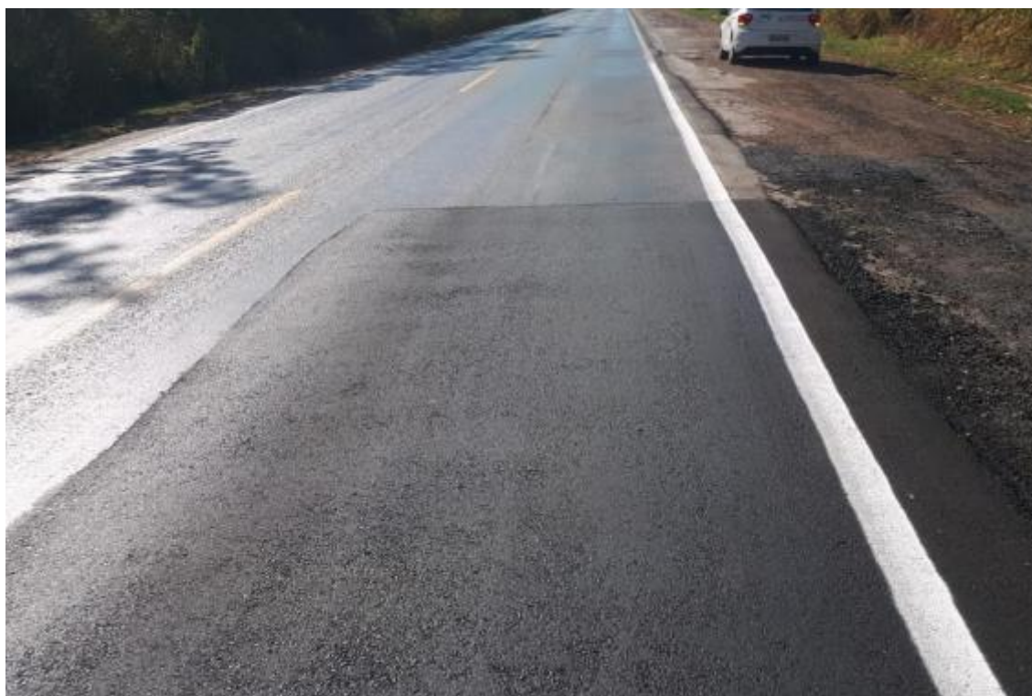
Figura 19: Execução de reparo localizado. (BR-070) Km 505,200
