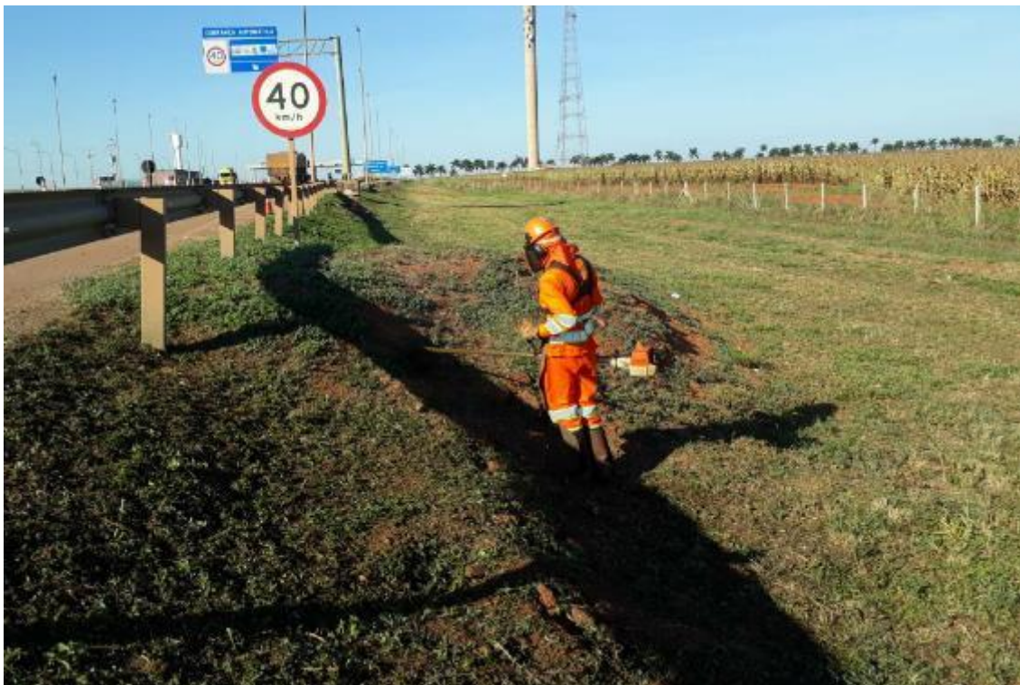
Figura 2: Execução de roçada manual. (BR-163) Km 25 ao 35
