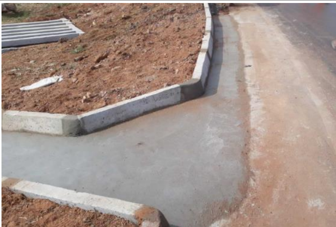
Figura 8: Recuperação de elemento de drenagem. (BR-163) Km 119
