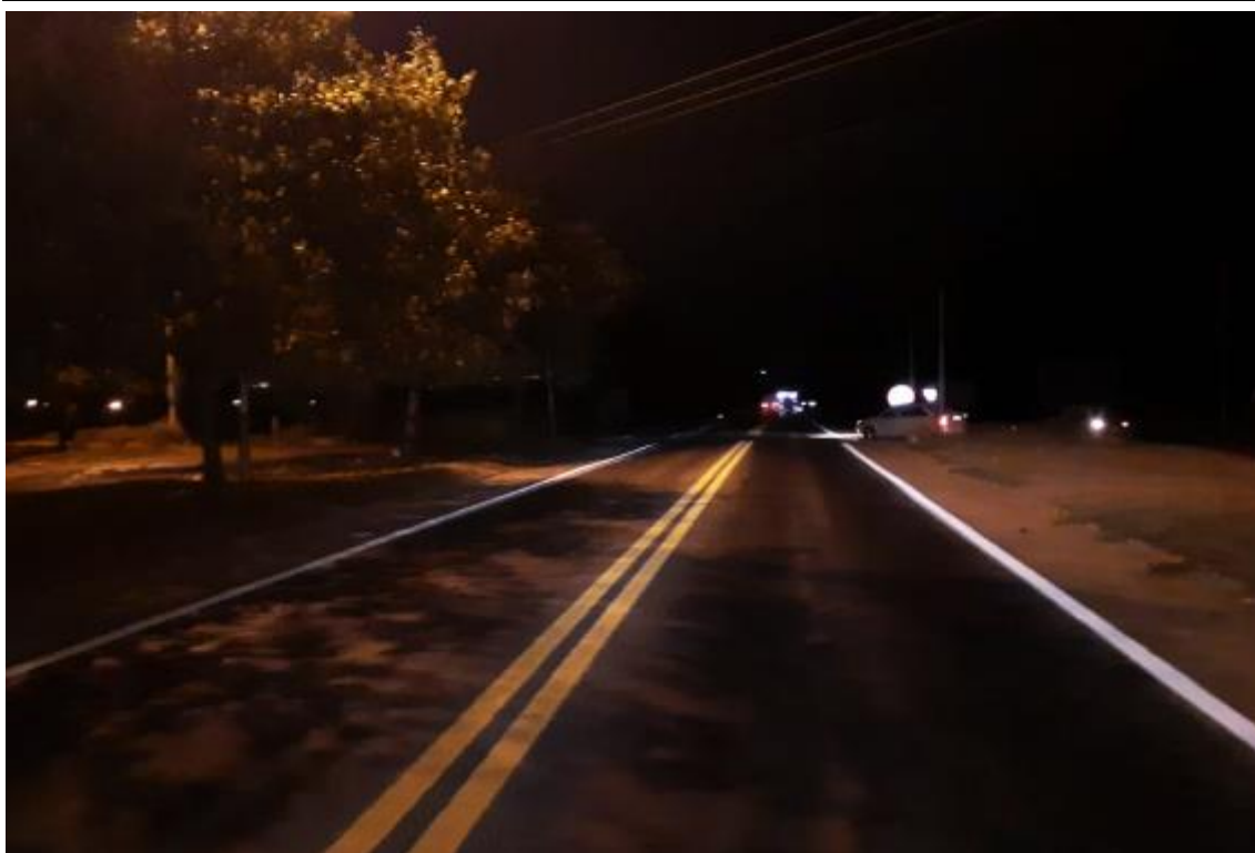
Figura 16: Revitalização de sinalização horizontal. (BR-364) Km 513 ao 514
