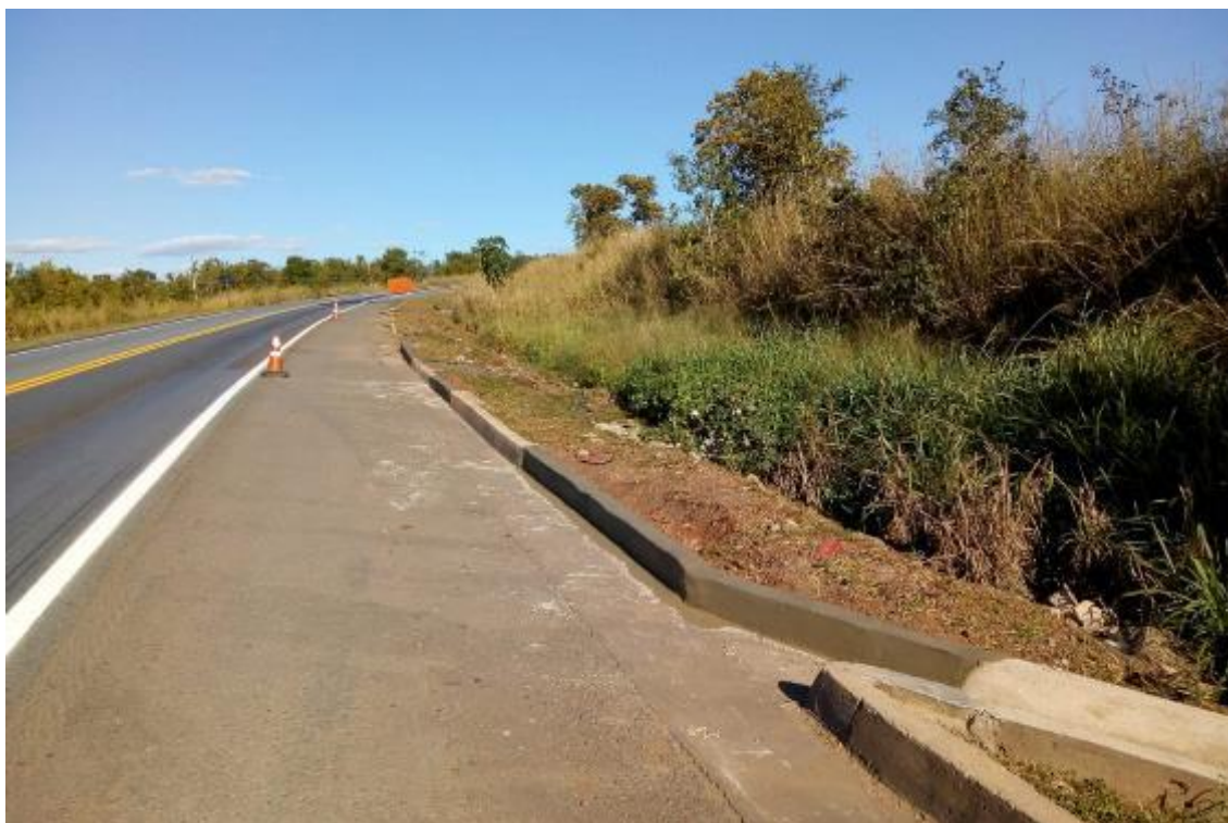
Figura 11: Recuperação de elemento de drenagem. (BR-364) Km 458,300
