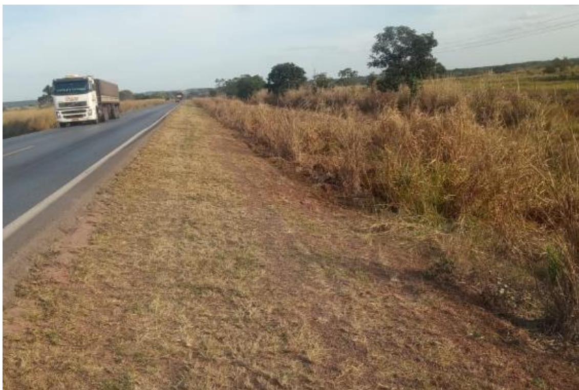
Figura 15: Execução de roçada mecânica. (BR-364) Km 510 ao 517
