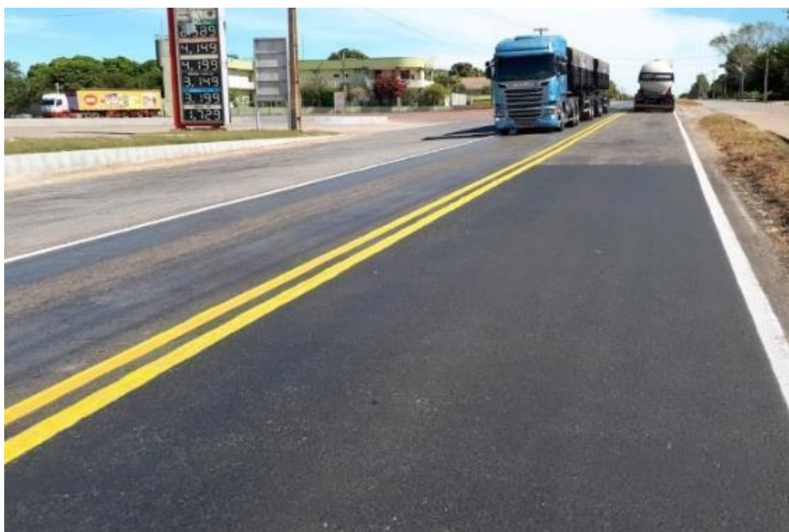
Figura 17: Execução de reparo localizado. (BR-364) Km 542,700
