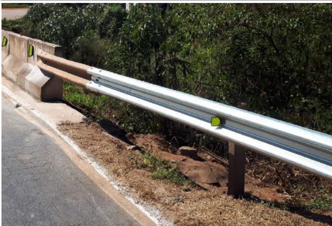
Figura 18: Substituição de defesa metálica. (BR-364) Km 543
