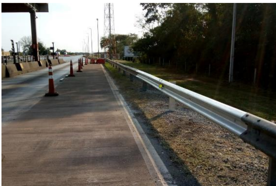
Figura 9: Substituição de defesa metálica. (BR-364) Km 383,100
