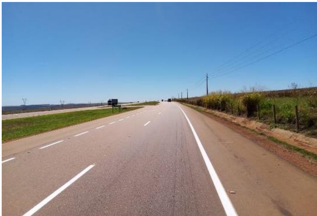
Figura 7: Revitalização de sinalização horizontal. (BR-163) Km 85
