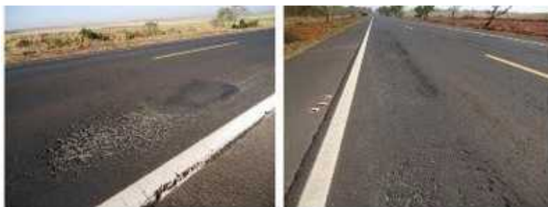
Figura 3: Exemplos de depressões com trincas e início de buracos nos km 866+470 (oeste), 842 (leste)
