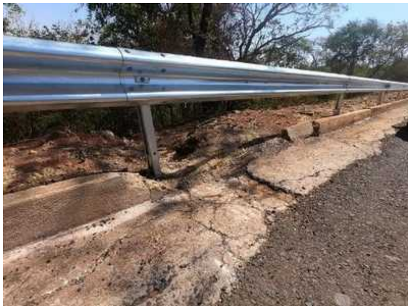
Figura 42: km 857,3 Leste - BR 365/MG - Sarjeta quebrada / ausência de saída d'água
