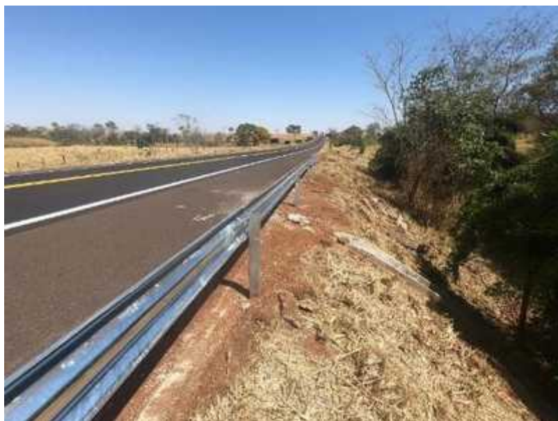
Figura 47: km 33,1 Leste/Oeste - BR 364/GO - Retirada de meio-fio em talude de aterro
