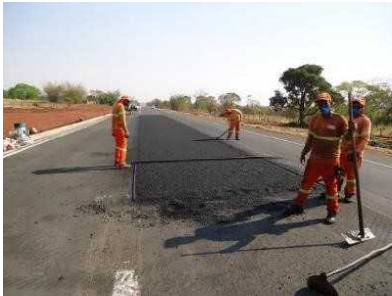
Figura 10: Reparo sem acabadora na BR-365/MG, Km 846+000 Leste, registro realizado em 10/09/2020, às 15:16
