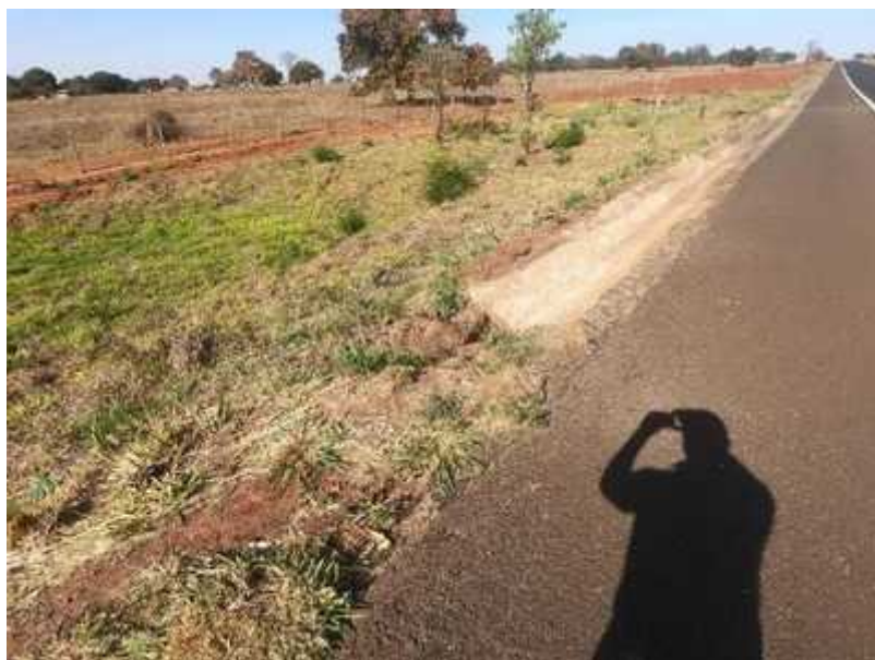
Figura 42: km 857,3 Leste - BR 365/MG - Sarjeta quebrada / ausência de saída d'água
