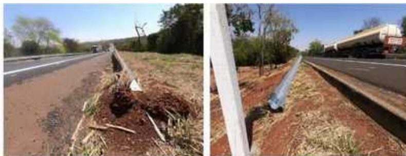
Figura 17: Ausência de atenuador de impacto em defesa metálica recém implantada (km 728,6 Oeste, e 79,6 Oeste).
