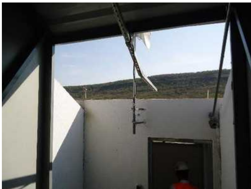
Figura 65: PP5 - Ausência de fechamento da cobertura no encontro da passarela com o prédio administrativo.
