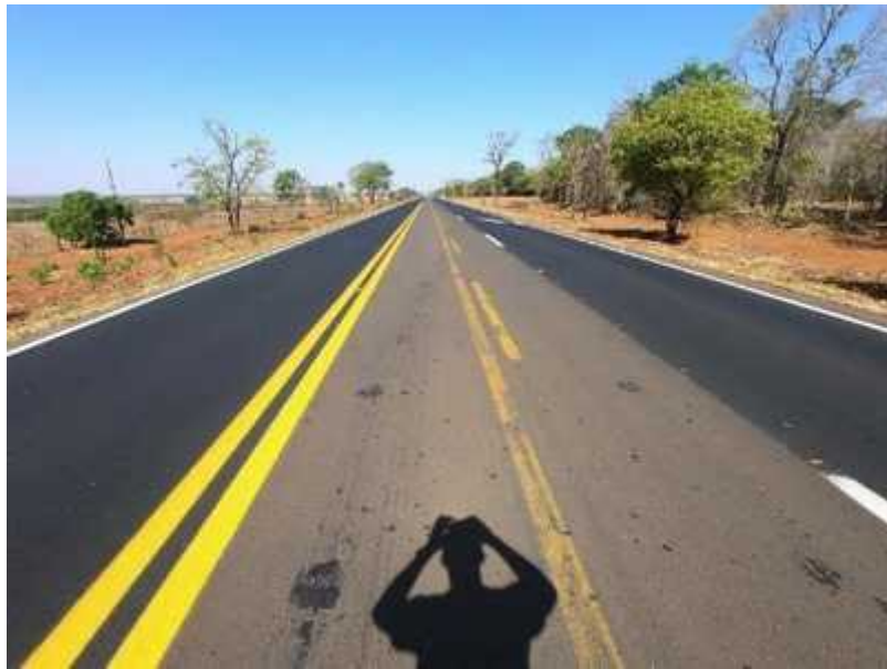
Figura 27: km 147,5 Leste - BR 364/GO - Sinalização horizontal antiga não removida
