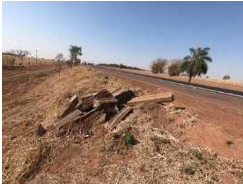
Figura 50: km 165+900 leste/oeste – Necessidade de retirar entulhos (restos de meio-fio) e realizar limpeza de materiais na faixa de domínio
