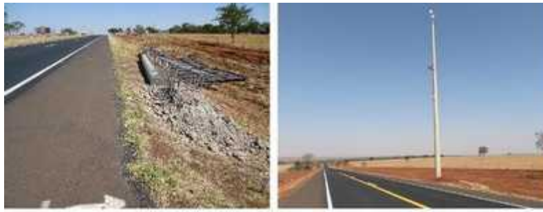
Figura 24: Ausência de defesa, obstáculos a menos de 4 metros do bordo do acostamento (km 670,89 oeste e km 120,3 leste)
