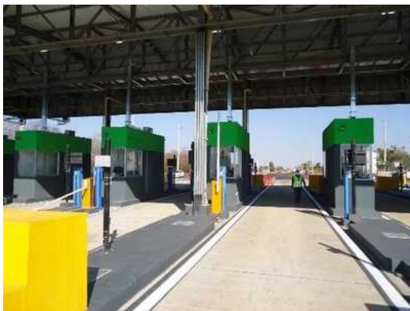
Figura 53: PP1 - Ausência de proteção (Barreira de concreto) dos pilares da PP1 nas pistas 6 e 7 em ambos os sentidos.
