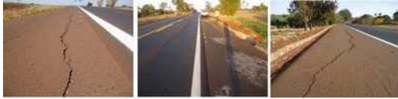
Figura 6: Exemplos de trincas em corpo de aterro nos km 758+710 (oeste), 824+150 (oeste) e 174+720 (leste)
