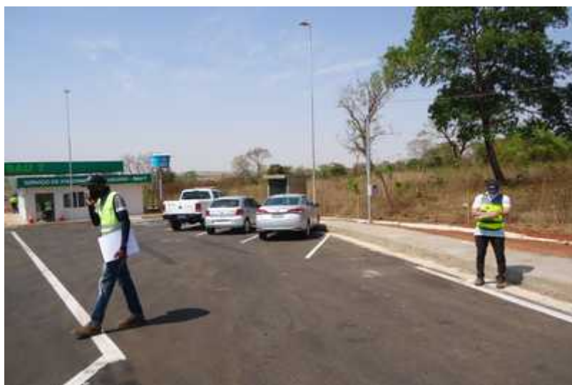
Figura 70: BSO6 - Estacionamento de caminhões com 22 metros de comprimento (projeto prevê 28 metros).
