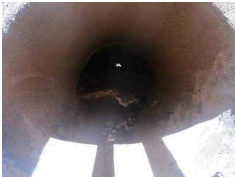
Figura 35: km 631,73 Canteiro Central - BR 365/MG – Bueiro obstruído
