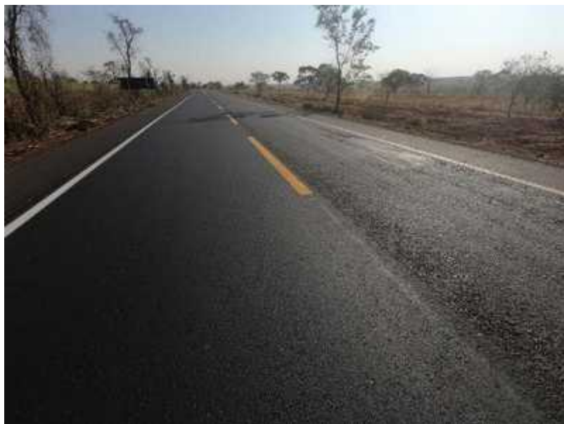
Figura 22: km 840,4 Eixo - BR 365/MG - Ausência de tacha refletiva
