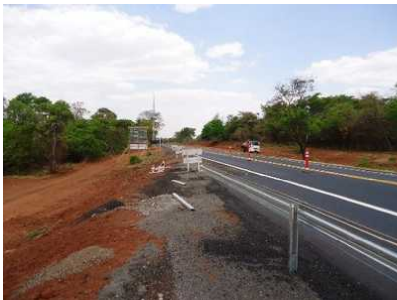
Figura 67: PP6 - Na entrada oeste, necessidade de prolongamento da defesa metálica e execução do meio fio.
