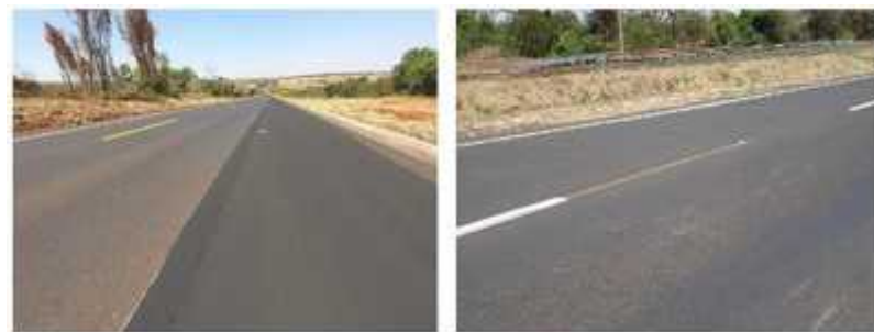
Figura 23: Sinalização horizontal deficiente (ausência de bordo de pista - km 75,0 Leste, e eixo em faixa "amarela" em pista dupla km 695,7 oeste)
