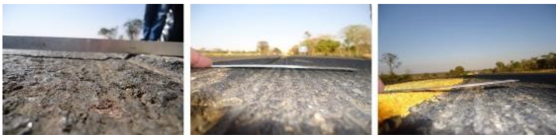
Figura 9: Desnível entre faixas contíguas nos km 104+500 (oeste), 808+830 (leste), 799+380 (leste)
