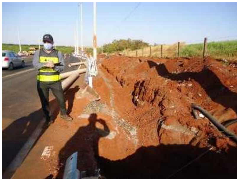
Figura 57: PP2 - Na saída leste houve alteração da solução de drenagem de Bueiro para Valeta de Proteção de Aterro - VPA e a obra ainda está em andamento. Também falta concluir o fechamento com defesa metálica.
