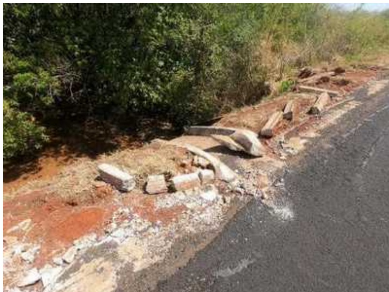
Figura 47: km 33,1 Leste/Oeste - BR 364/GO - Retirada de meio-fio em talude de aterro
