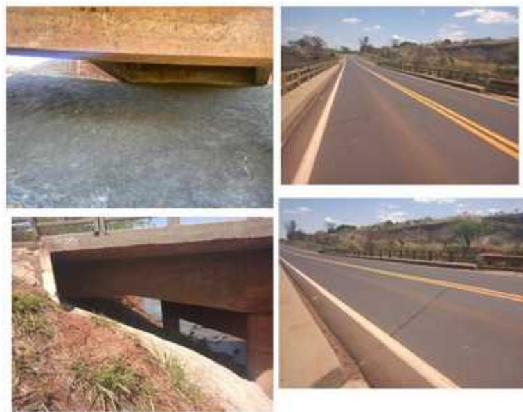
Figura 31: OAE km 754,800 depois da intervenção com detalhe para recomposição da erosão no talude - fotos apresentadas pela Ecovias do Cerrado
