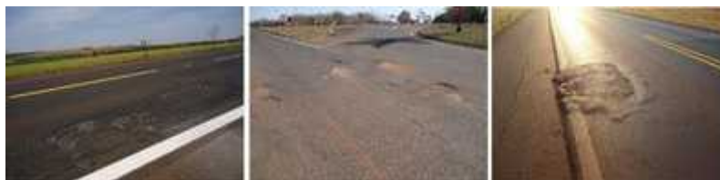
Figura 4: Exemplos de remendos mal executados nos km 712+100 (oeste), 114+330 (leste) e 769+650 (leste)
