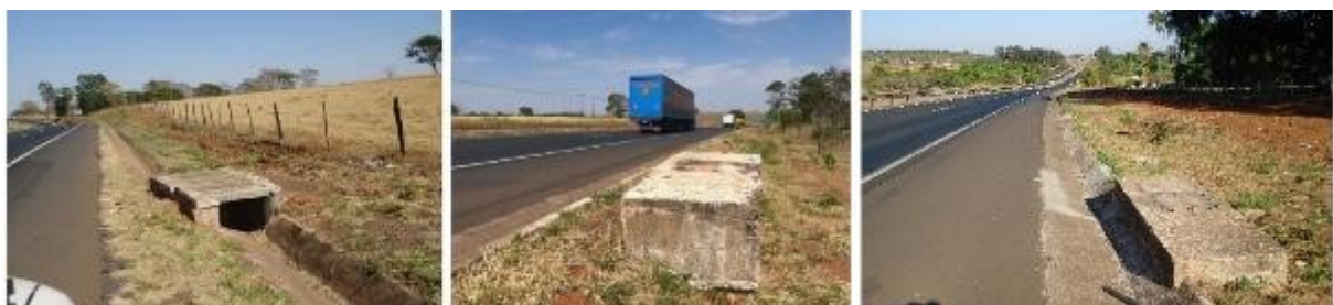
Figura 13: Obstáculos fixos a menos de 4 m do bordo do acostamento
