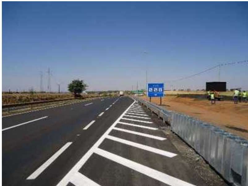
Figura 56: BSO1 - Taper de desaceleração com 160 m de comprimento - medido de sua abertura no zebrado até a New Jersey (pelas estacas no projeto, o taper possui aproximadamente 180 metros).
