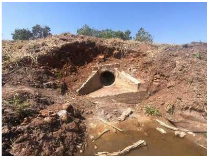
Figura 45: km 95,2 - BR 364/GO - Bueiro danificado / torto / escorado
