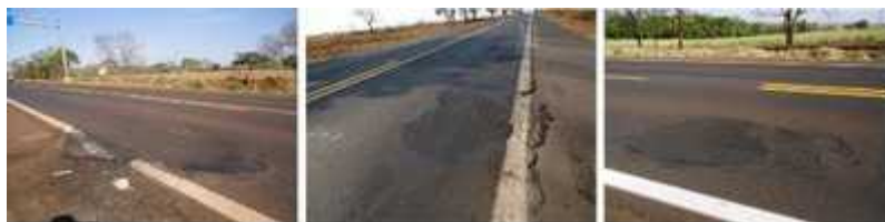
Figura 2: Exemplos de depressões nos km 767+120 (oeste), 842+700 (leste) e 777+330 (oeste)
