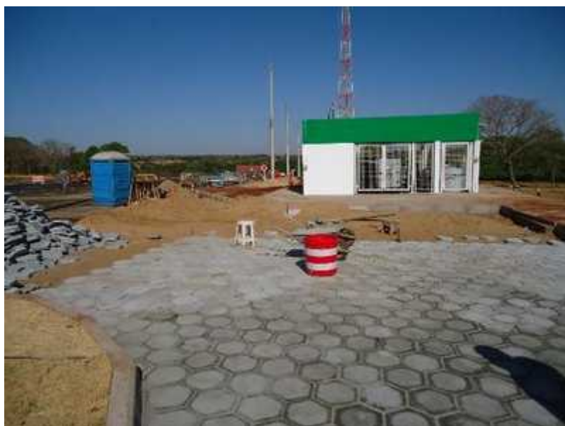
Figura 60: PP3 - Execução do piso do estacionamento em concreto intertravado em andamento.
