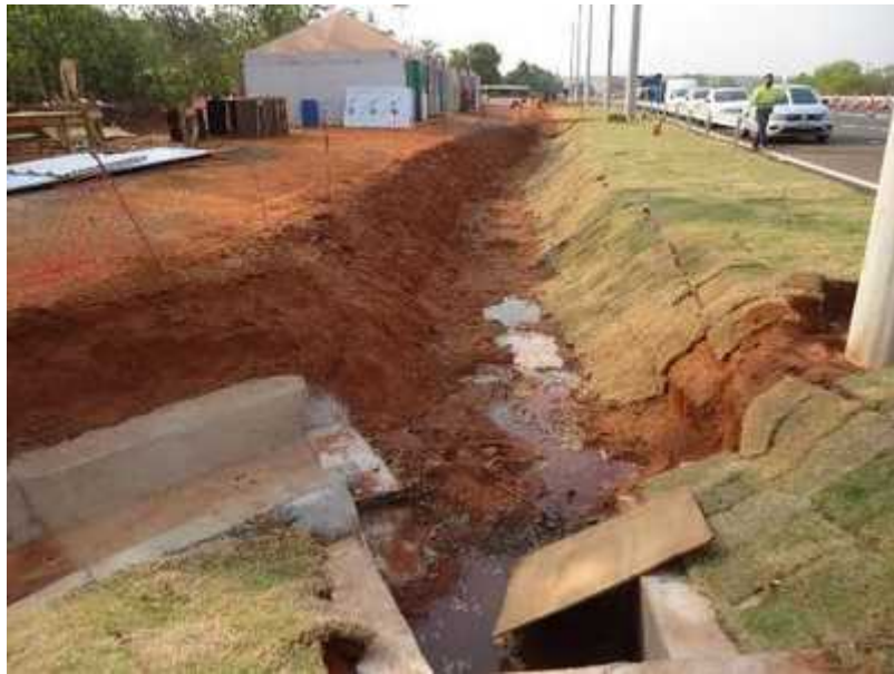
Figura 71: PP7 - Ausência de dissipador de energia e cobertura vegetal na vala de drenagem.
