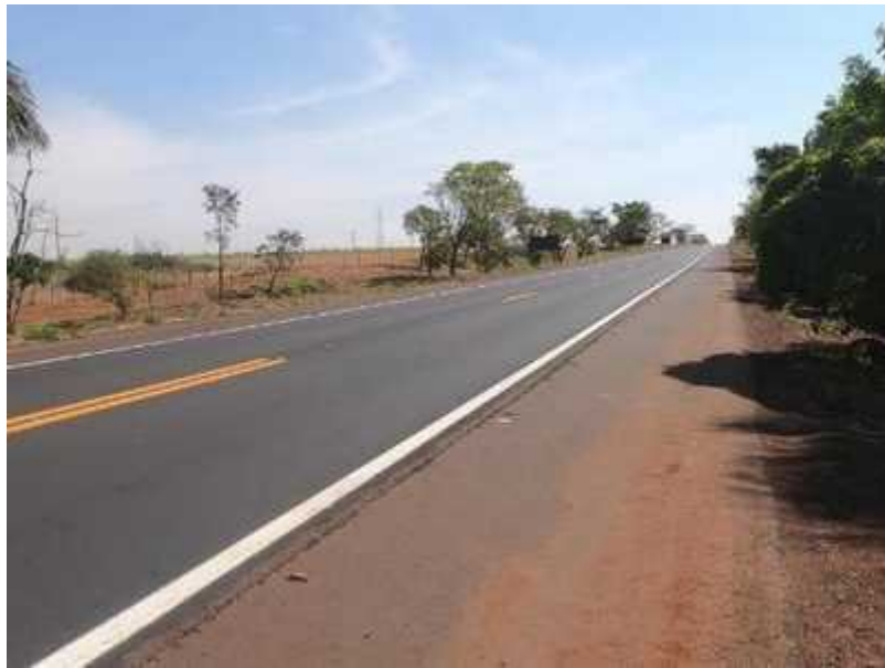
Figura 29: Cadência da sinalização horizontal de permissão de ultrapassagem desconforme ao Manual de Sinalização do DNIT
