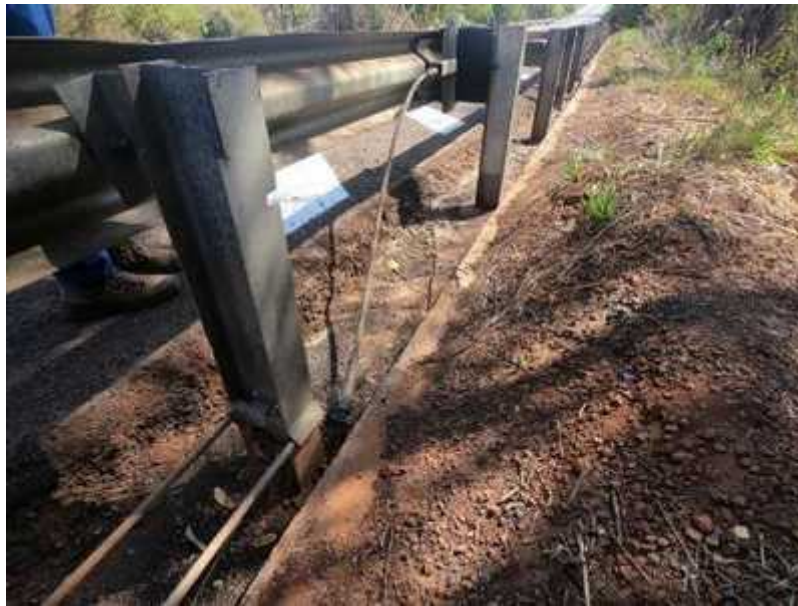
Figura 25: km 126,1 Leste/Oeste - BR 364/GO - Atenuador do tipo x-lite danificado sem fixação de cabo de ancoragem
