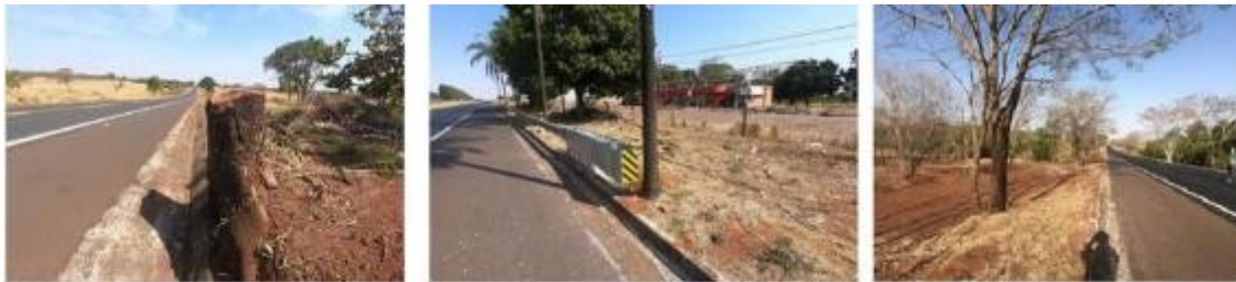
Figura 14: Toco de árvore ou árvores a menos de 4 m do bordo do acostamento.
