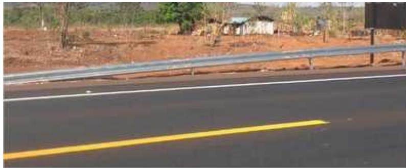
Figura 12: Defesa metálica com terminal de saída ancorado, mesmo podendo ser impactado no sentido oposto
