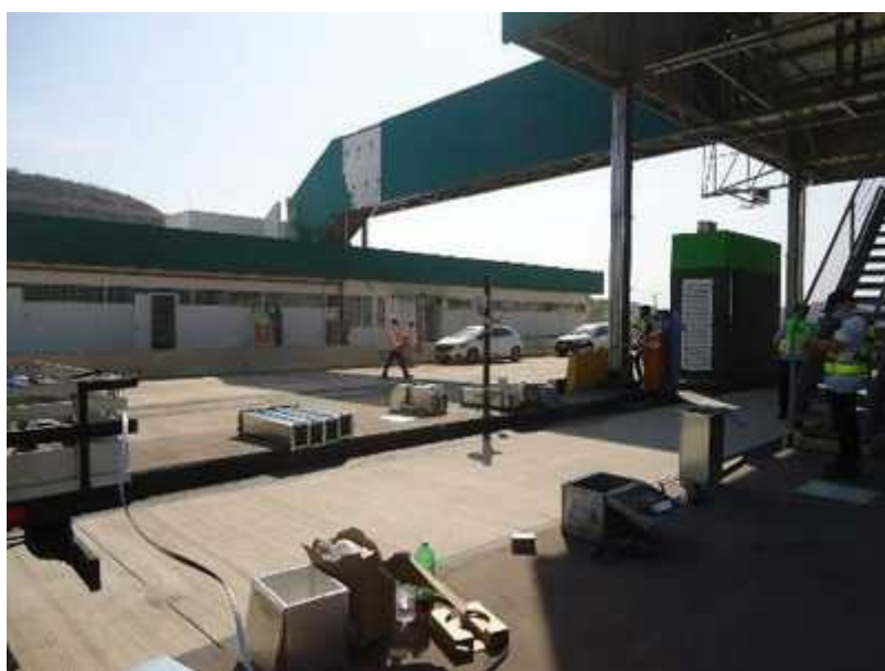
Figura 66: PP5 - Ausência do gradil e do dispositivo "passa 1" entre a pista AVI e a Mista.
