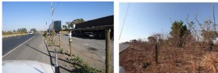
Figura 15: Exemplos de cercas a menos de 4 m do bordo externo do acostamento
