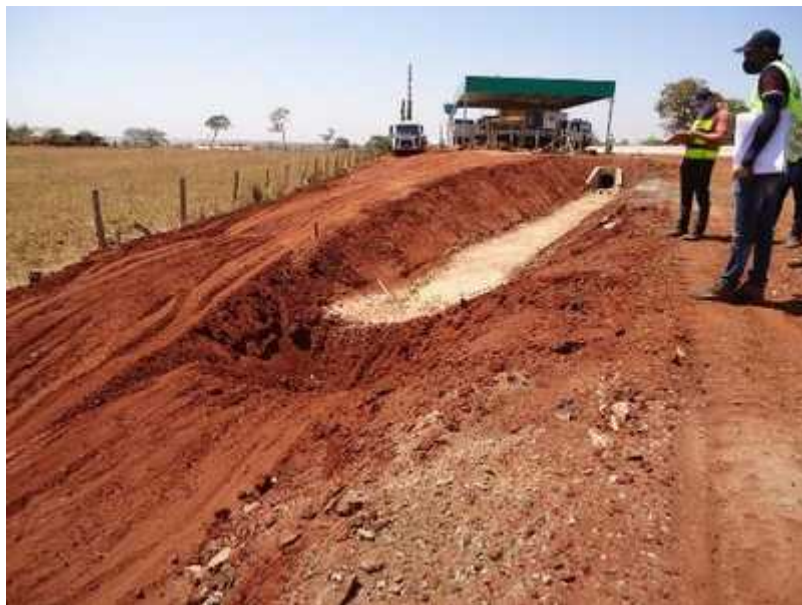
Figura 61: BSO4 - Execução da drenagem ainda em andamento.
