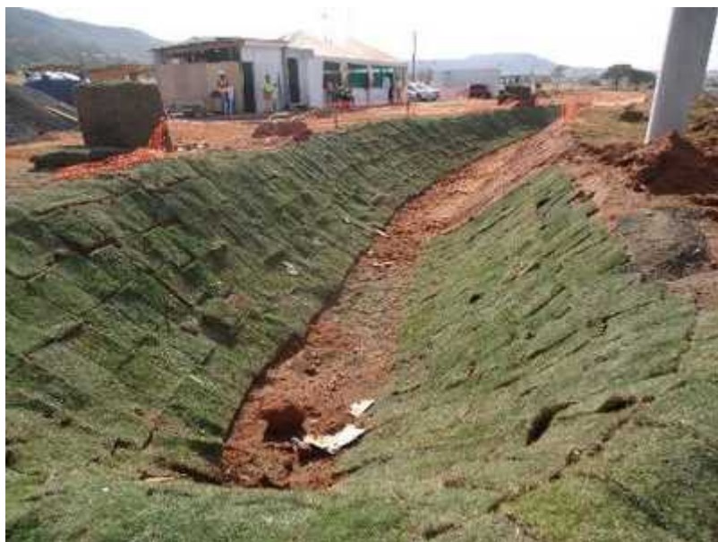
Figura 63: PP5 - Ausência de dissipador de energia e recobrimento vegetal no fundo da vala.
