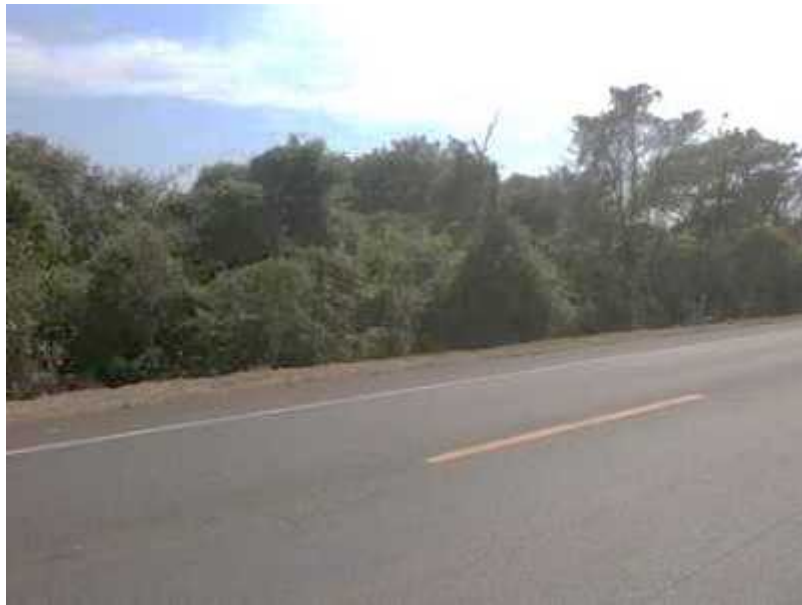
Figura 51: km 815+000 ao 814+100 oeste – roçada inadequada, impossibilitando visualizar eventual cerca delimitadora ou aceiro da faixa de domínio.
