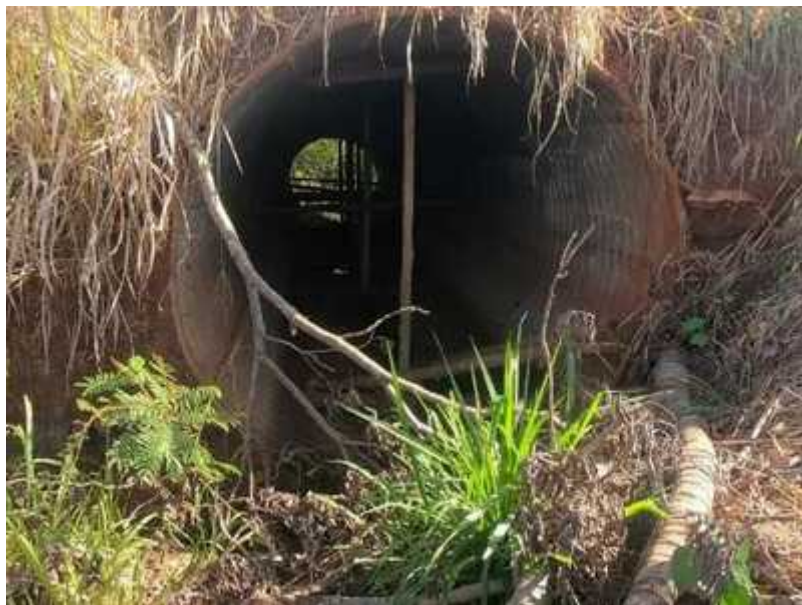
Figura 41: km 857,24 Leste/Oeste - BR 365/MG - Bueiro Armco danificado
