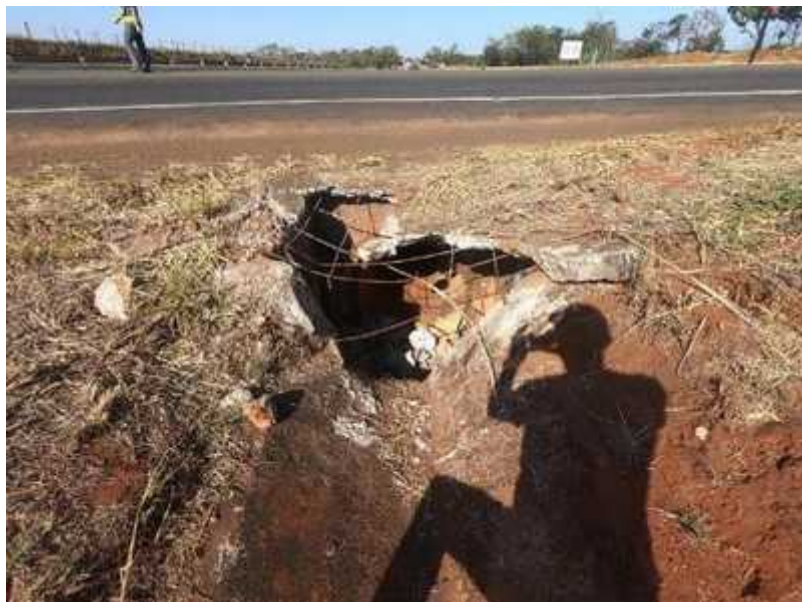
Figura 37: km 678,1 CC - BR 365/MG - Sarjeta quebrada
