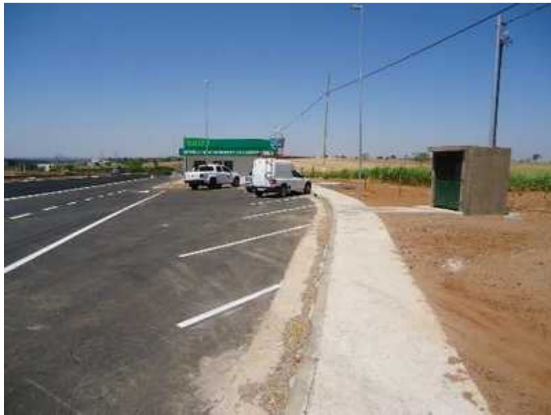
Figura 55: BSO1 - Geometria do estacionamento de automóveis da BSO em desacordo com o projeto aprovado, permitindo apenas 5 vagas utilizáveis.
