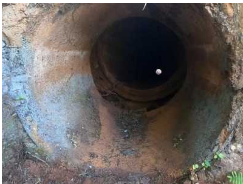
Figura 40: km 844,22 Oeste - BR 365/MG - Bueiro rompido
