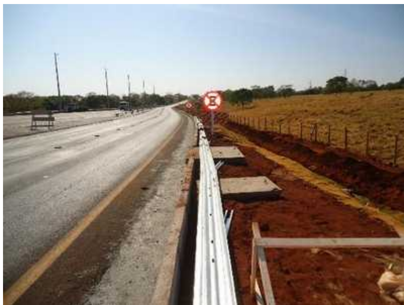
Figura 59: PP3 - Elemento de proteção e segurança (defensa metálica) não instalado.
