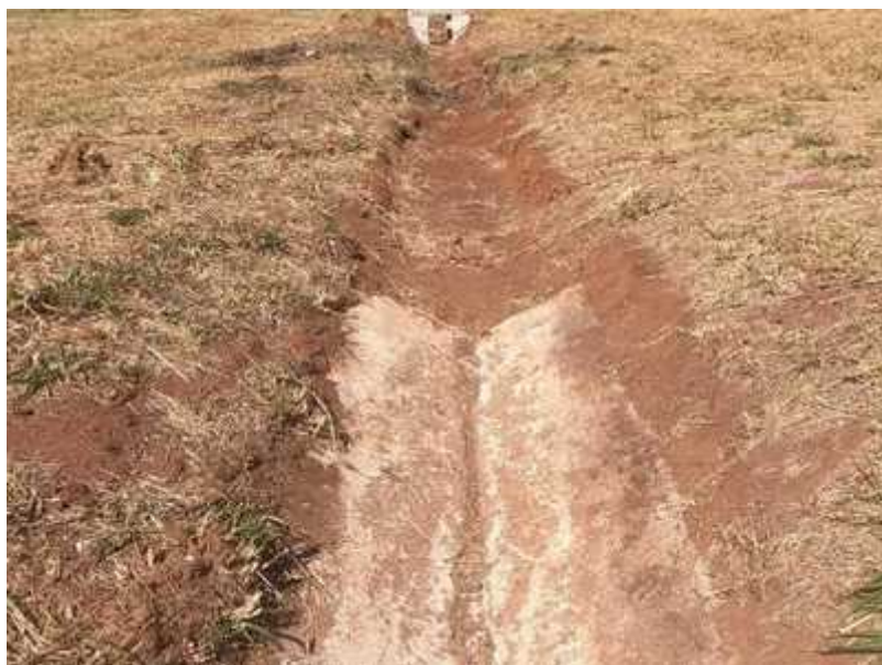
Figura 37: km 678,1 CC - BR 365/MG - Sarjeta quebrada
