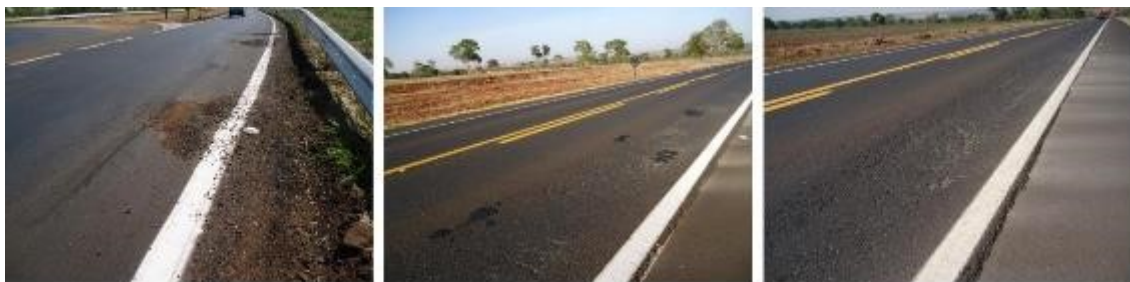
Figura 11: Pavimento recém recuperado com depressões/abaulamentos/trincas
