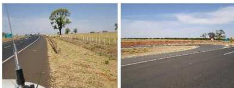
Figura 19: km 672,7 leste (ausência de MP em defesa) e km 692,95 canteiro central (ausência de Marcadores de Alinhamento em retorno em nível)
