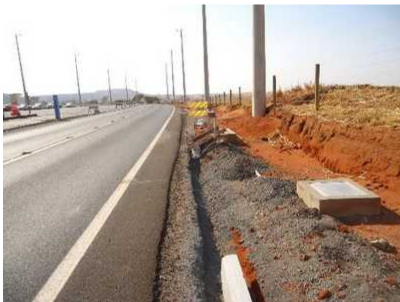
Figura 64: PP5 - Execução de meio fio em andamento.
