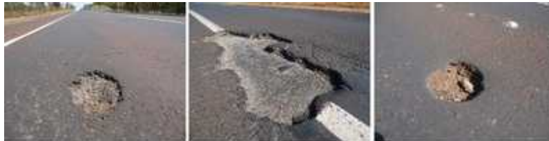
Figura 1: Exemplos de buracos nos km 711+060 (oeste), 677+450 (leste) e 661+050 (leste)
