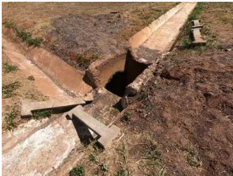
Figura 36: km 648,2 CC - BR 365/MG - Caixa sem tampa/ tampa danificada
