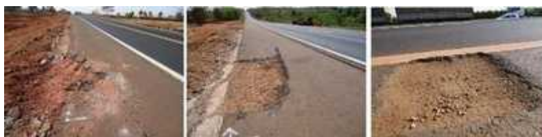
Figura 5: Exemplos de acostamentos danificados nos km 8+840 (oeste), 47+450 (leste) e 701+150 (leste)
