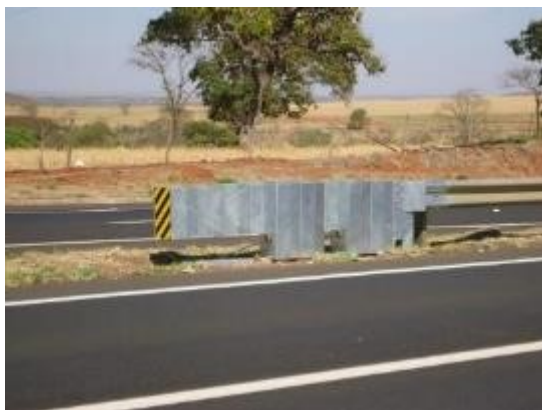
Figura 16: Atenuador de impacto para 80 km/h, implantado na faixa 1, em local regulamentado para 110 km/h
