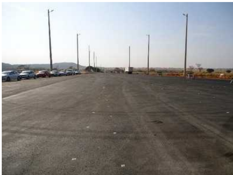
Figura 62: PP5 - Ausência de sinalização horizontal na aproximação da praça.
