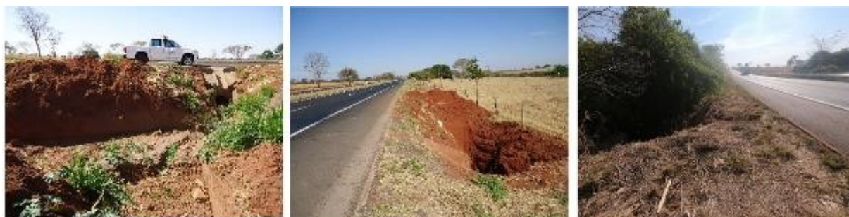
Figura 19: km 672,7 leste (ausência de MP em defesa) e km 692,95 canteiro central (ausência de Marcadores de Alinhamento em retorno em nível)
