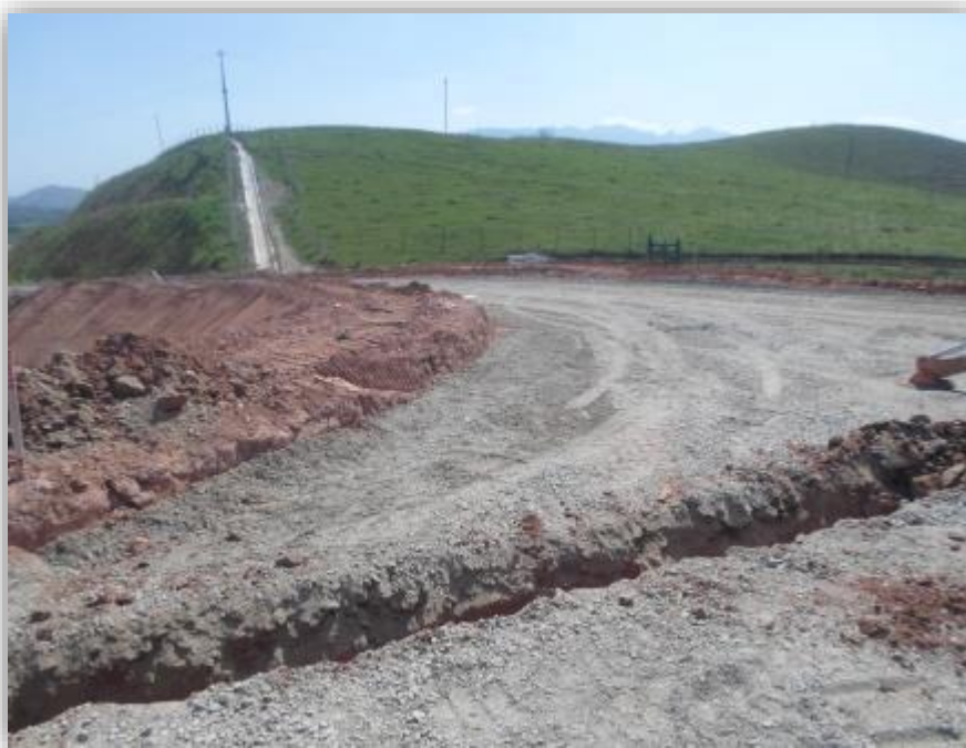
Figura 04 – Execução de Dreno Sub-Superficial - km 253,600
