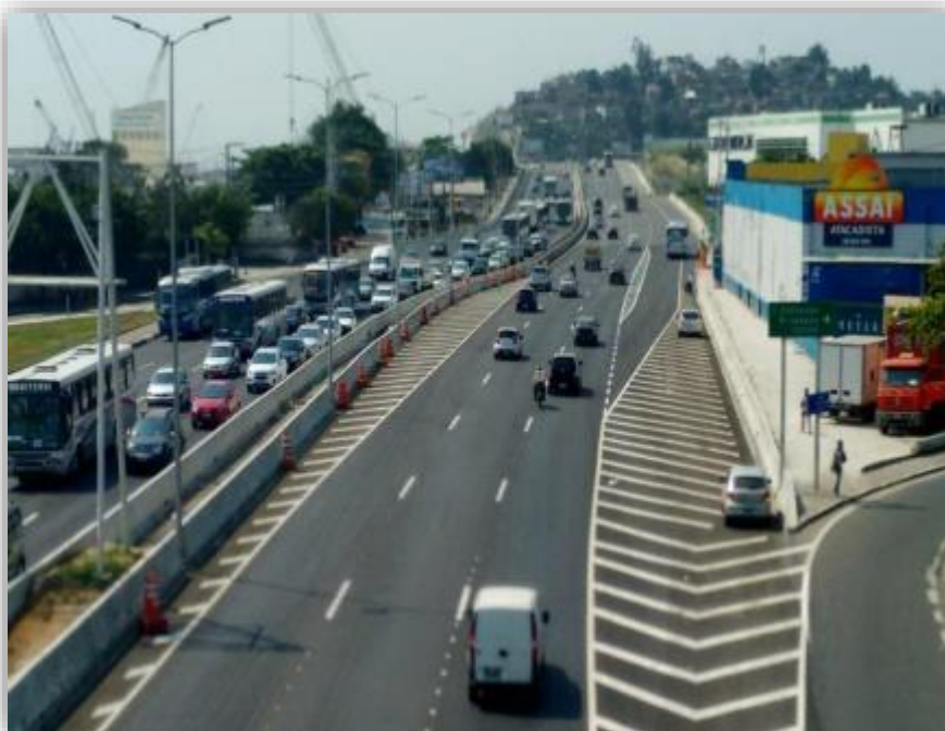
Figura 01 – Sinalização Horizontal, New Jersey e Passeio
