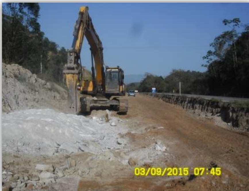
Figura 03 – Desmonte de Rocha com Rompedor
