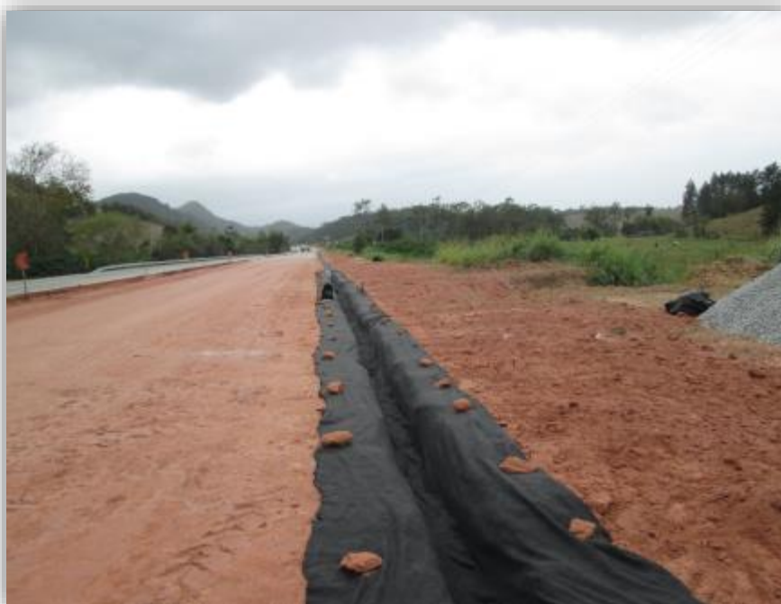
Figura 04 – Dreno de Pavimento
