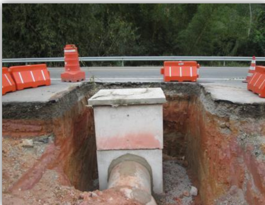
Figura 02 – Implantação de Caixa de Passagem
