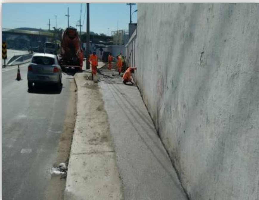
Figura 02 – Execução de Passeio
