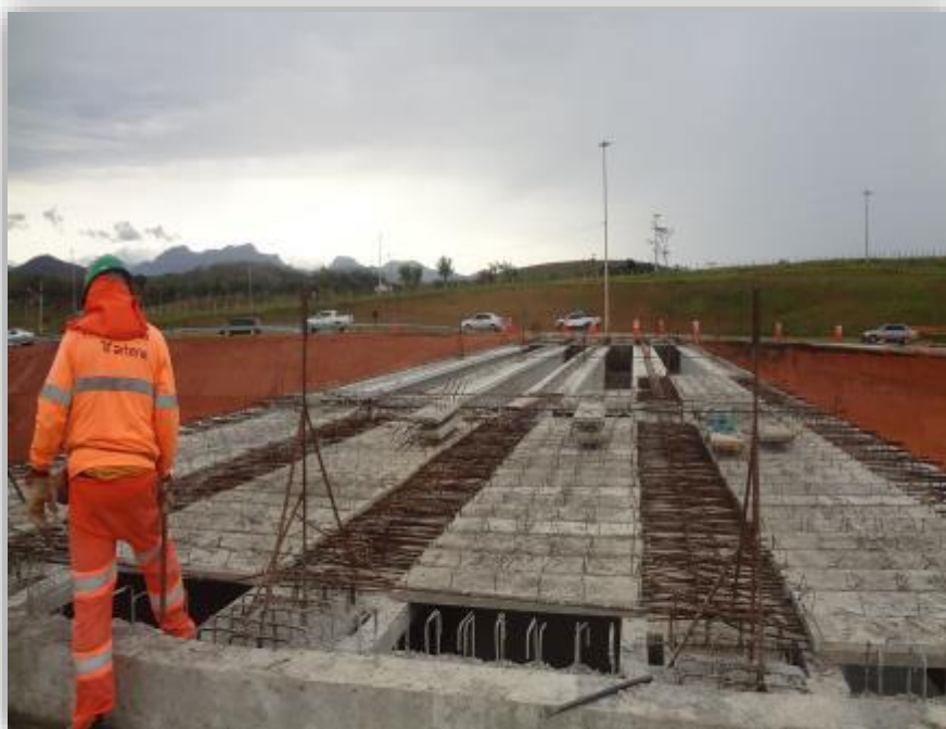
Figura 03 – Lançamento das Pré-Lajes do Viaduto - km 144,500
