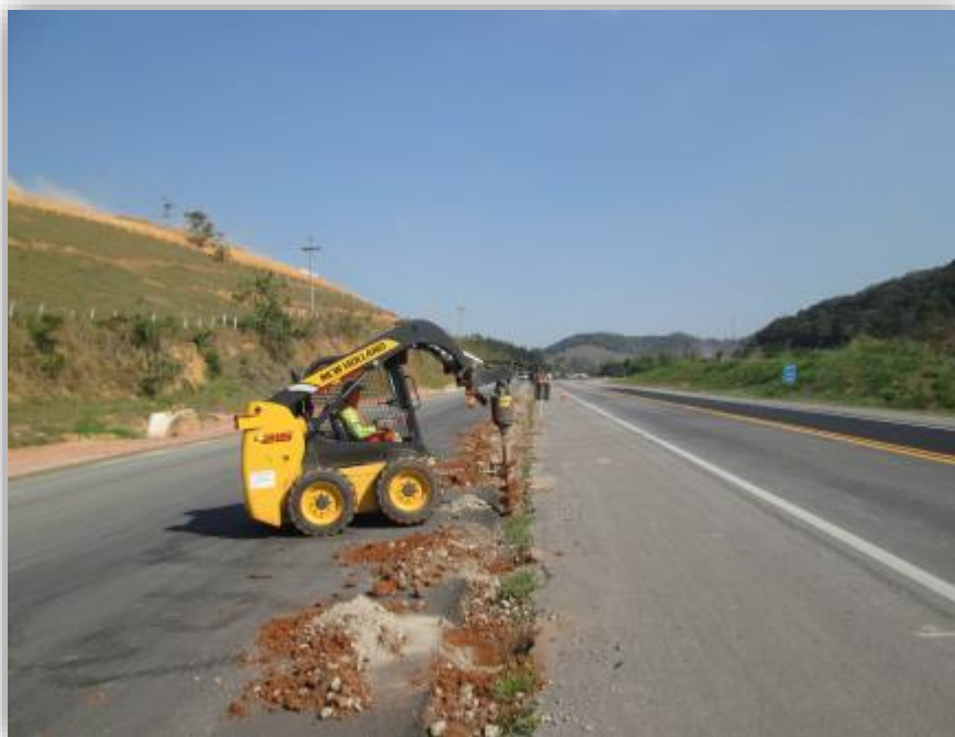
Figura 01 – Escavação de Base e Broca
