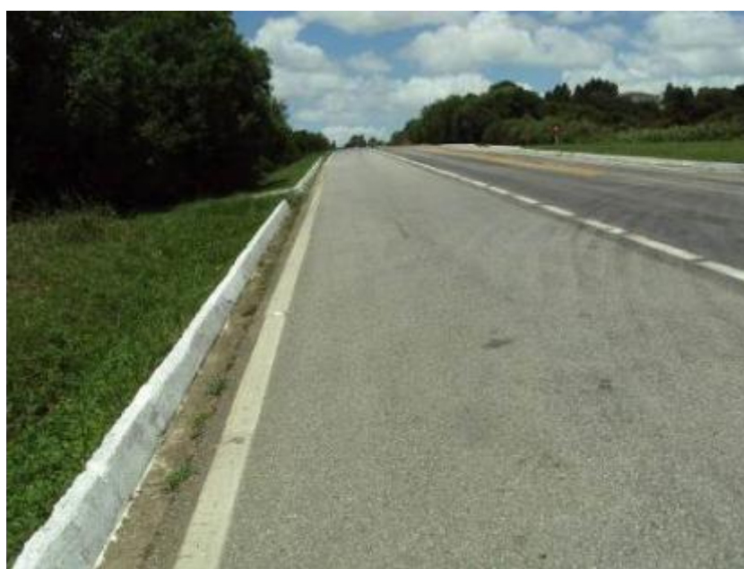
Figura 05 – Pintura drenos de Pavimento
