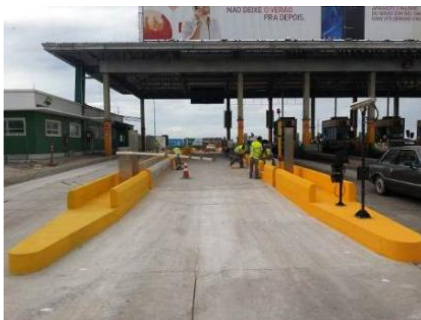
Figura 09 – Ampliação da Praça de Pedágio Capão Seco
