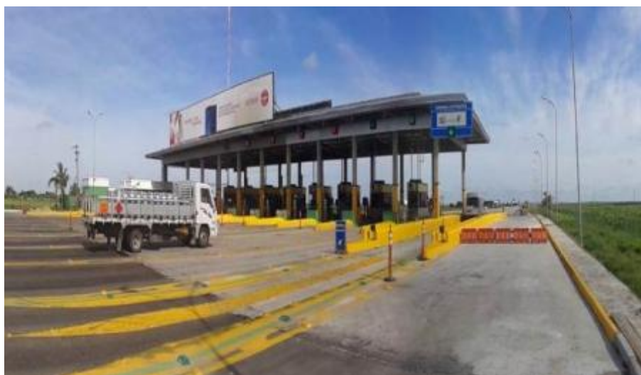
Figura 07 – Ampliação da Praça de Pedágio Capão Seco
