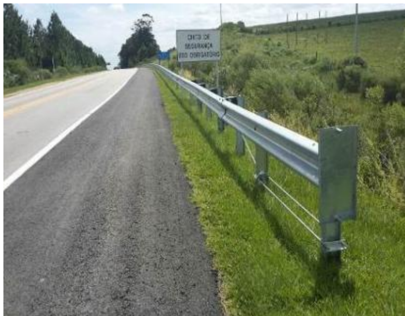
Figura 06 – Implantação Defensas Metálicas
