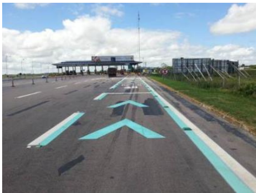
Figura 08 – Ampliação da Praça de Pedágio Capão Seco
