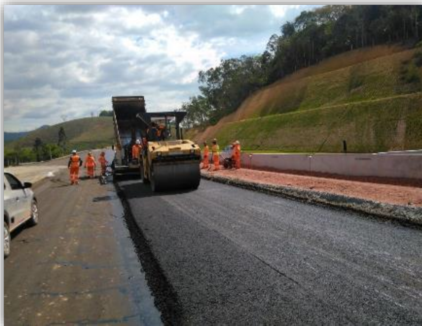
Figura 01 – Aplicação de massa CBUQ
