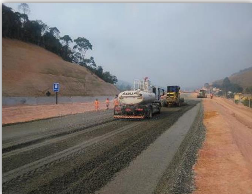
Figura 04 – Execução da camada de base – km 248,1
