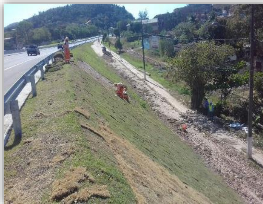
Figura 02 – Revestimento com placas de grama
