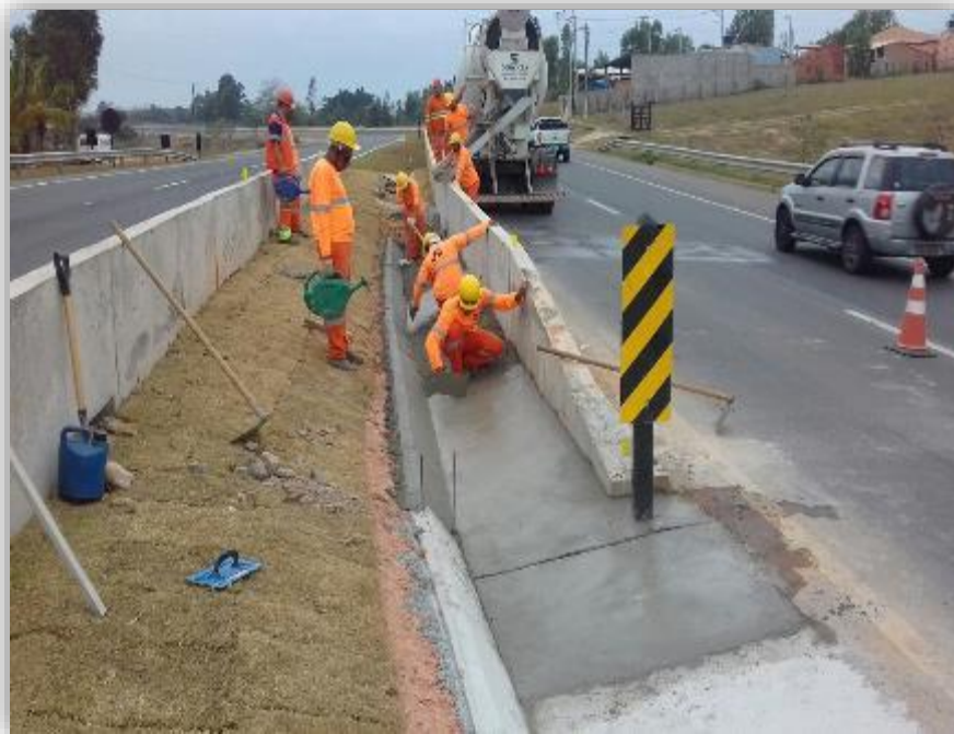
Figura 01 – Concretagem de STC 01
