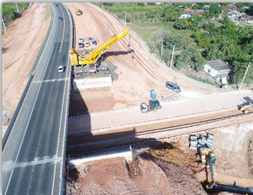
Figura 03 – Montagem de Guindaste para lançamento de vigas – km 244
