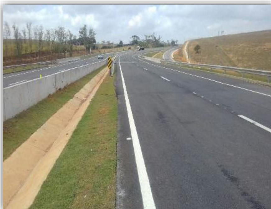
Figura 02 – Execução de canteiro central
