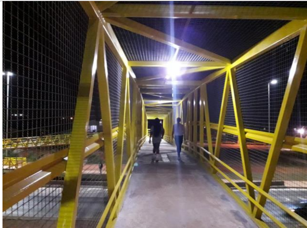
Foto 03: Passarela em utilização
