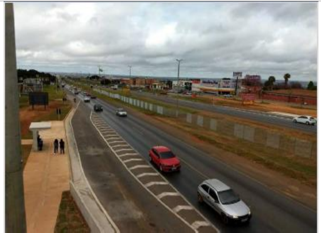
Foto 04: Baía Norte e abrigo finalizados
