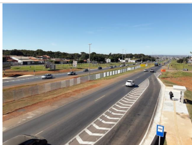
Foto 01: Tela antiofuscante instalada
