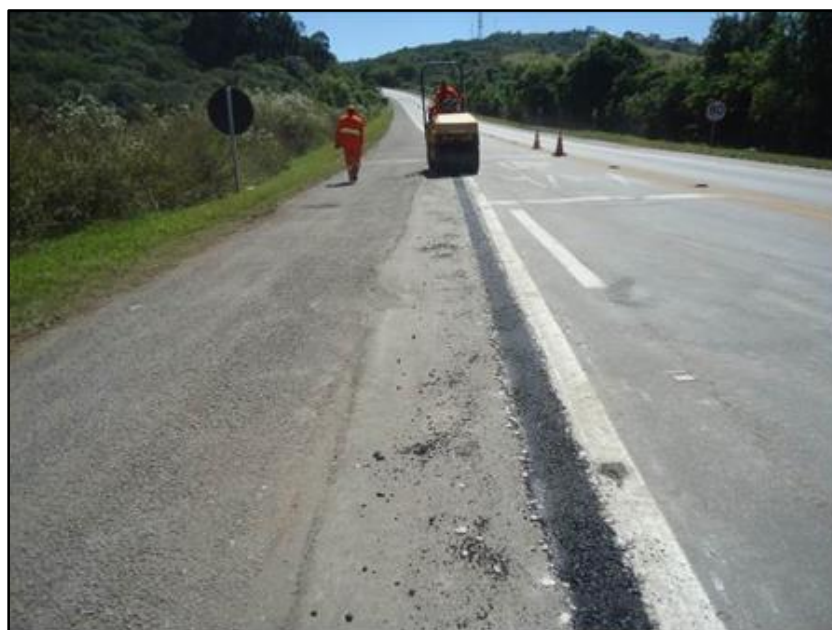
Figura 05 – Implantação drenos de pavimento – BR-392/RS
