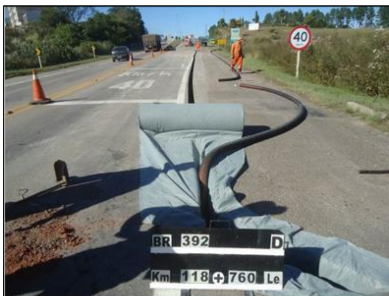
Figura 04 – Implantação drenos de pavimento – BR-392/RS
