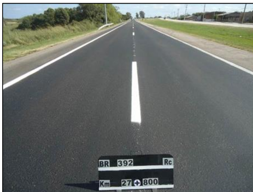
Figura 02 – Manutenção do Pavimento – BR-392/RS
