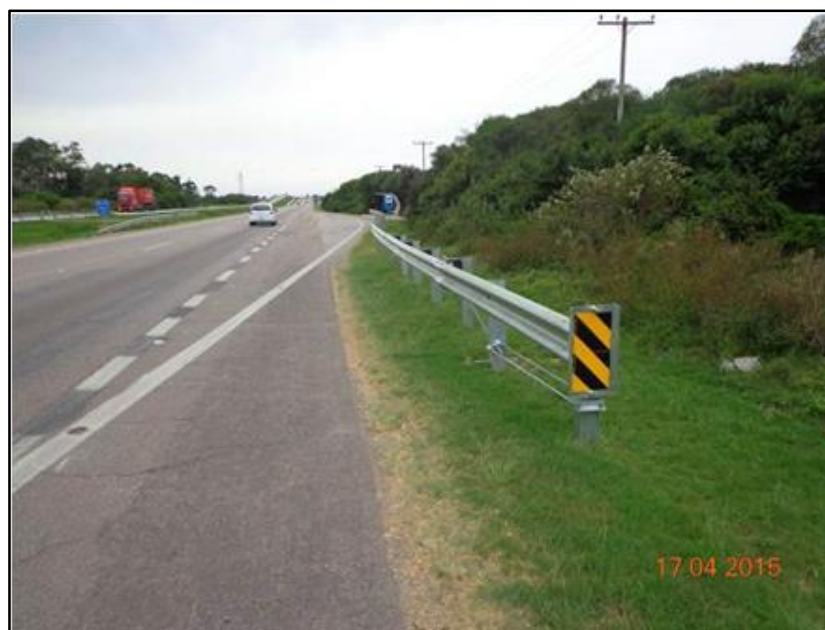
Figura 06 – Defensas Metálicas – BR-392/RS
