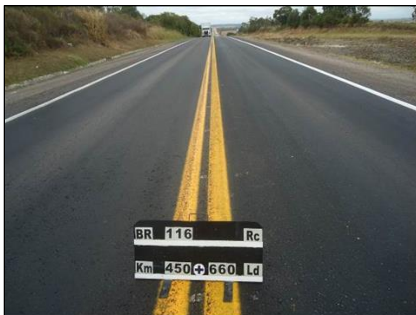
Figura 03 – Manutenção do Pavimento – BR-116/RS
