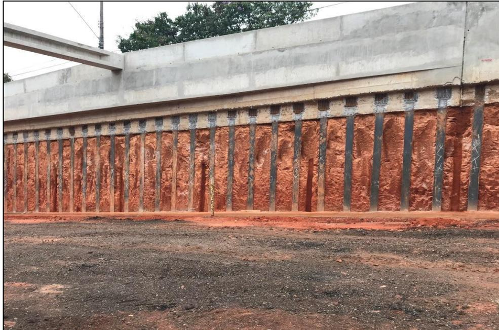
*Figura 05 – Preparação para instalação da drenagem vertical*
