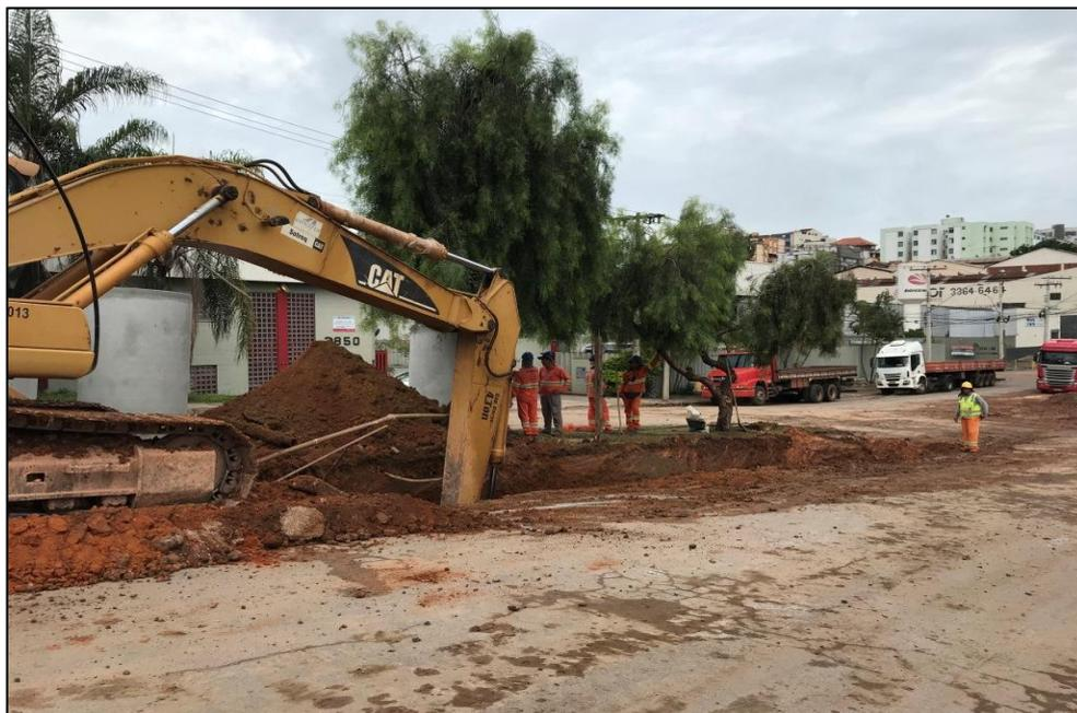
*Figura 02 – Escavação para instalação da drenagem subterrânea*
