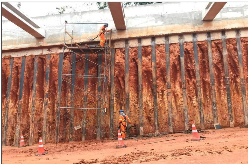
*Figura 06 Preparação para instalação da drenagem vertical*
