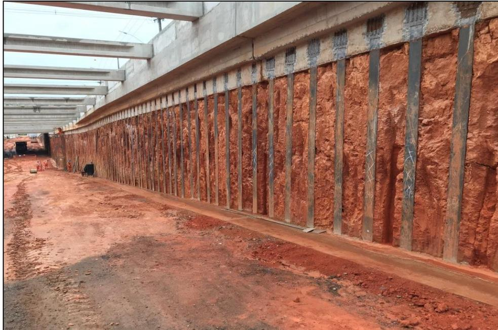
*Figura 03 – Viga lateral inferior terminada*
