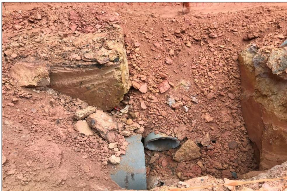
*Figura 04 – Escavação para instalação do poço de visita*
