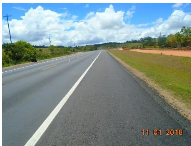
Figura 03 – Recomposição de acostamentos BR-116 km 421+000 ao 425+000
