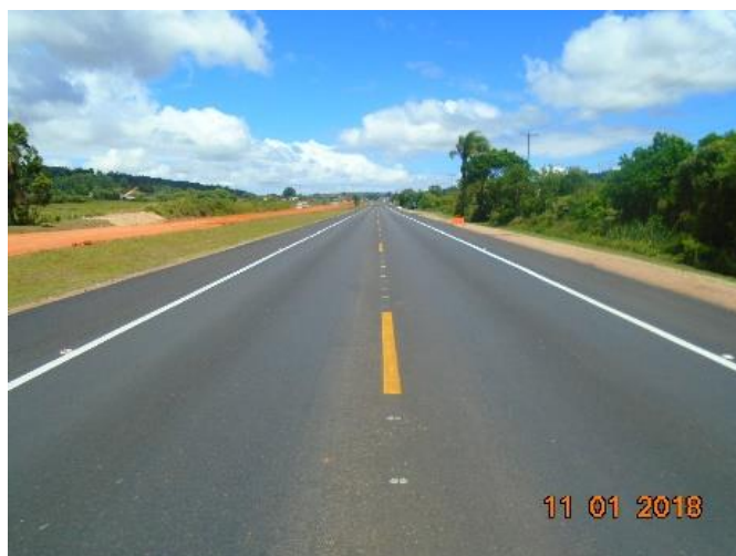
Figura 02 – Serviços de recuperação do pavimento BR-116 km 452+900 ao 457+200
