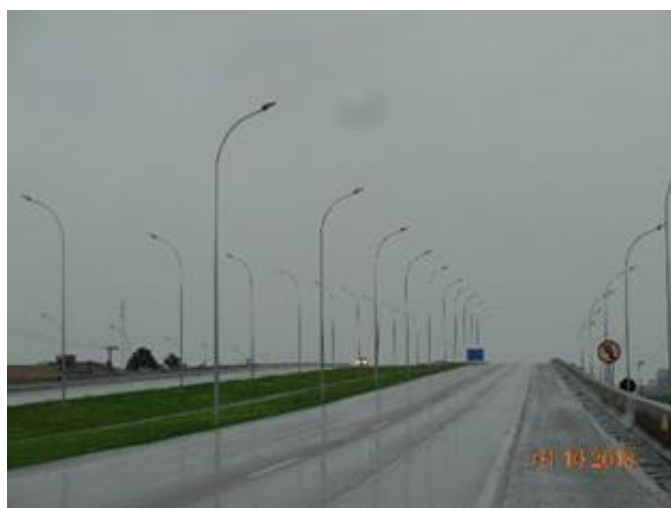
Figura 03 – Serviços de iluminação no Viaduto Vila Princesa (Em andamento) BR-116 – km 514+000
