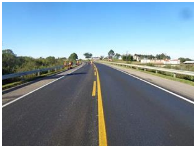
Figura 02 – Serviços de recuperação do pavimento BR-392 – km 141+000 ao 143+900
