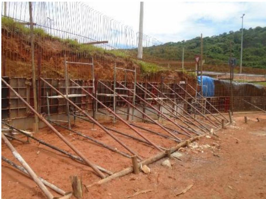
*Figura 02 – Montagem das formas para execução do muro de contenção*
