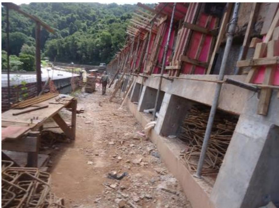
*Figura 02 – Montagem das armações e formas dos pilares*
