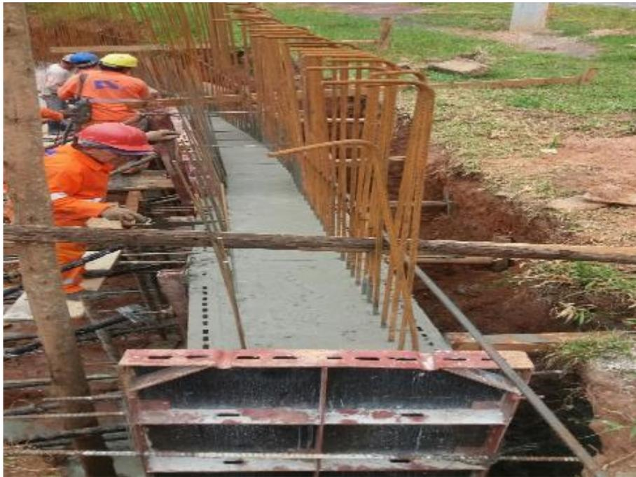
*Figura 05 – Concretagem do muro de contenção*
