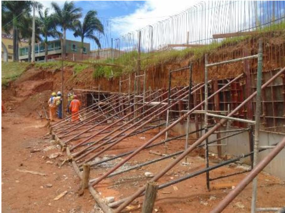
*Figura 01 – Montagem das formas para execução do muro de contenção*
