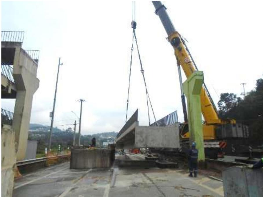
*Figura 03 – Implantação da nova travessia*
