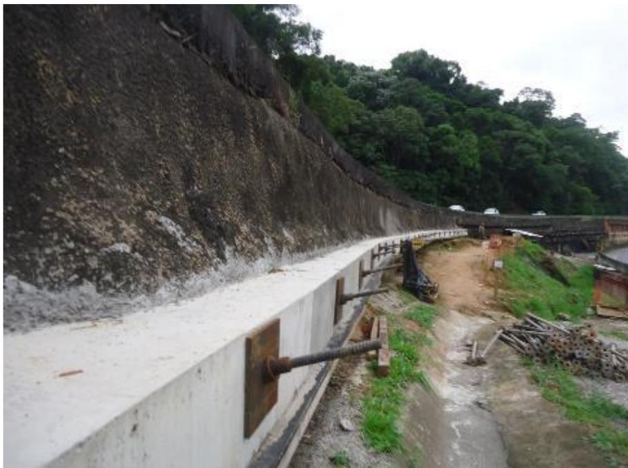
*Figura 01 – Viga de coroamento finalizada*
