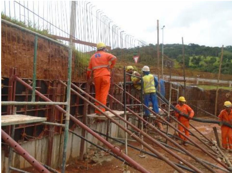
*Figura 03 – Montagem das formas para execução do muro de contenção*
