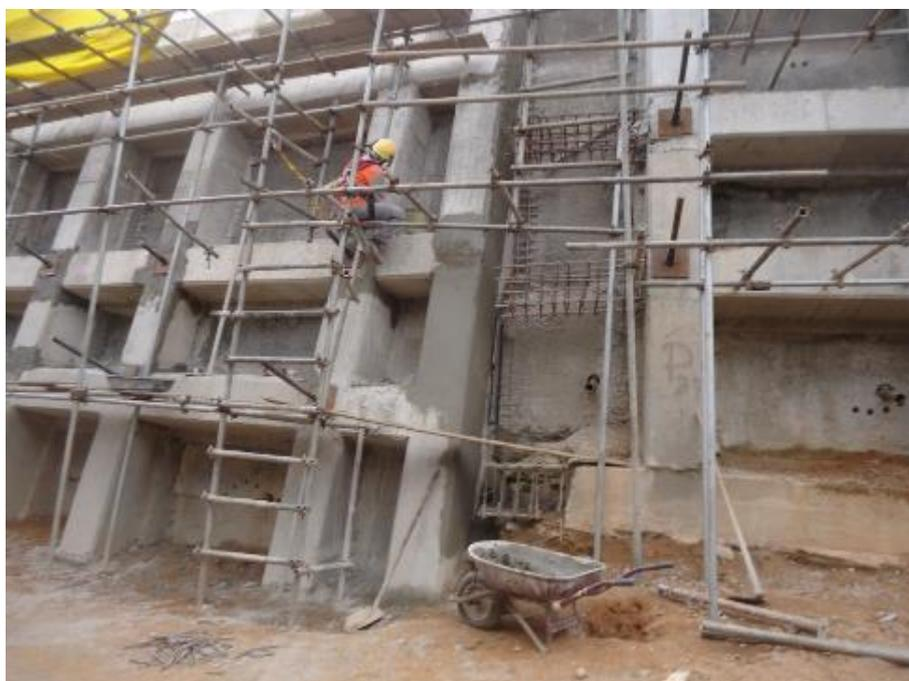
*Figura 04 – Acabamento nos pilares do Painel D*
