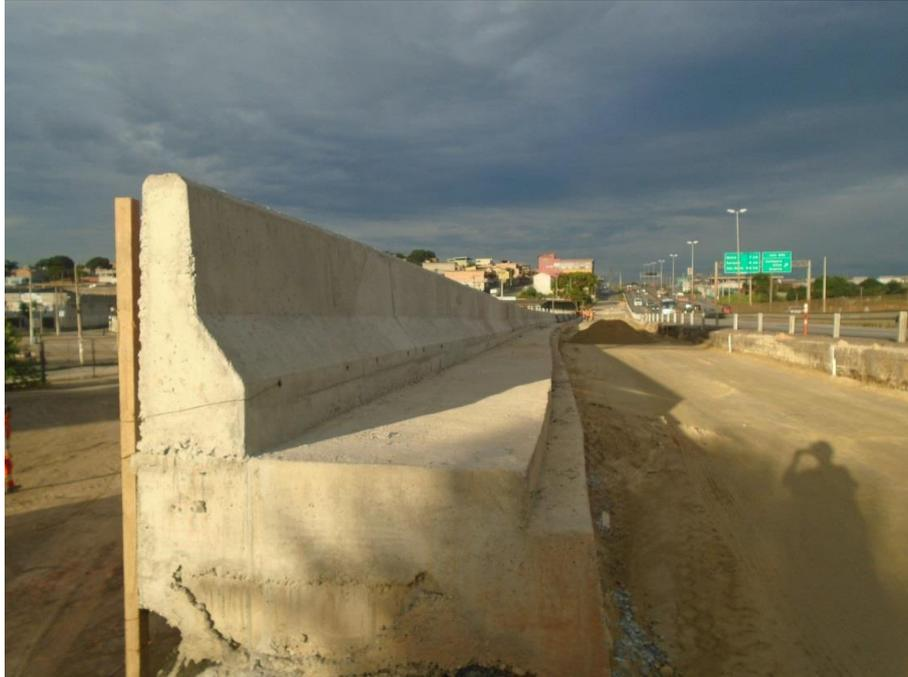
*Figura 01 – Barreira de concreto executada*
