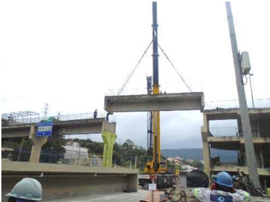
*Figura 02 – Remoção da travessia existente*
