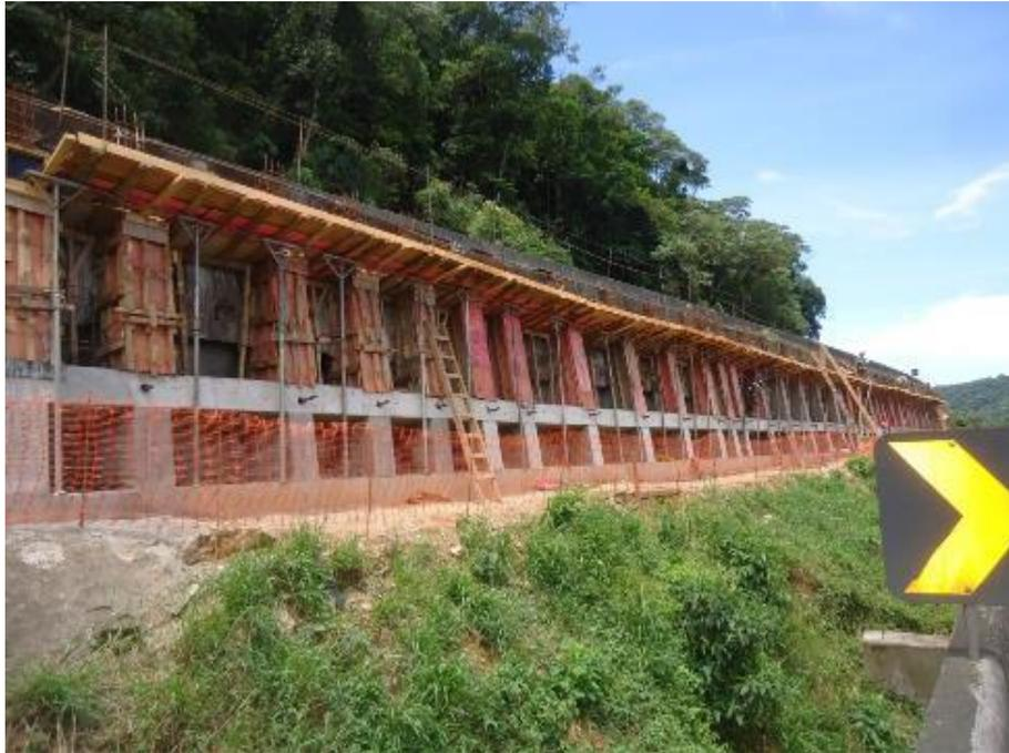
*Figura 03 – Montagem das armações e formas dos pilares e viga de coroamento*
