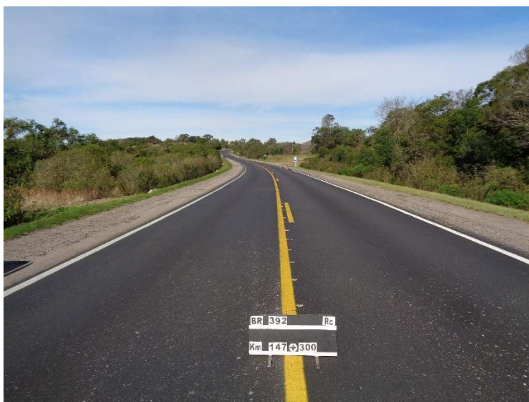
Figura 03 – Recuperação do Pavimento – BR-392/RS
