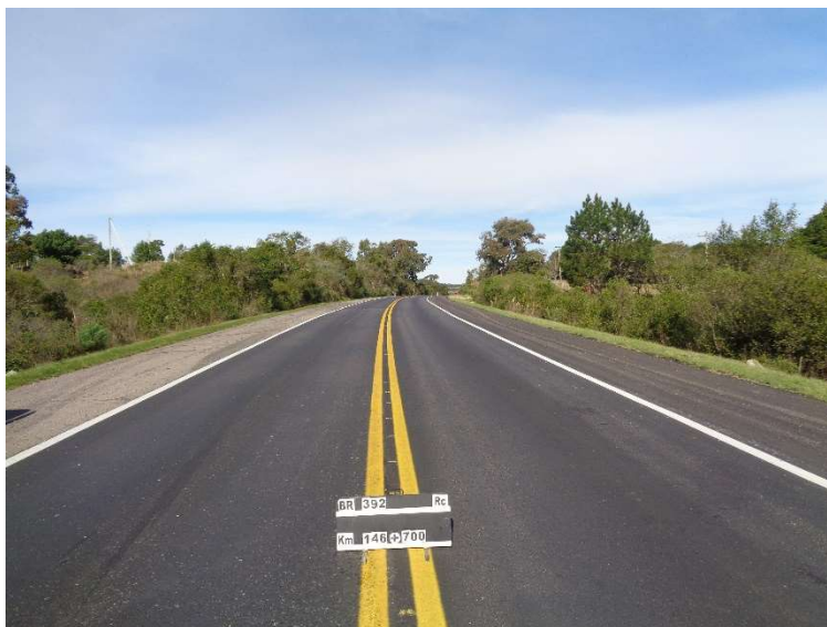
Figura 02 – Recuperação do Pavimento – BR-392/RS
