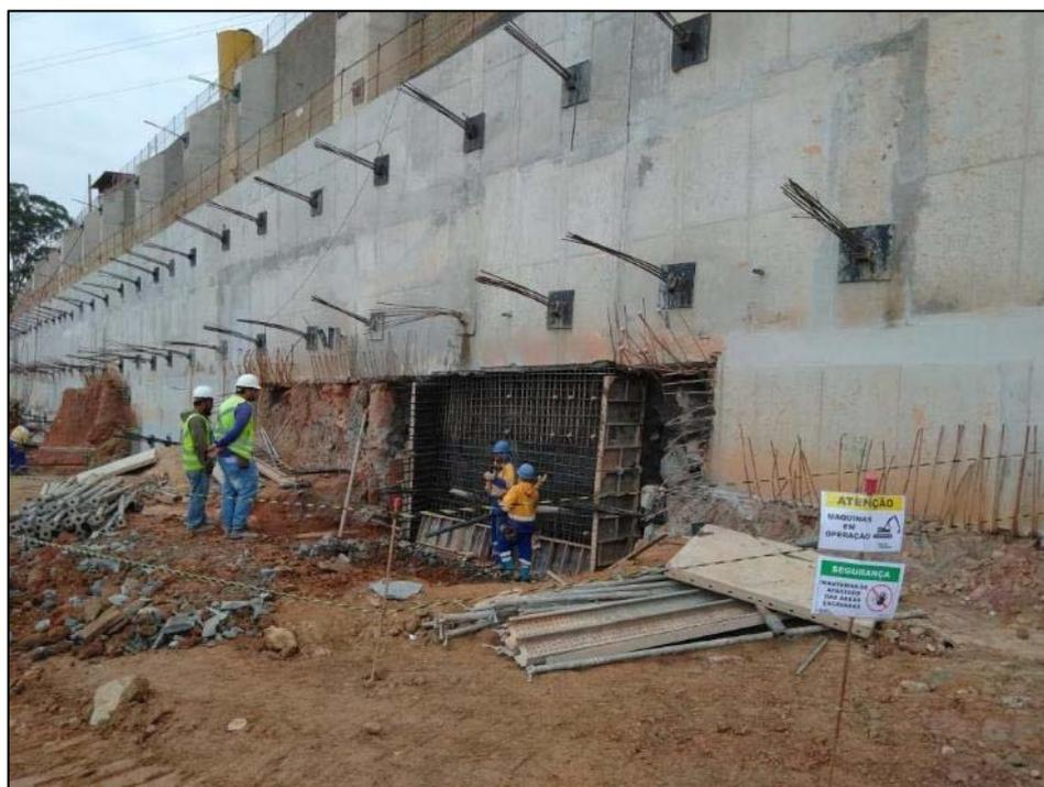
*Figura 02 – Montagem de forma para concretagem de nicho*
