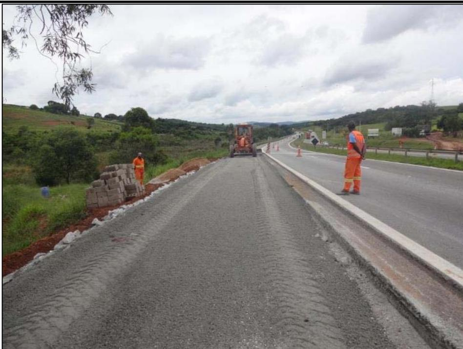
*Figura 03 – Aplicação e compactação de BGS*
