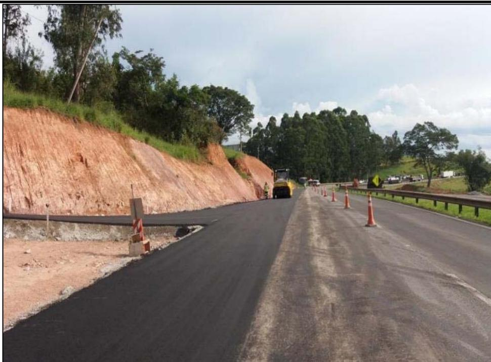
*Figura 05 – Pavimentação com aplicação de CBUQ*
