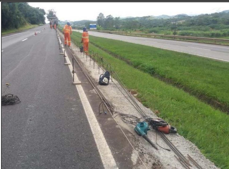
*Figura 03 – Montagem de ferragens*
