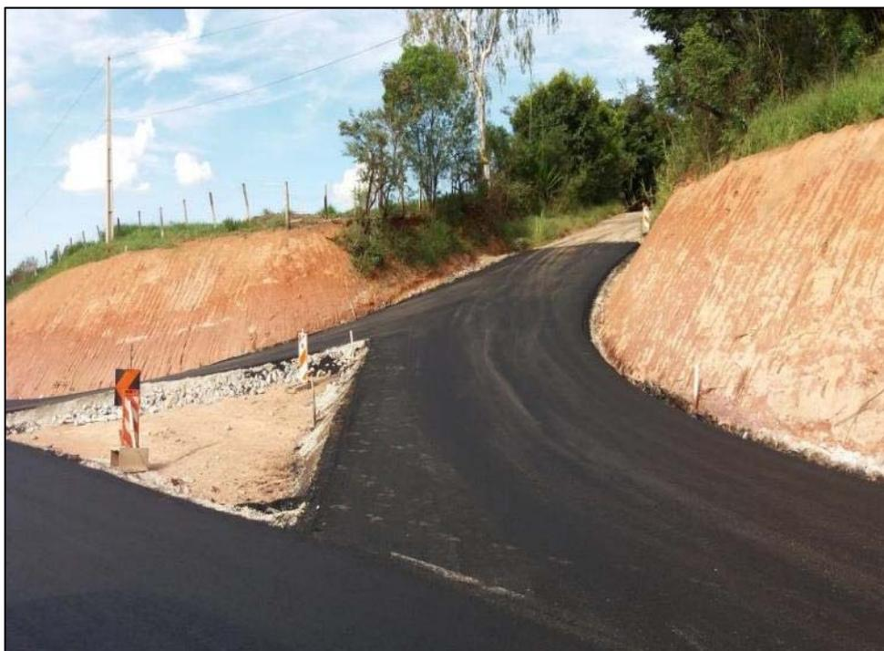
*Figura 04 – Pavimentação com aplicação de CBUQ*
