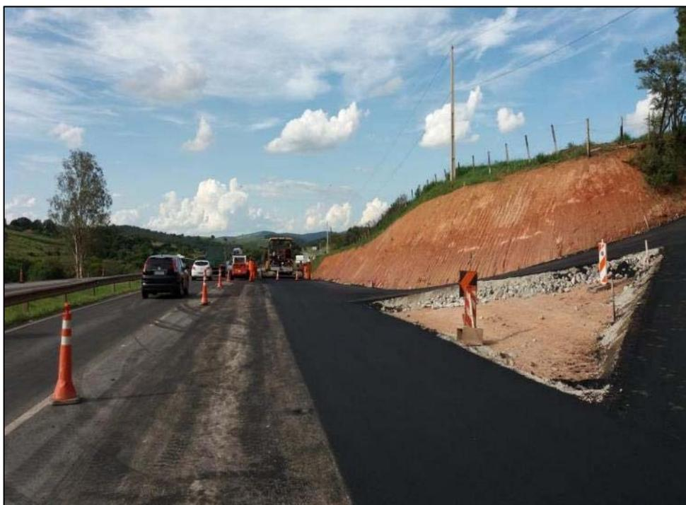
*Figura 06 – Pavimentação com aplicação de CBUQ*
