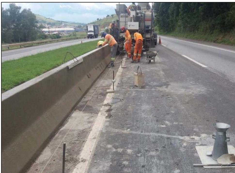
*Figura 04 – Concretagem e acabamento da barreira*
