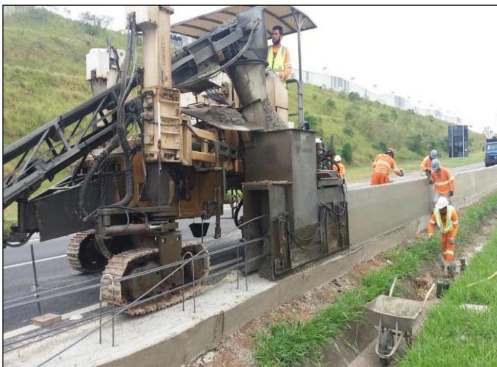
*Figura 02 – Concretagem e acabamento da barreira*
