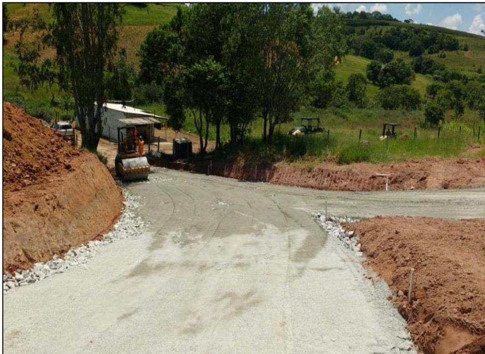
*Figura 02 – Compactação e travamento da camada de rachão*
