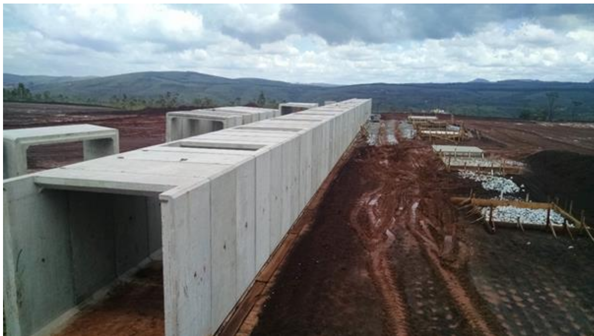
Montagem das aduelas e execução do magro das bases da cobertura – P9
