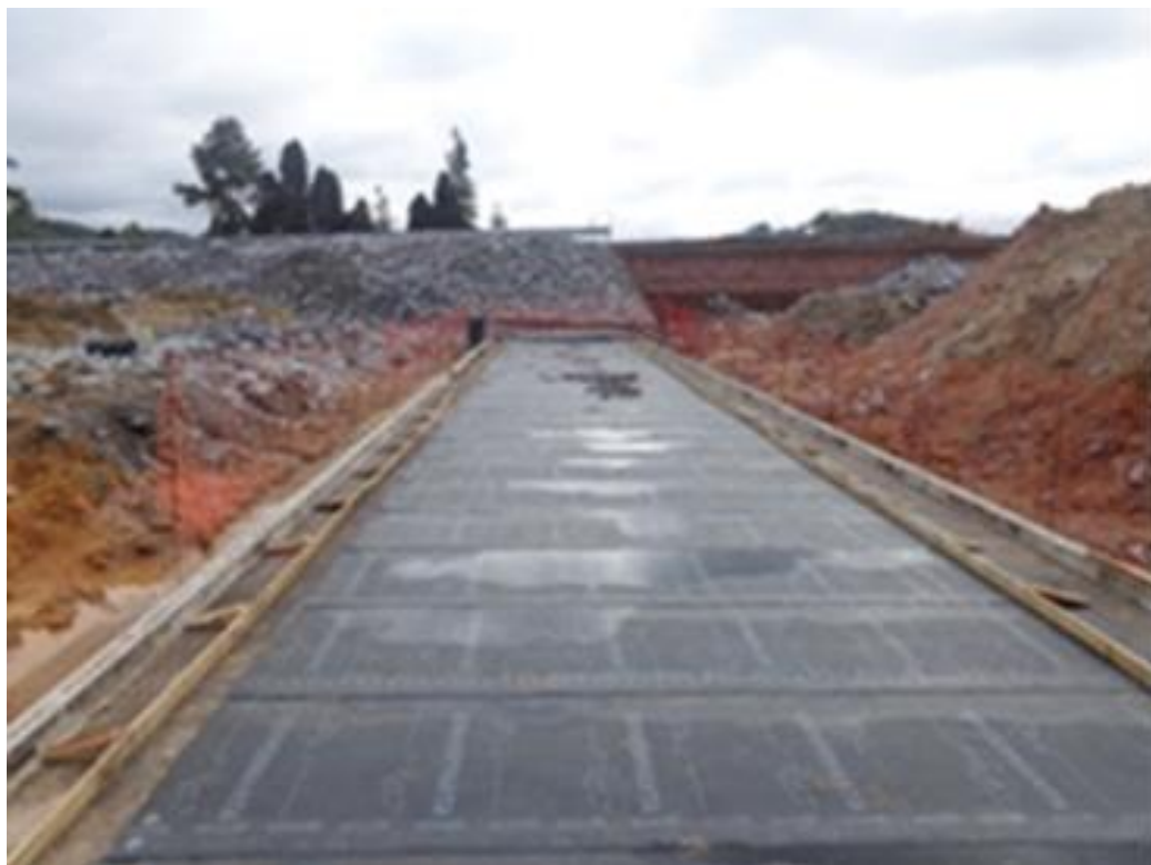
Execução de impermeab. da laje de apoio – P11
