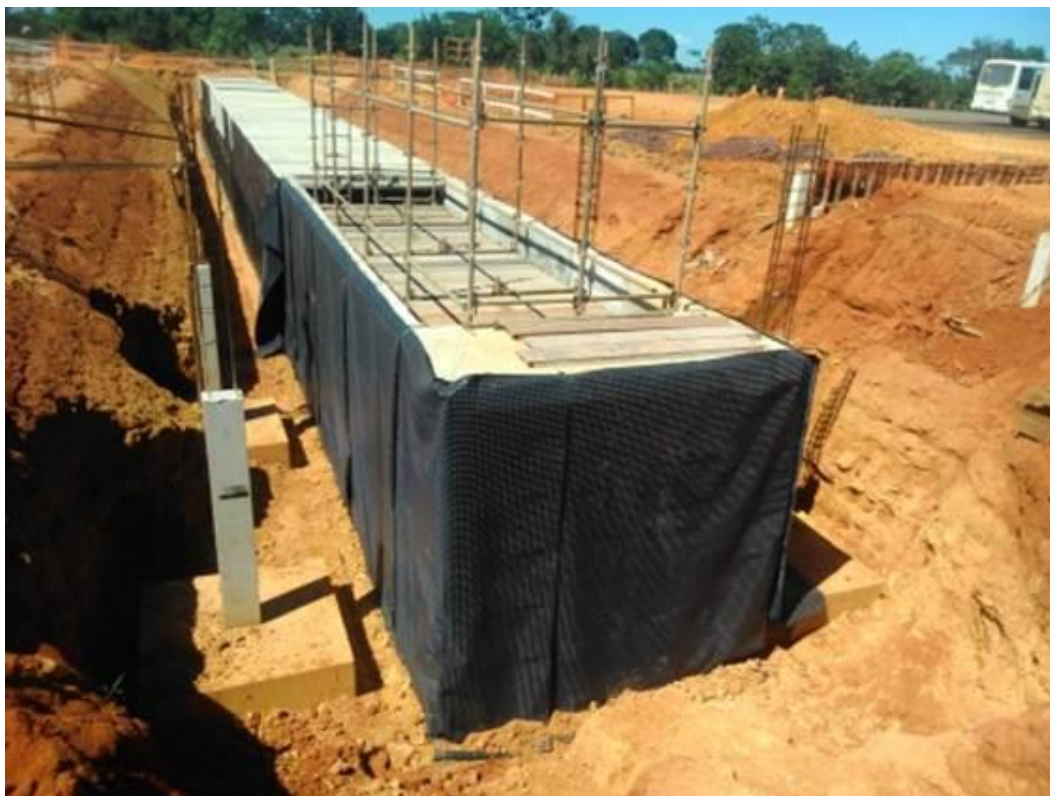
Impermeabilização do Tunel – P3
