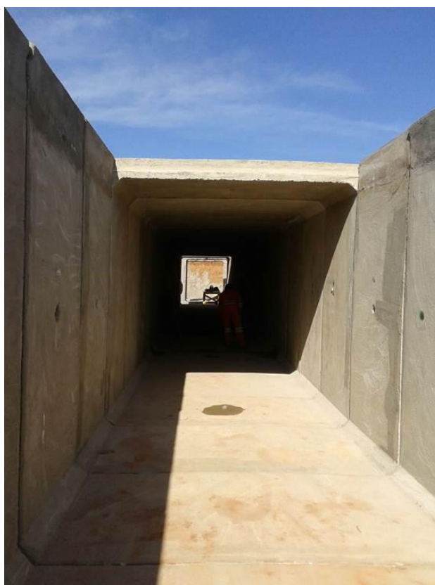
Instalação de Aduelas – Túnel – P7
