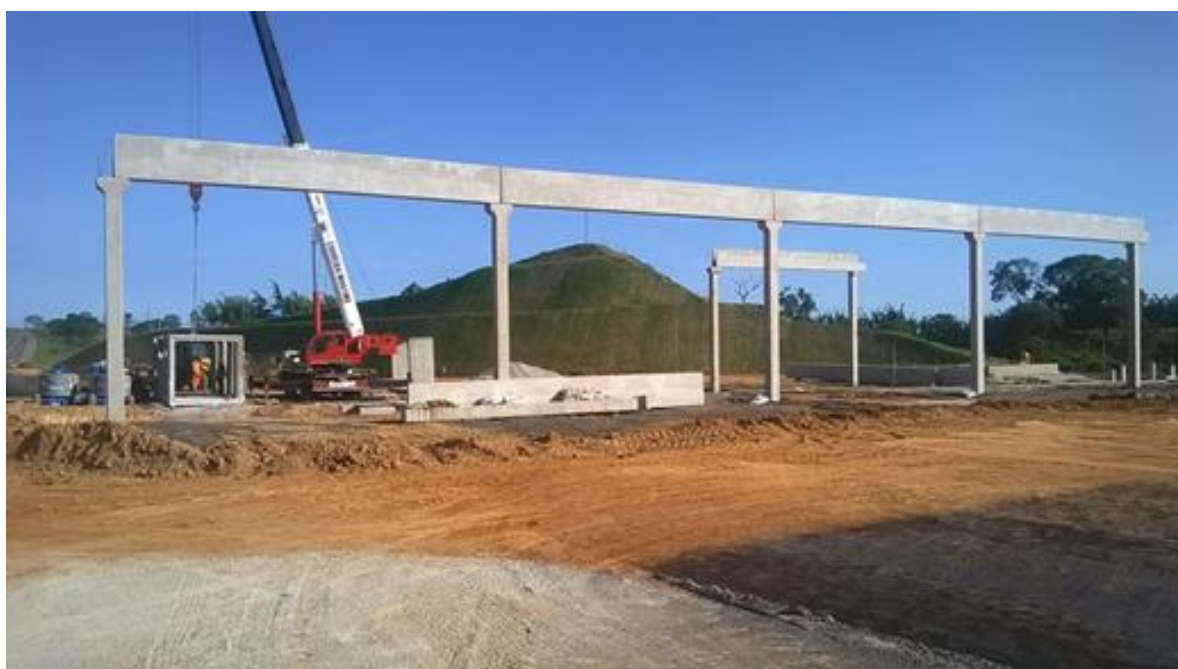
Montagem dos pilares , vigas calhas e aduelas – P8
