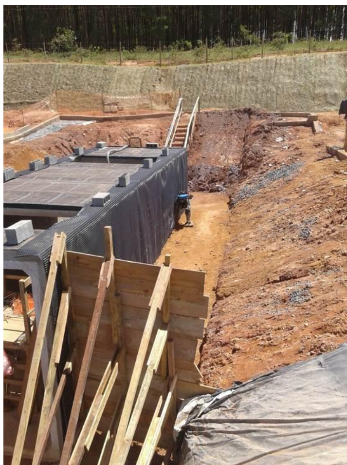
Reaterro com solo cimento – Túnel sentido Sul – P5
