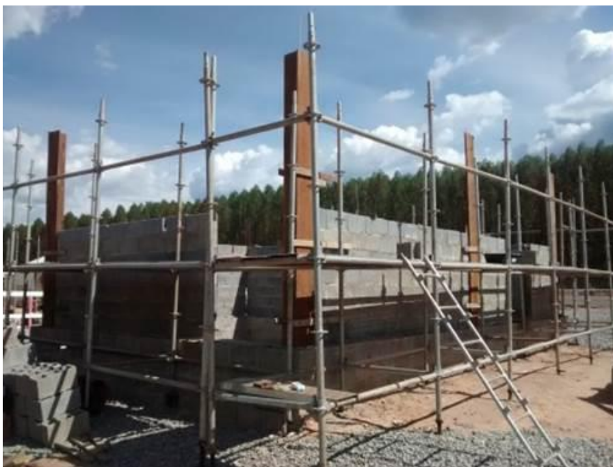
Montagem dos Pilares Prédio de controle – P4
