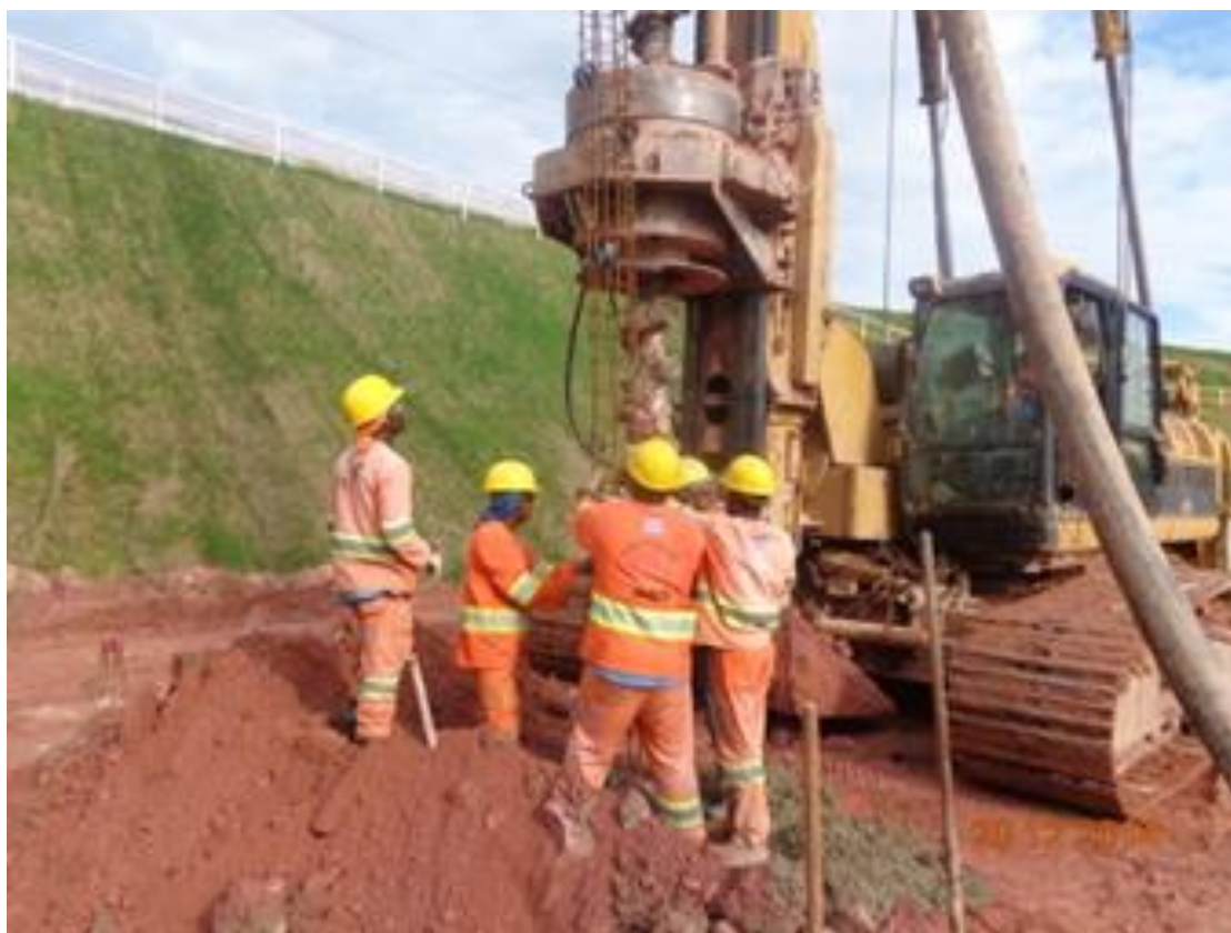
Execução da estaca do prédio de controle – P10
