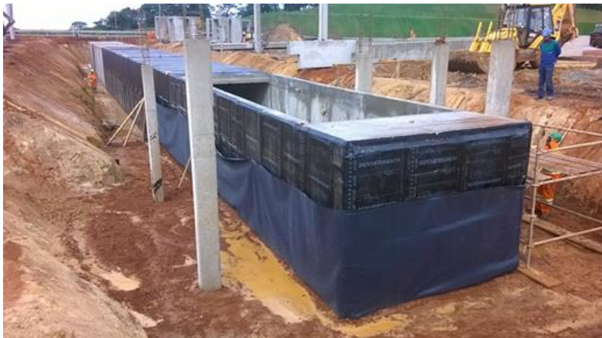
Reaterro e impermeabilização – P8
