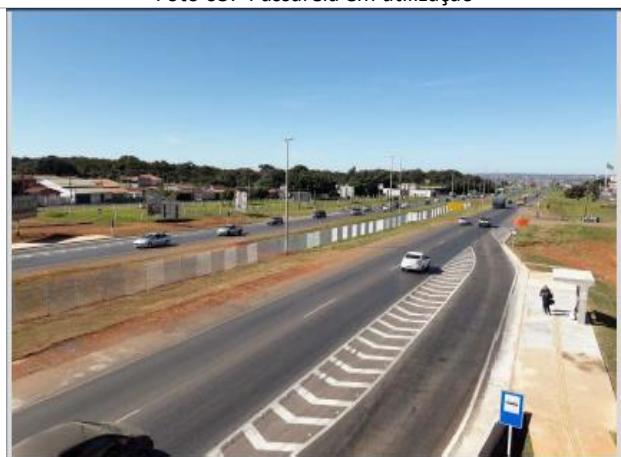
Foto 04: Baía Sul e abrigo finalizados
