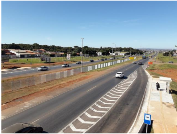
Foto 01: Tela antiofuscante instalada
