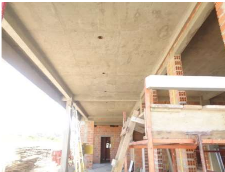
Figura 04 – Construção Bases Operacionais BR-116 km 607+000 LE
