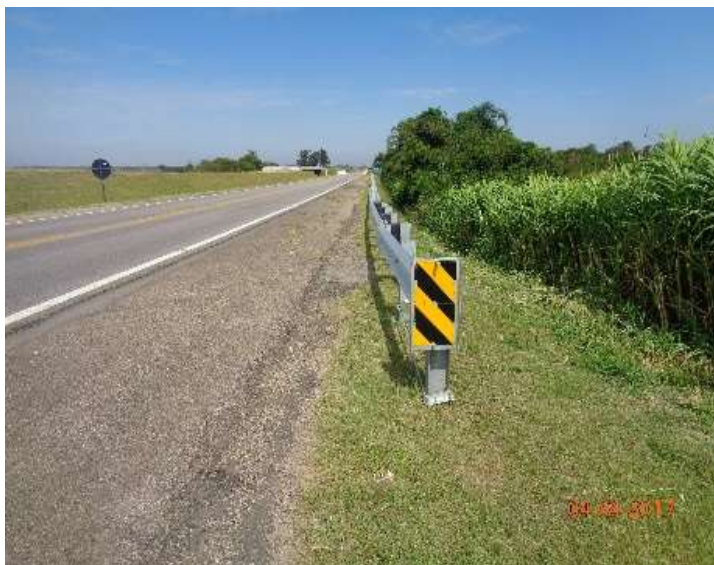
Figura 06 – Implantação defensas metálicas BR-116
