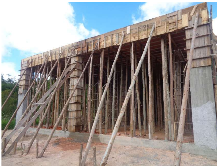
Figura 02 – Construção Bases Operacionais BR-116 km 492+000 LE
