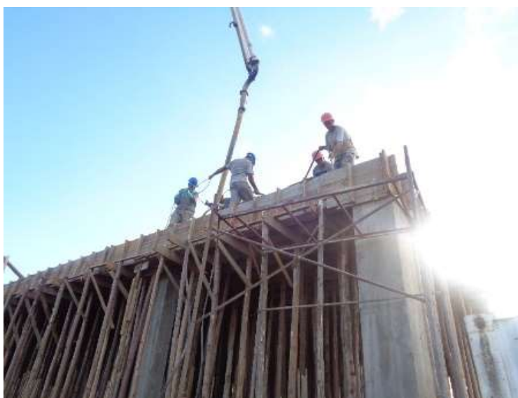
Figura 03 – Construção Bases Operacionais BR-116 km 524+000 LD
