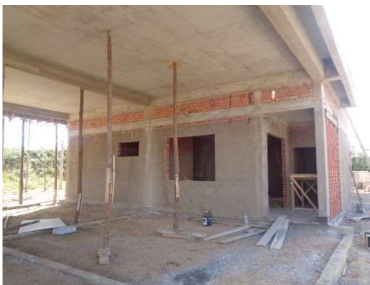
Figura 05 – Construção Bases Operacionais BR-116 km 125+700 LE
