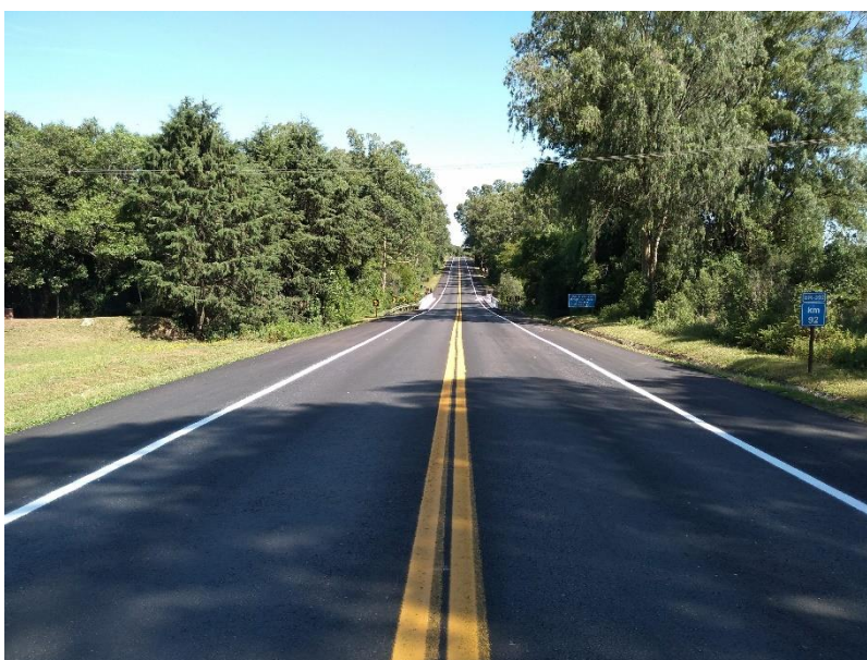
Figura 03 – Serviços de sinalização horizontal BR-392/RS Trecho Pelotas – Santana da Boa Vista / km 092+000
