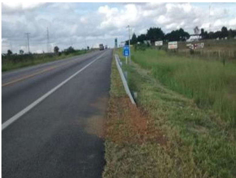
Figura 07 – Implantação de Defensas Metálicas
