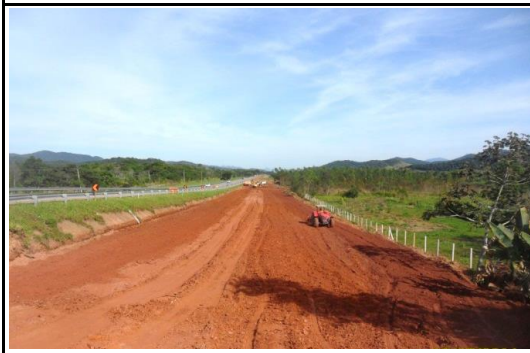
FOTO 4: Compactação de camada no Km 222,600 Norte
