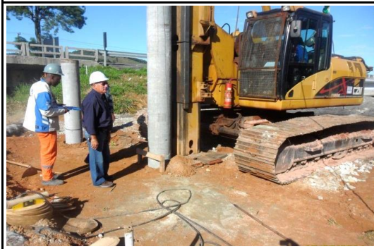
FOTO 6: Cravação de estacas pré-moldadas - O.A.E. Rio Iguapé
