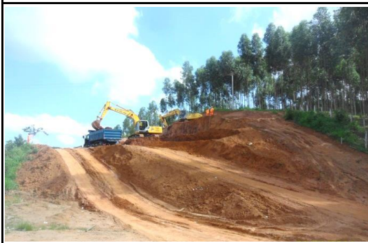
FOTO 3: Lançamento de material Km 215,000 Sul
