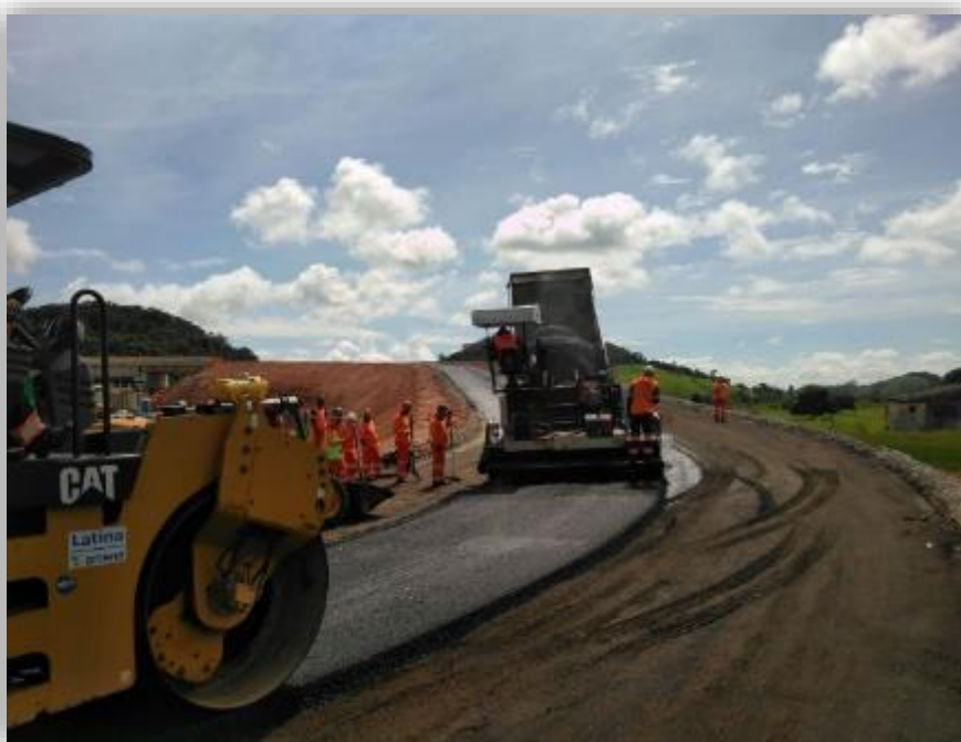
Figura 02 – Aplicação de massa (CBUQ) - km 243,5
