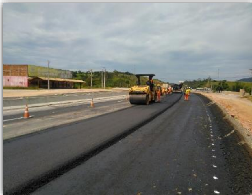
Figura 03 – Aplicação de massa (CBUQ) - km 244
