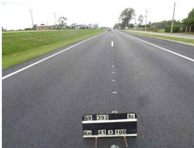
Figura 02 – Serviços de recuperação do pavimento BR-392 km 41+100
