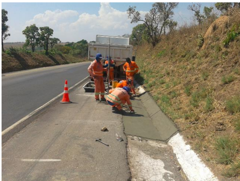
Foto 2: Recuperação de sarjeta 120/GO.
