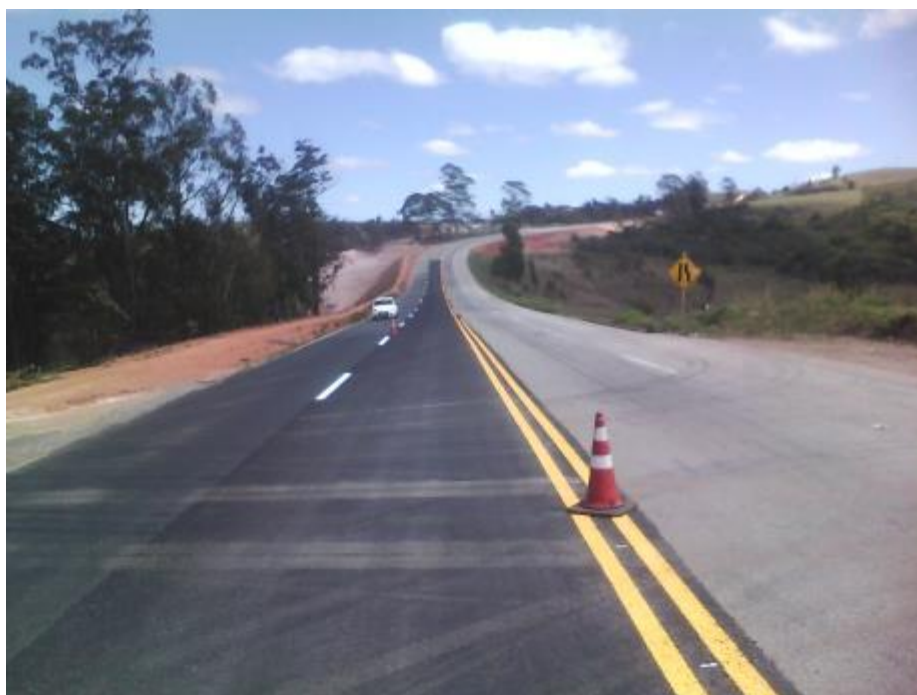
Foto 1 e 2 – Aplicação de micro e pintura Sinalização em Carandaí
