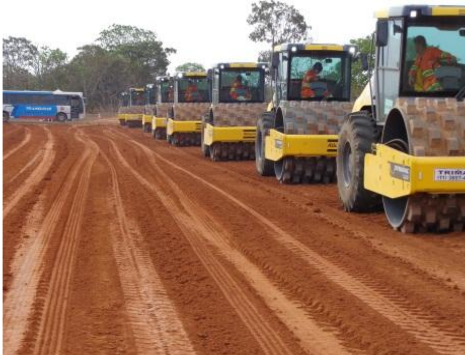
Foto 1: Trecho 3 – Compactação da camada
