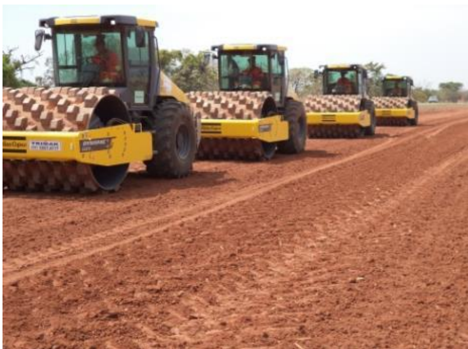
Foto 2: Trecho 4 – Compactação de camada
