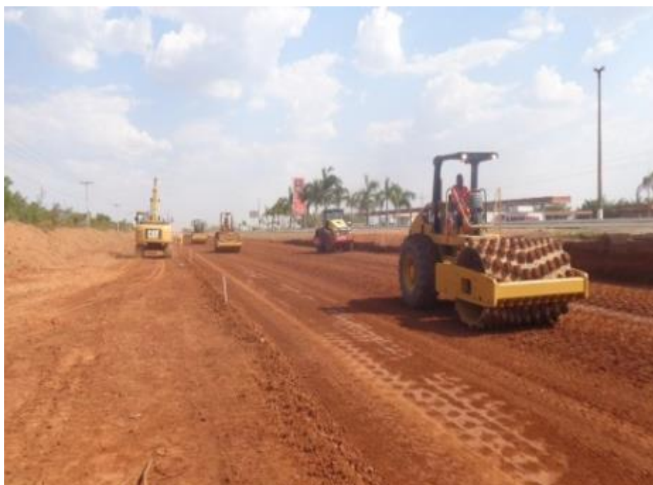
Foto 2: Trecho 1 – Compactação de camada
