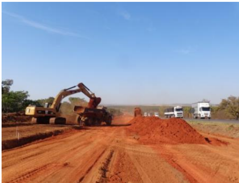
Foto 1: Trecho 2 – Lançamento de material
