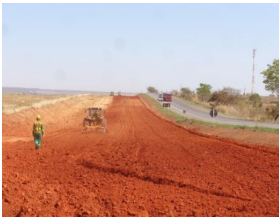
Foto 2: Trecho 3 – Homogeneização da camada
