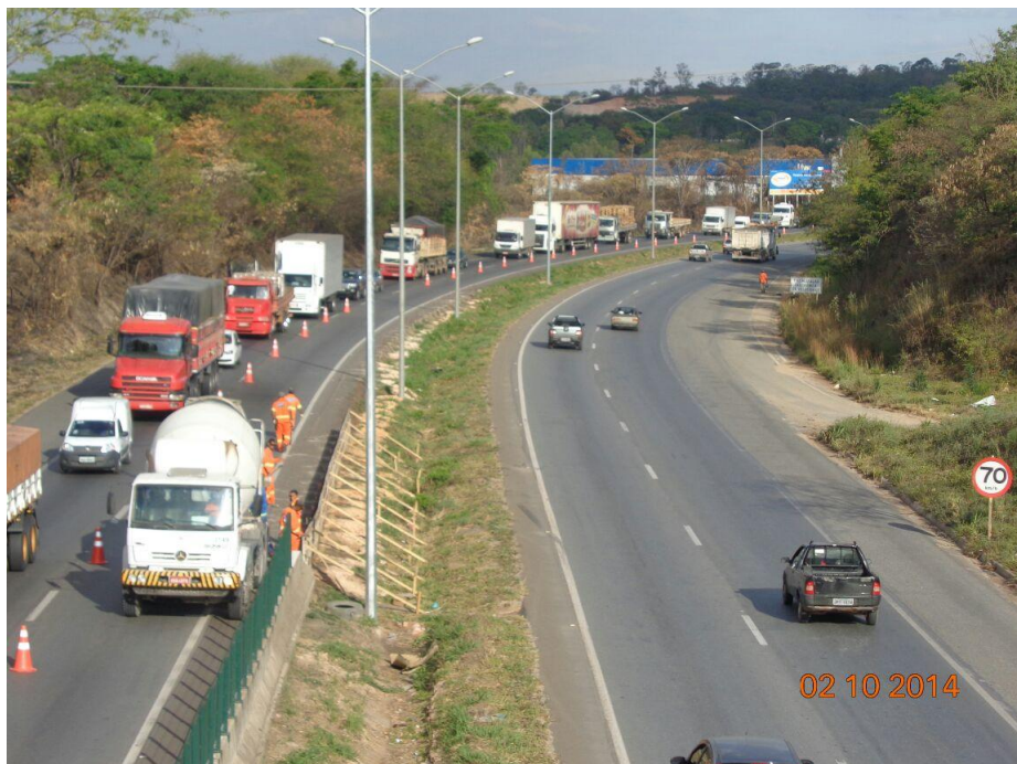
Foto 1: Execução de barreira rígida km 513
