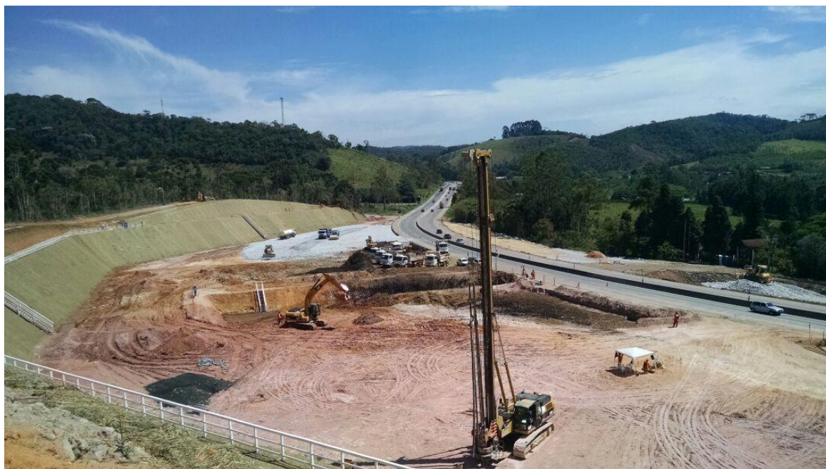
PP11– Escavação do túnel e fundações
