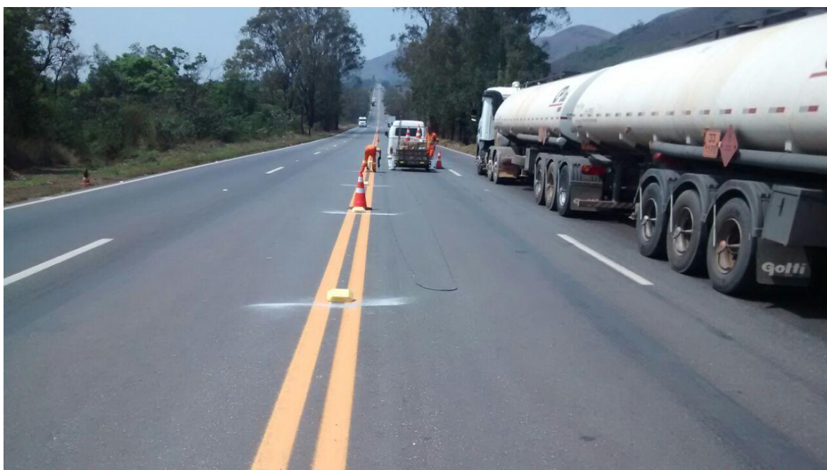
Implantação de Tachões – Km 660 (Carandaí/MG)
