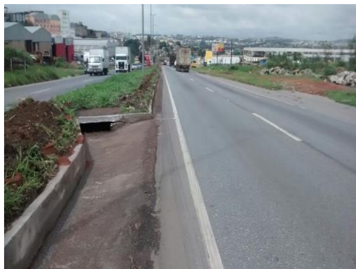
Foto 1 e 2 – Limpeza de drenagem no km 529,500 - Canteiro Central.
