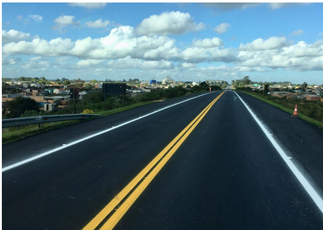
Figura 02 – Serviços de Pavimentação e Sinalização Horizontal BR-116/RS – Trecho: Pelotas – Jaguarão / km 531,300
