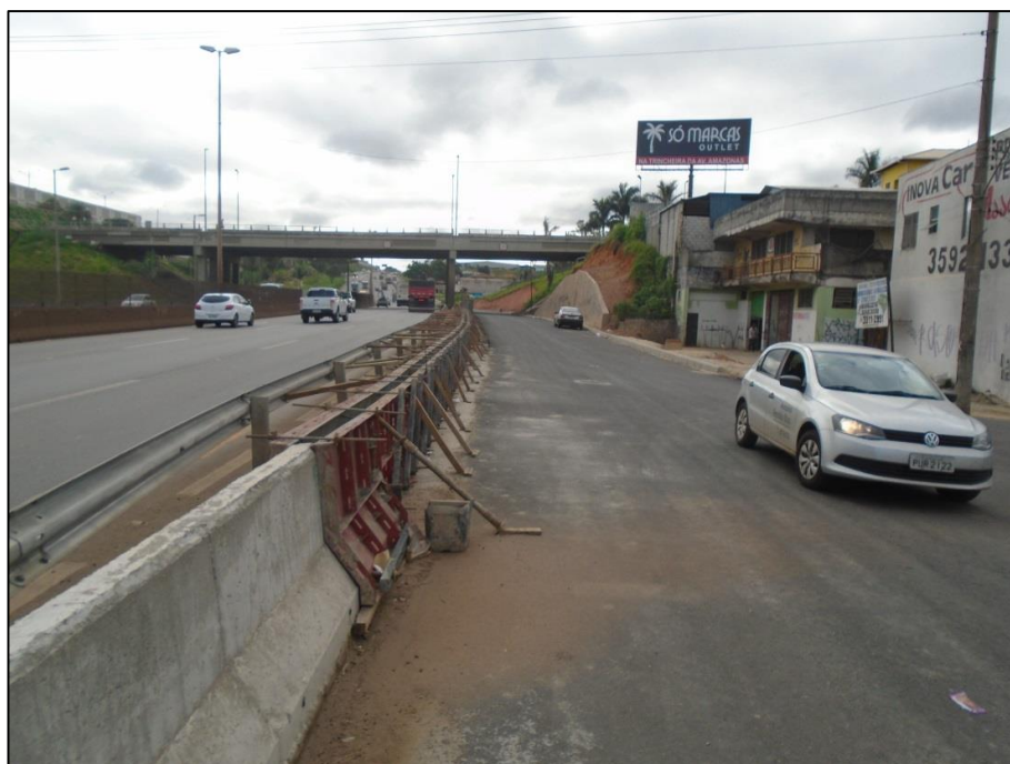
Figura 02 – Execução de barreira New Jersey
