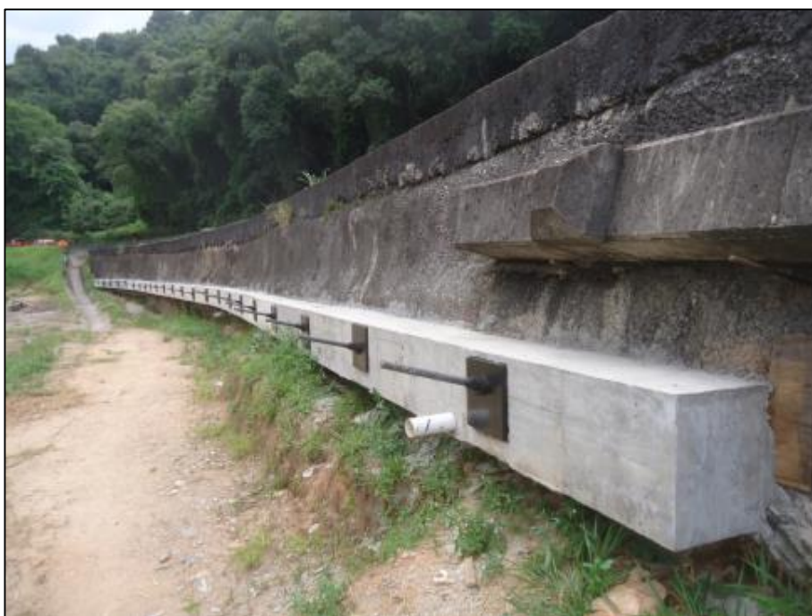
Figura 02 – Viga de coroamento
