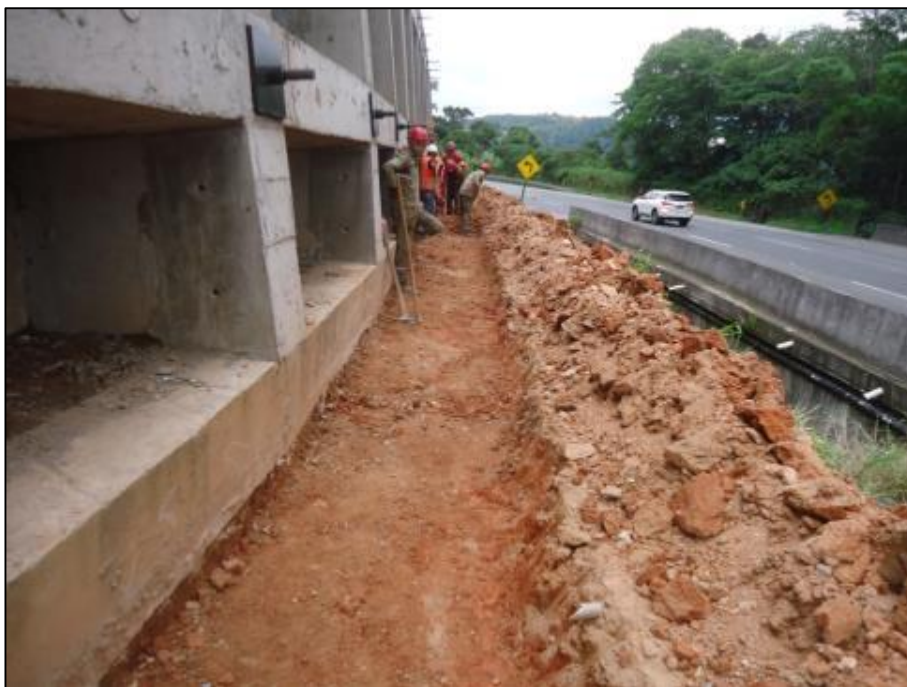
Figura 04 – Abertura de vala para execução de canaleta
