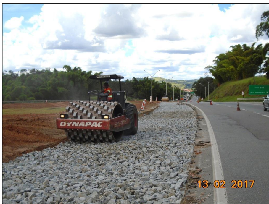
Figura 03 – Compactação sub-base
