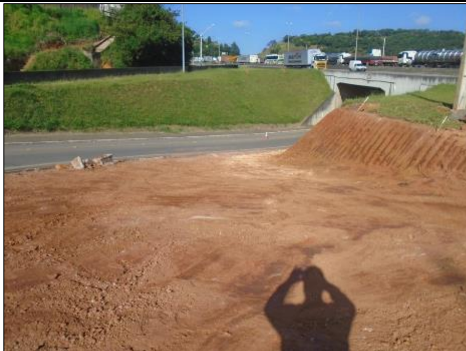
Figura 06 – Regularização e terraplenagem para o retorno
