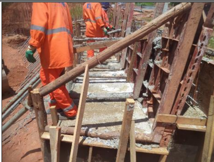
Figura 04 – Concretagem das formas
