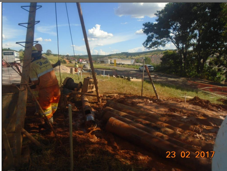
Figura 06 – Sondagem e perfuração de estacas
