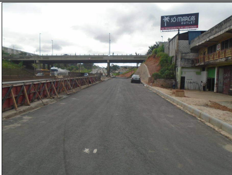
Figura 04 – Execução de barreira New Jersey
