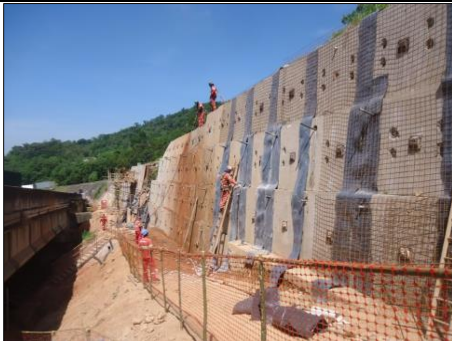
Figura 06 – Implantação das armações metálicas para projetado
