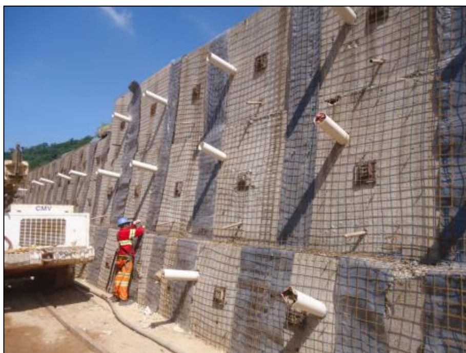
Figura 05 – Implantação das armações metálicas para projetado
