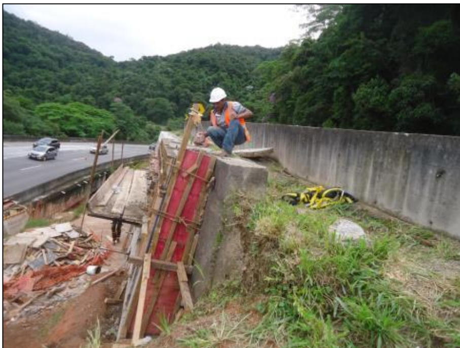
Figura 01 – Concretagem do pilar e da viga de coroamento
