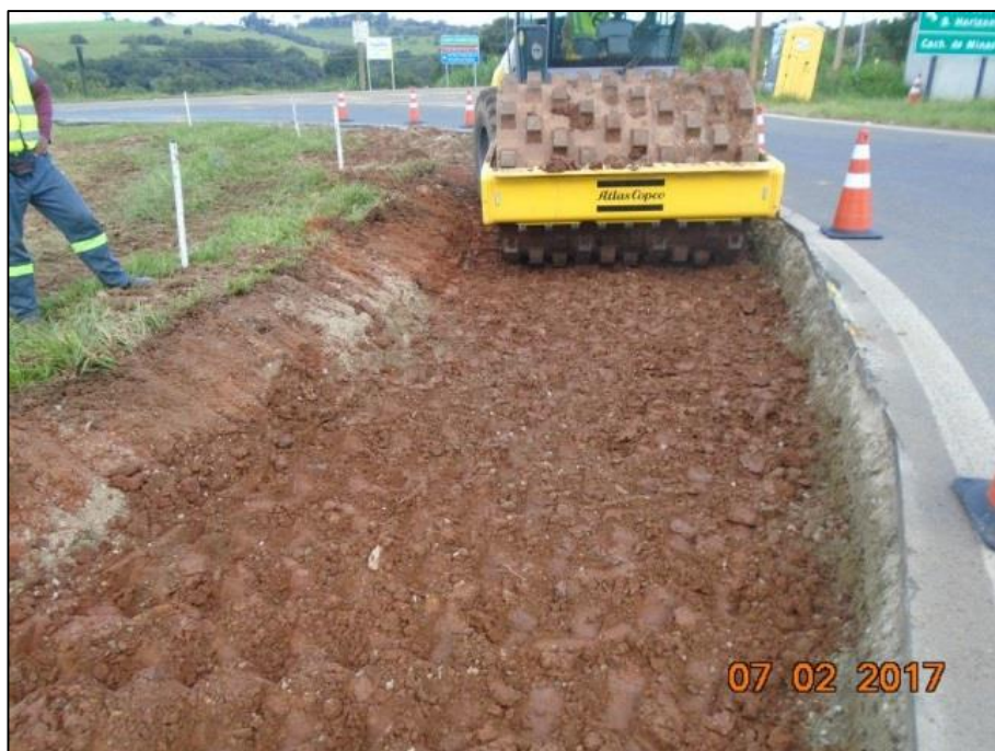
Figura 02 – Tratamento e Compactação do Sub-leito
