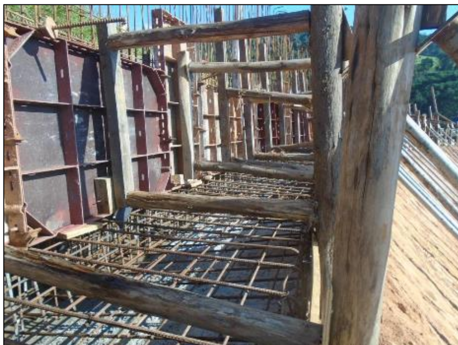
Figura 03 – Montagem de formas e armação do muro de contenção
