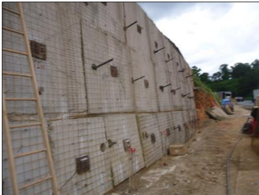
Figura 02 – Implantação das armações metálicas para projetado
