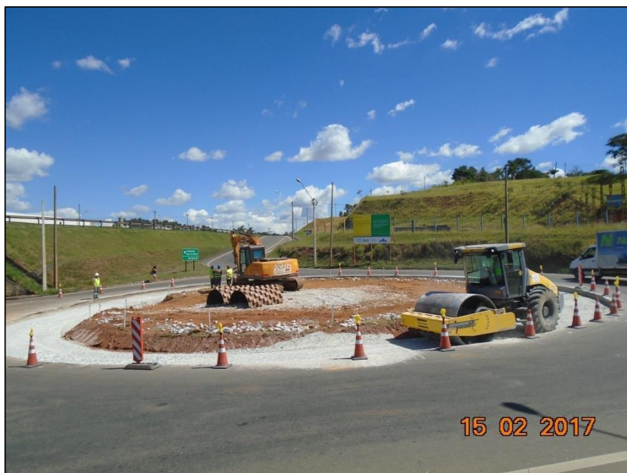
Figura 04 – Lançamento de base e compactação
