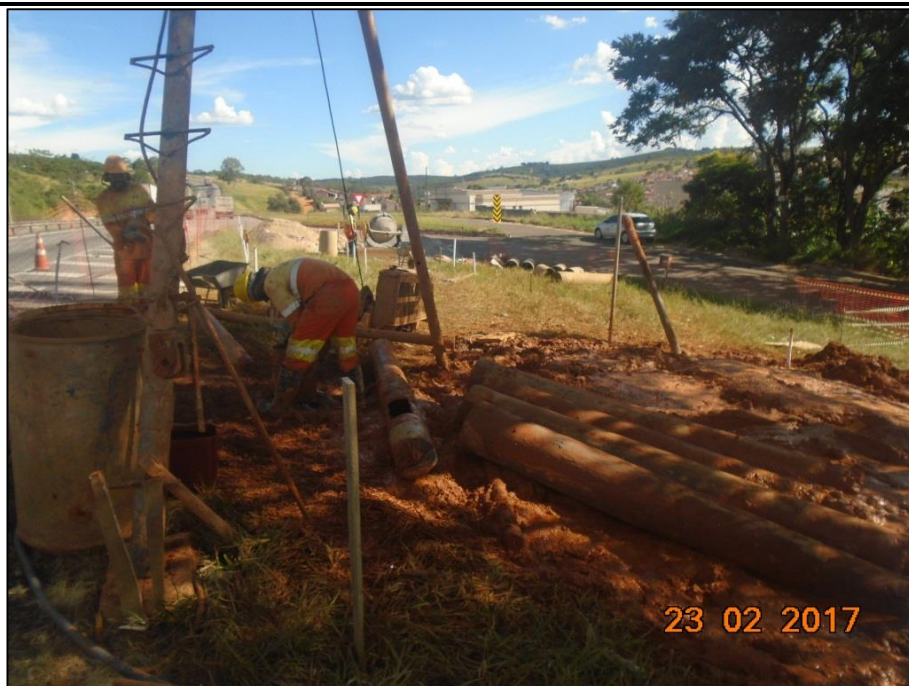
Figura 04 – Sondagem e perfuração de estacas
