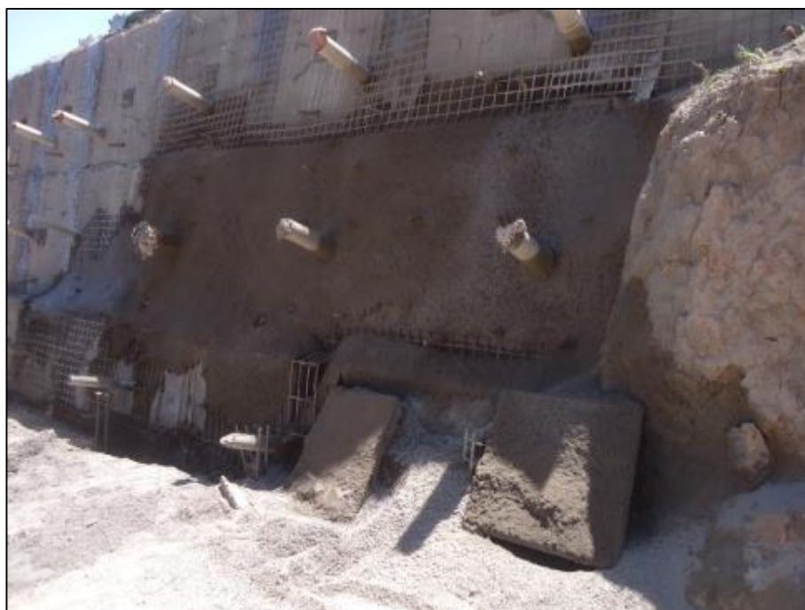
Figura 03 – Aplicação do concreto do projetado
