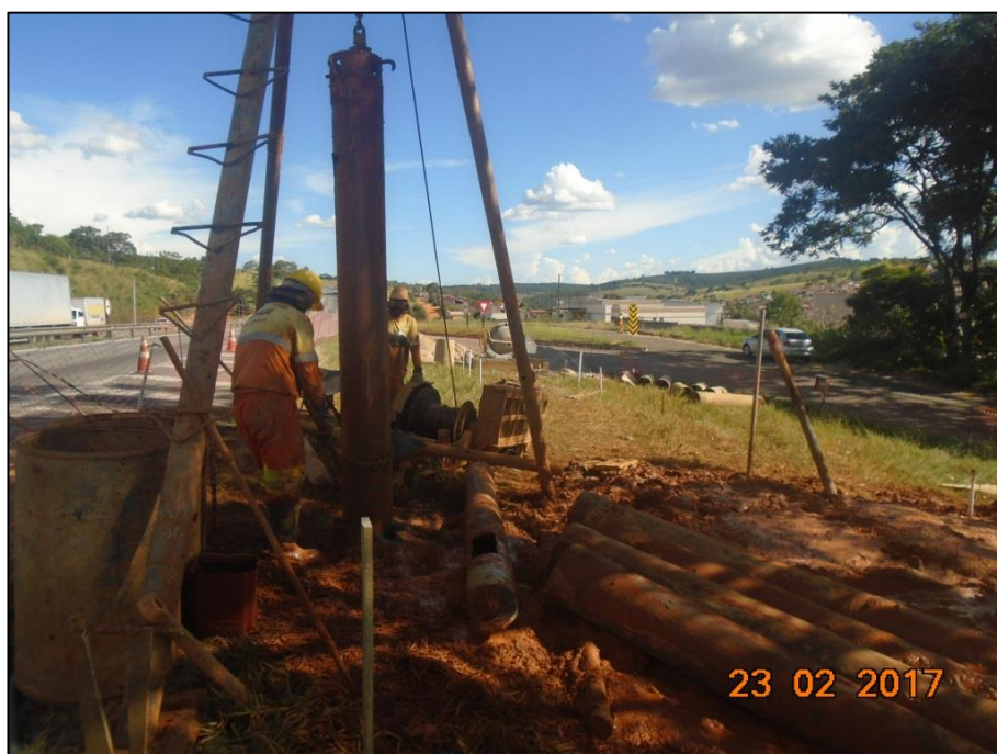
Figura 05 – Sondagem e perfuração de estacas
