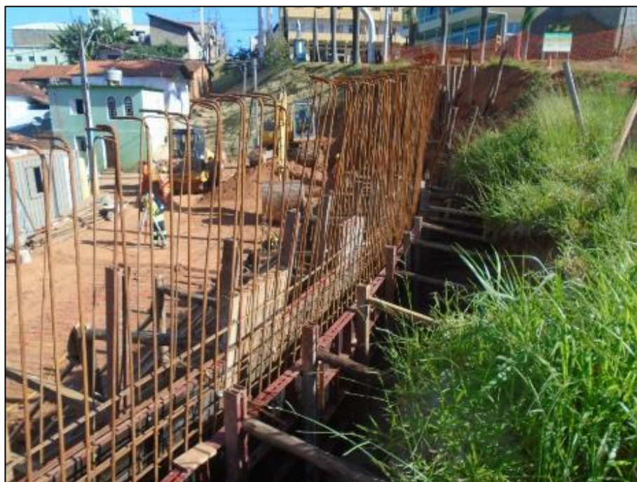
Figura 02 – Montagem de formas e armação do muro de contenção
