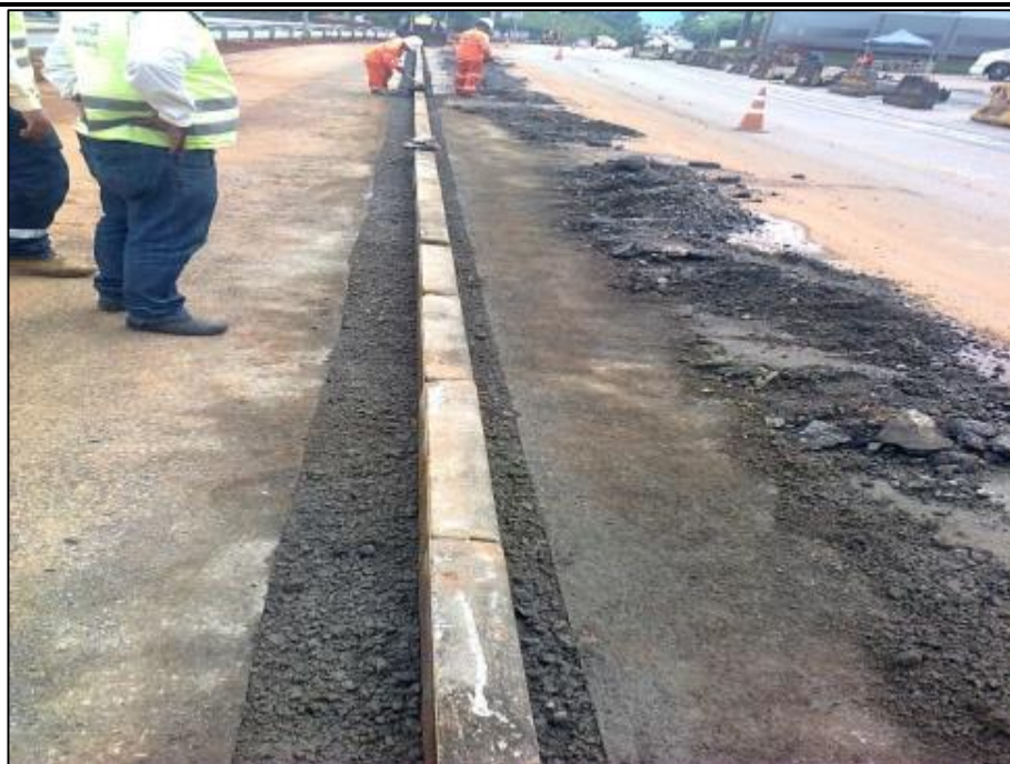
Figura 04 – Início da guia para nova calçada
