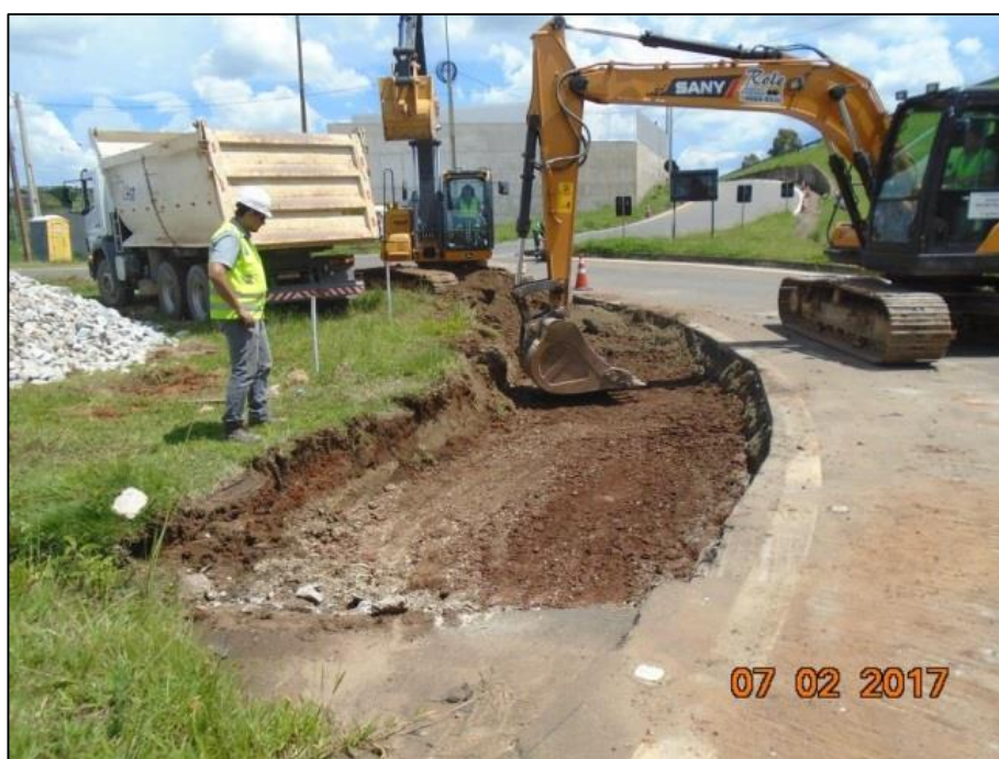
Figura 01 – Escavação e Terraplenagem
