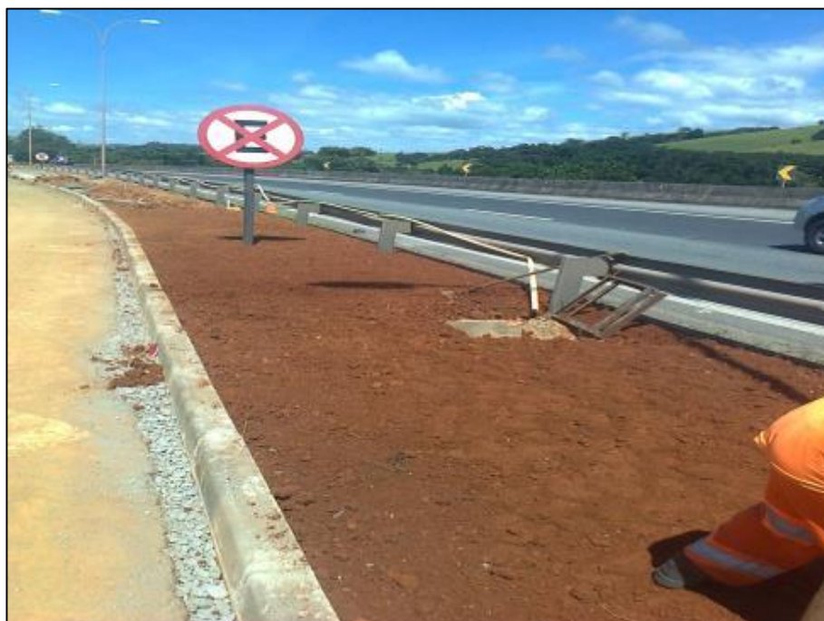
Figura 05 – Execução de guia, calçada e caixa de drenagem
