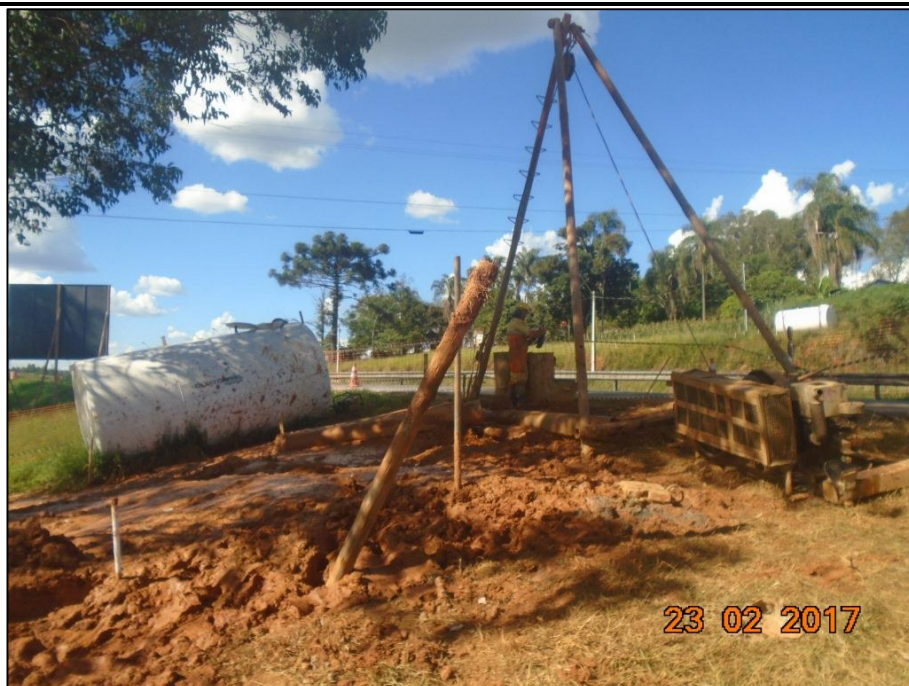
Figura 02 – Sondagem e perfuração de estacas
