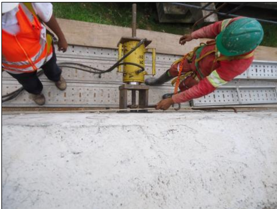
Figura 03 – Protenção dos tirantes
