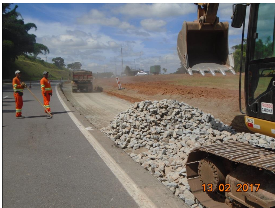
Figura 02 – Lançamento de base
