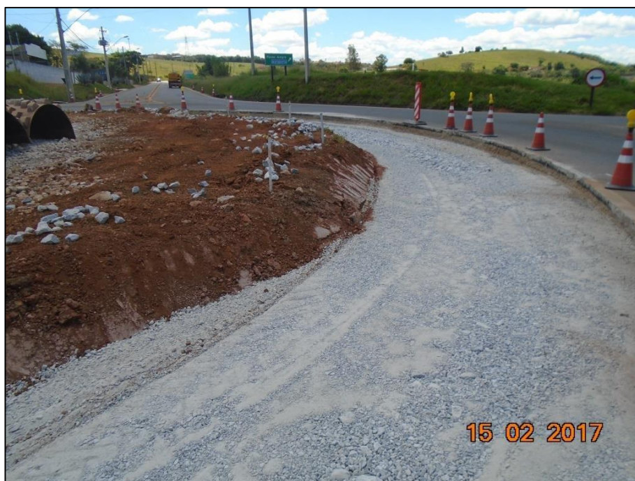
Figura 03 – Lançamento de base e compactação
