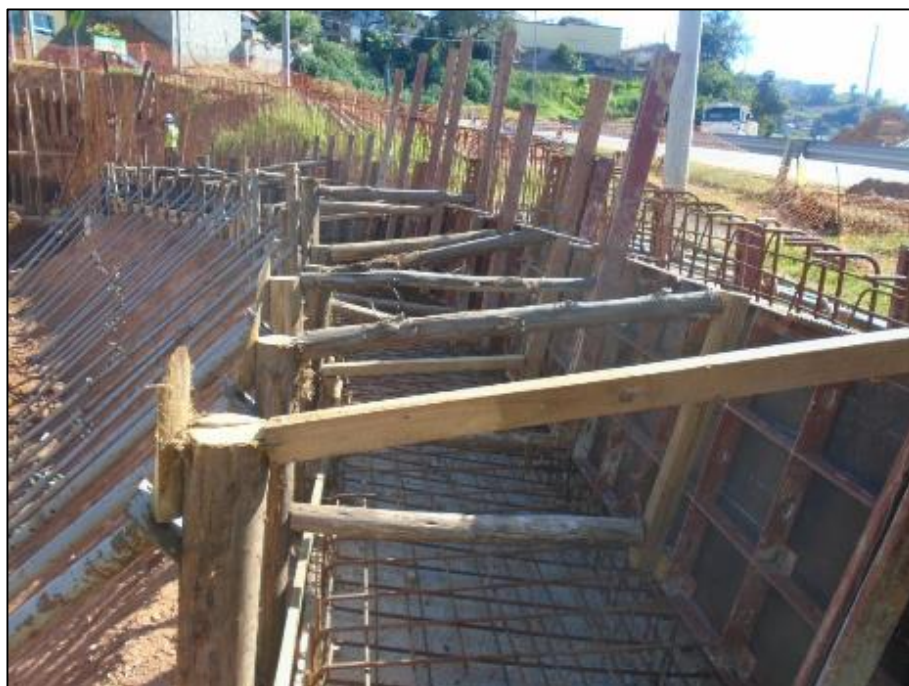
Figura 01 – Montagem de formas e armação do muro de contenção
