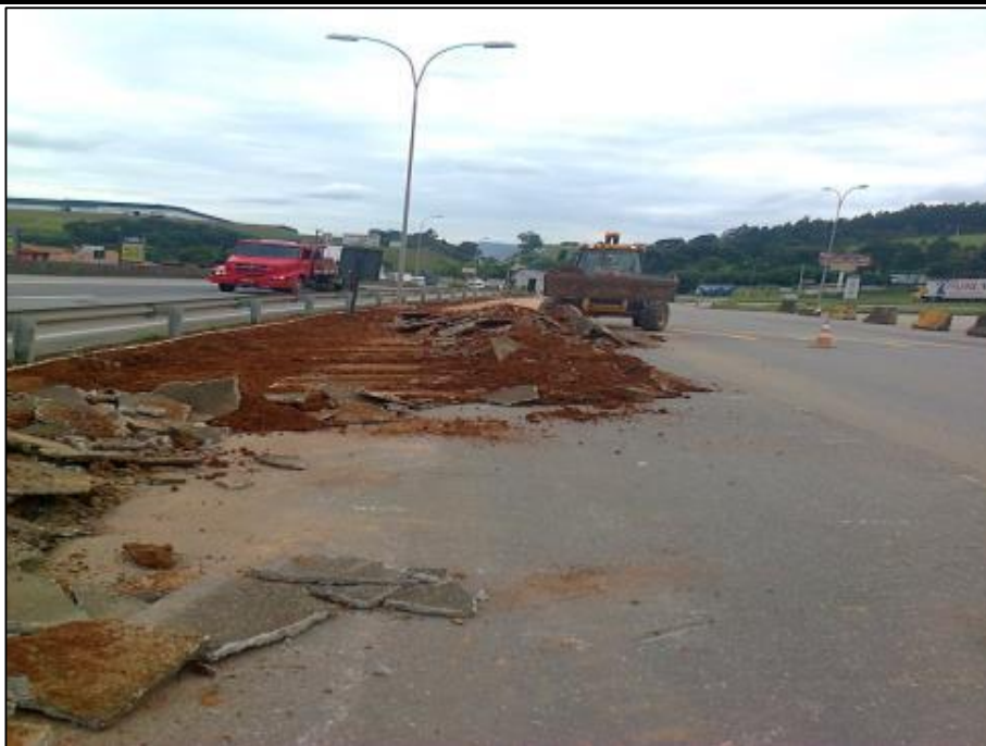
Figura 02 – Demolição da calçada existente e relocação
