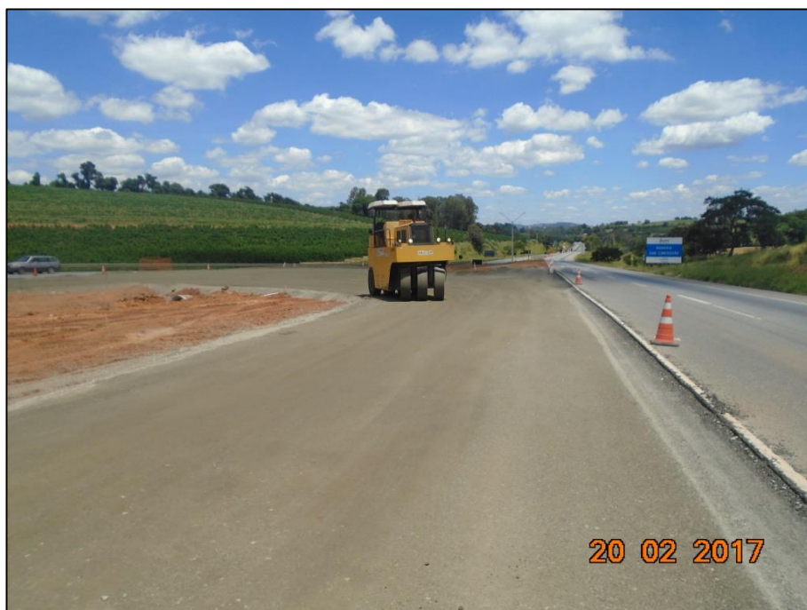
Figura 05 – Compactação de base
