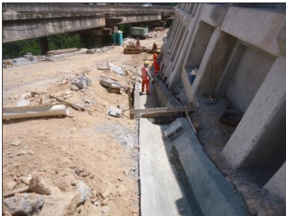
Figura 03 – Execução do dispositivo de drenagem
