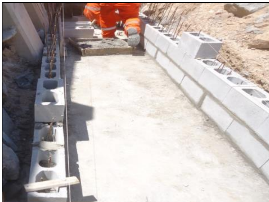
Figura 04 – Execução do dispositivo de drenagem
