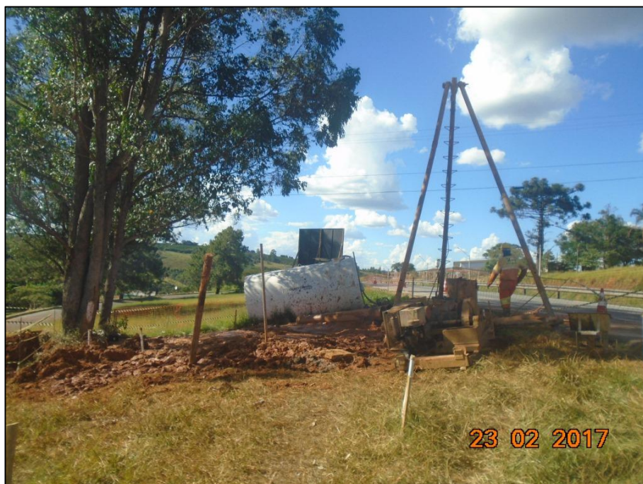
Figura 03 – Sondagem e perfuração de estacas
