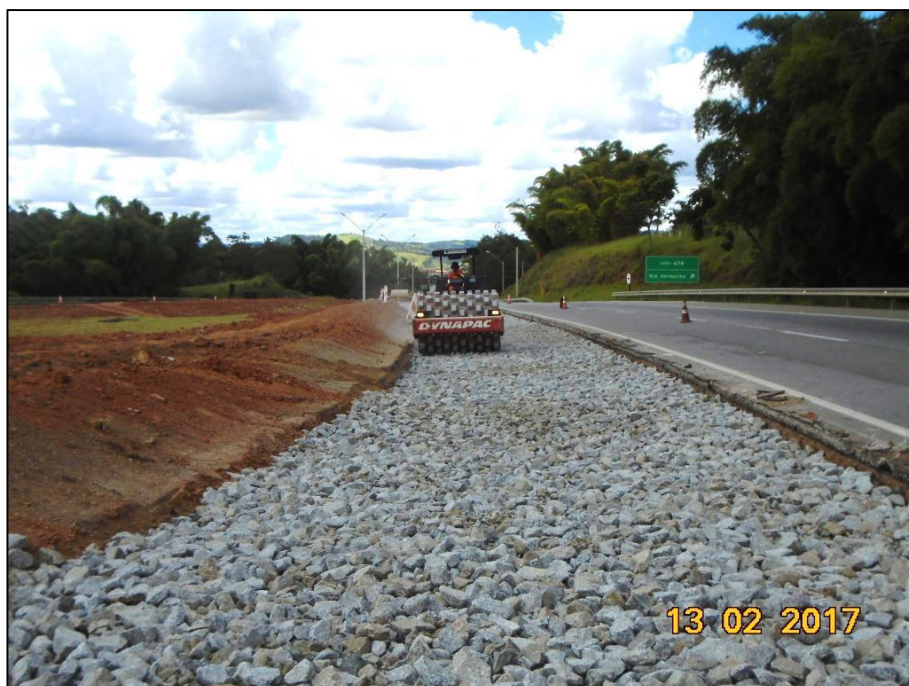
Figura 04 – Compactação sub-base
