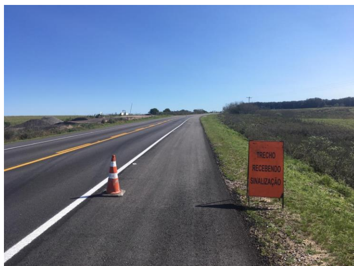
Figura 03 – Serviços de sinalização horizontal BR-116/RS Pelotas – Jaguarão / km 567+000
