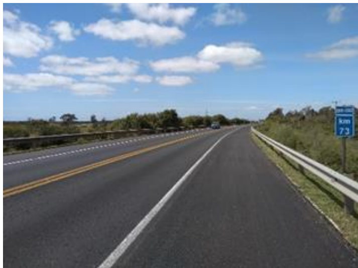
Figura 02 – Serviços de recuperação do pavimento BR-392/RS – Trecho Pelotas – Santana da Boa Vista / km 073+000
