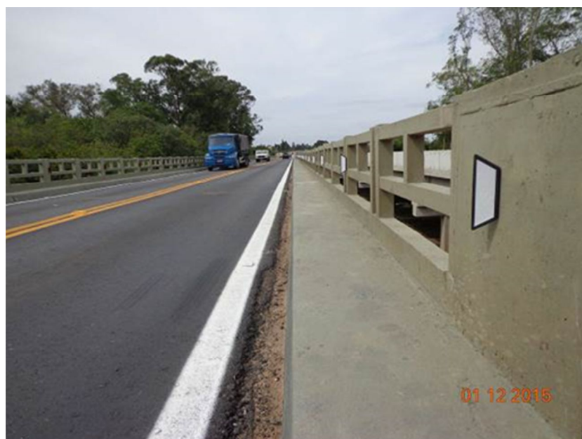
Figura 04 – Recuperação Ponte Sobre o Arroio Grande – BR-116/RS
