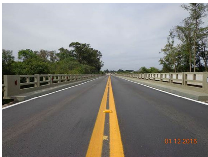
Figura 05 – Recuperação Ponte Sobre o Arroio Grande – BR-116/RS
