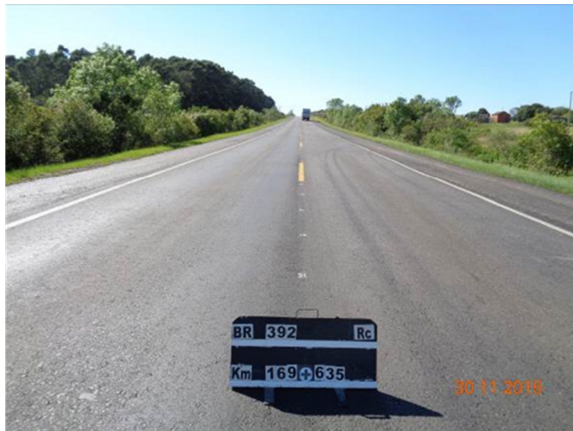
Figura 02 – Manutenção do Pavimento – BR-392/RS
