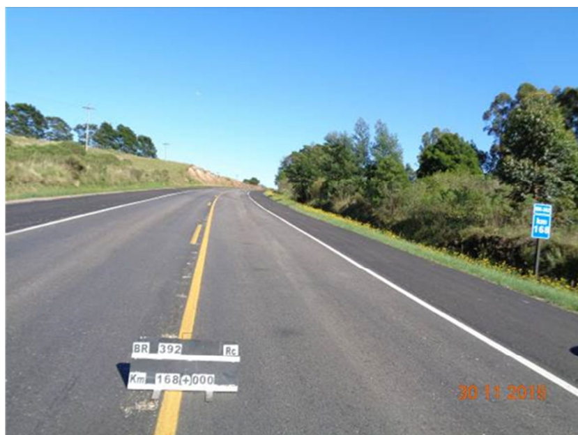
Figura 03 – Manutenção do Pavimento – BR-392/RS
