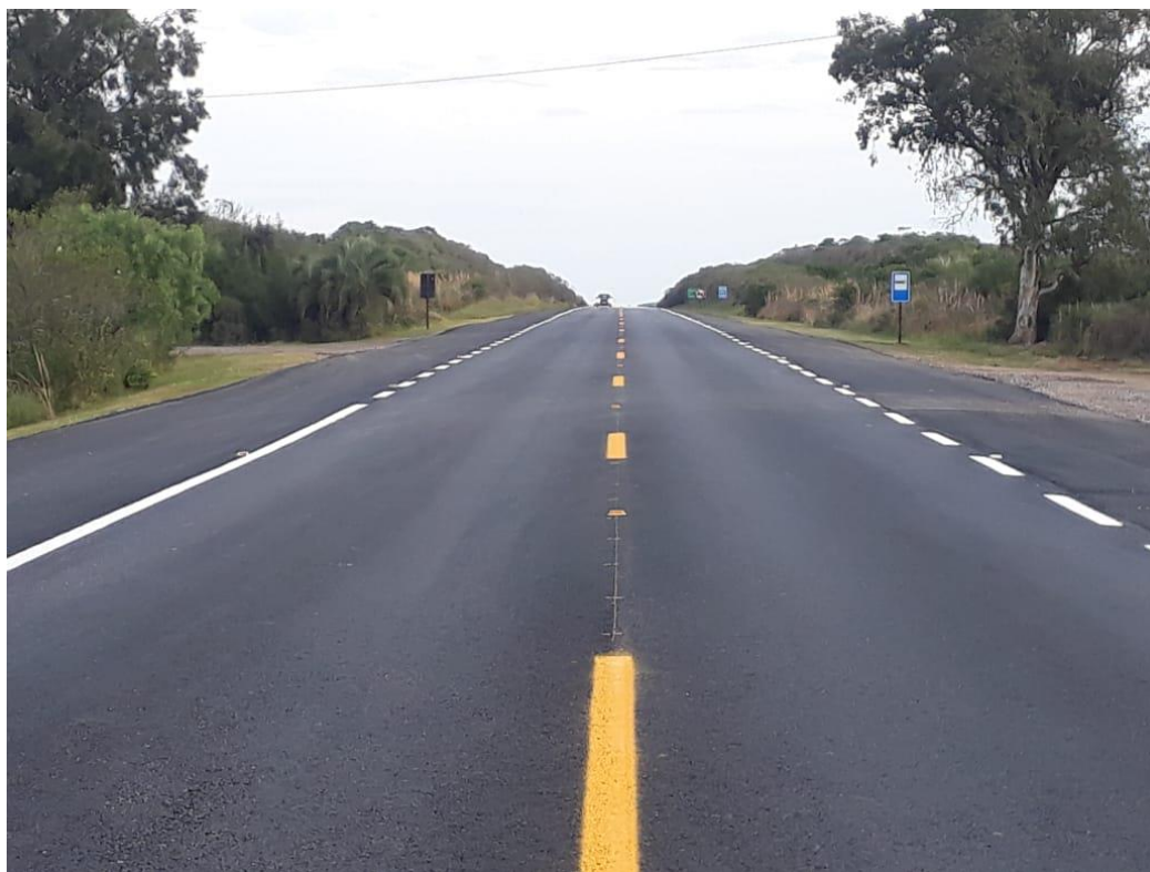
Figura 02 – Serviços de Pavimentação BR-116/RS – Trecho: Pelotas – Jaguarão / km 638,000
