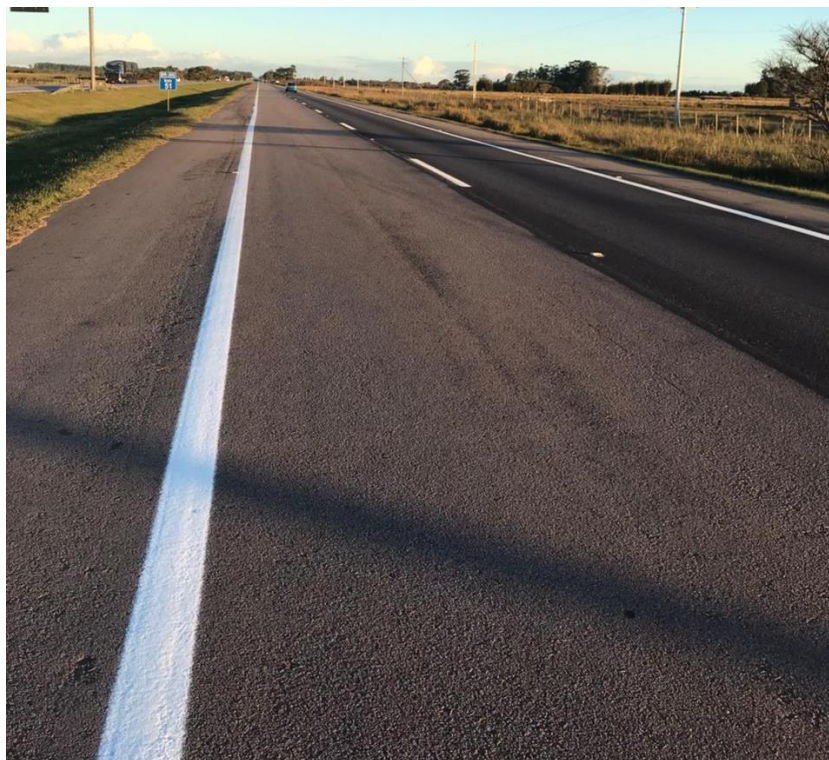
Figura 03 – Serviços de Sinalização Horizontal BR-116/RS – Trecho: Pelotas – Rio Grande / km 051+000
