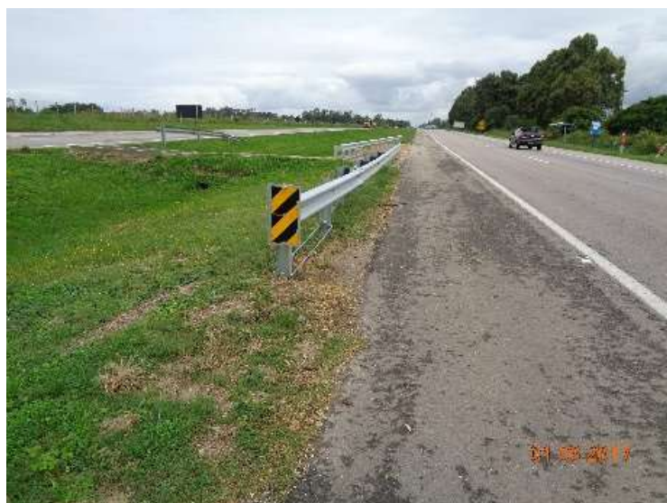
Figura 06 – Implantação defensas metálicas BR-392
