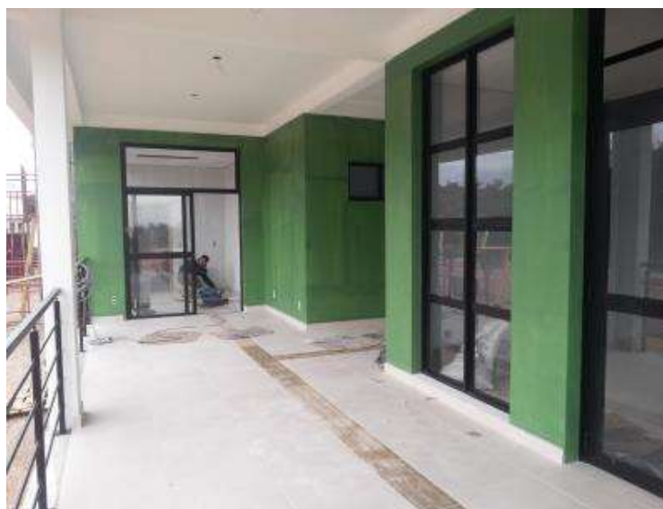
Figura 04 – Construção Bases Operacionais BR-116 km 607+000 LE
