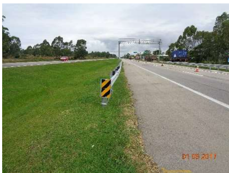
Figura 07 – Implantação defensas metálicas BR-392
