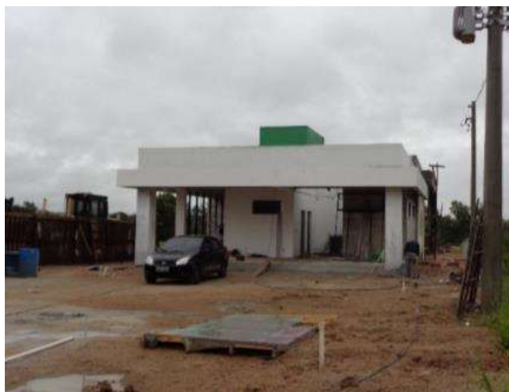
Figura 02 – Construção Bases Operacionais BR-116 km 492+000 LE
