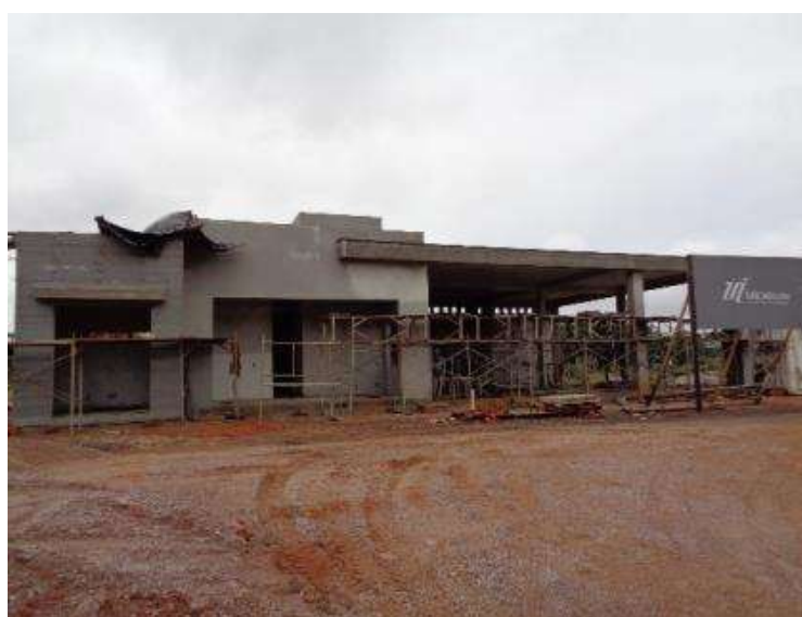
Figura 03 – Construção Bases Operacionais BR-116 km 524+000 LD
