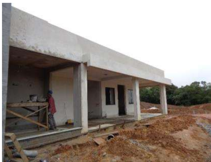
Figura 05 – Construção Bases Operacionais BR-116 km 125+700 LE
