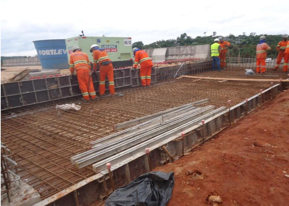
*Figura 05 – Montagem da ferragem da ala*
