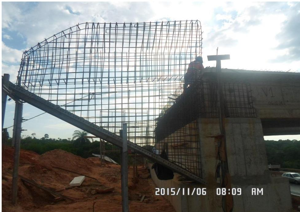
*Figura 03 – Montagem da ferragem da ala*
