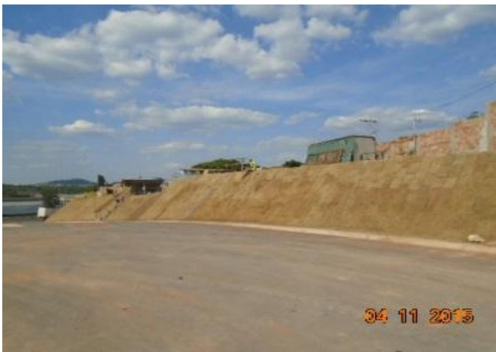
*Figura 02 – Execução de revestimento vegetal*
