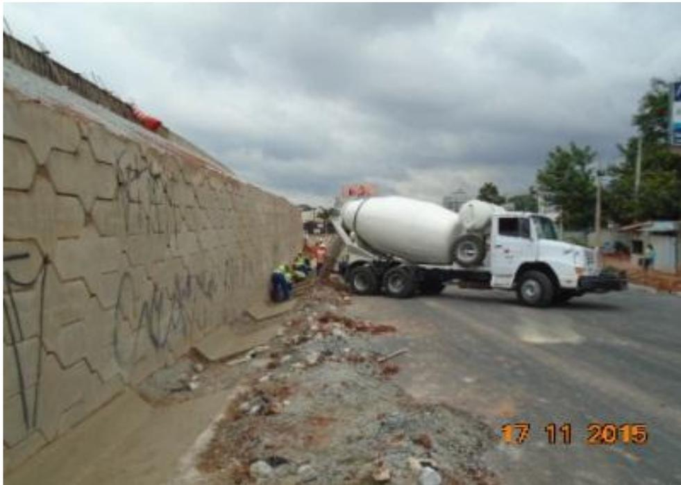
*Figura 05 – Execução de sarjetas*
