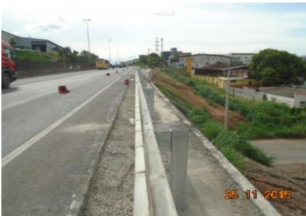
*Figura 06 – Execução de meio fio de concreto*
