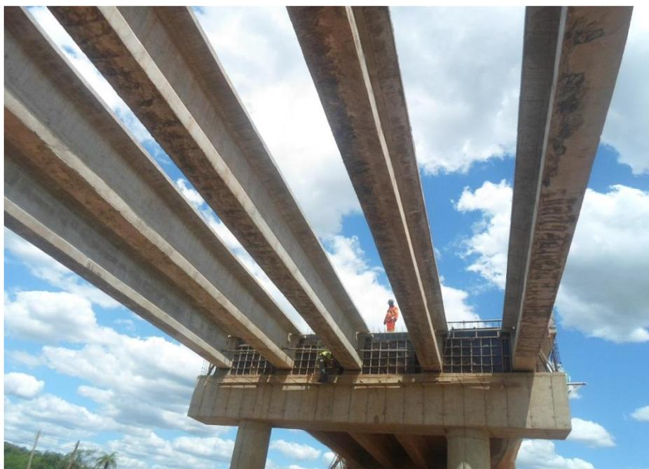
*Figura 01 – Lançamento de vigas pré-moldadas*
