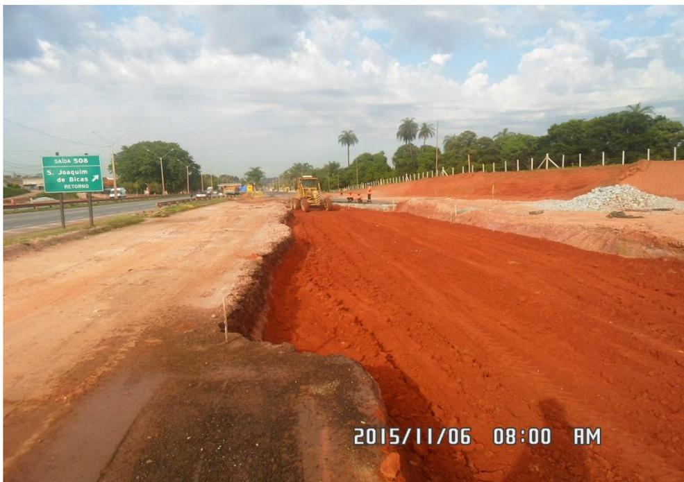
*Figura 06 – Lançamento da camada sub-leito*
