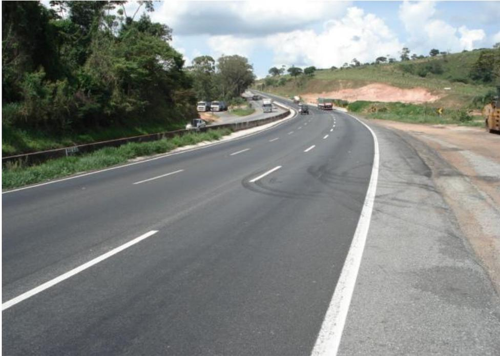
*Figura 05 – Micropavimento lançado*
