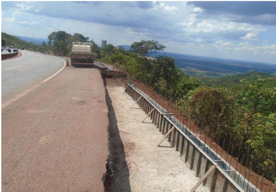
*Figura 02 – Execução de muro de contenção 01*
