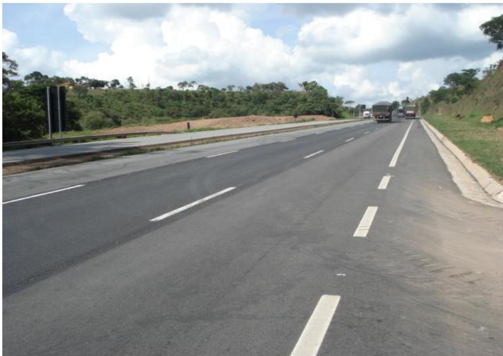
*Figura 06 – Aplicação de micropavimento na faixa 02*
