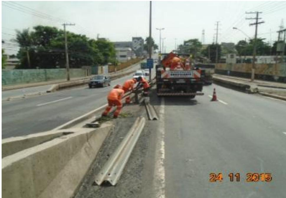
*Figura 03 – Implantação de defesa metálica*
