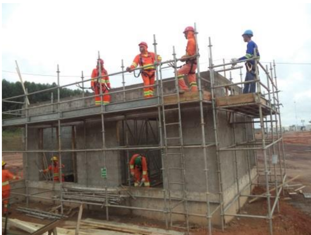
P5 - Escoramento da laje – Depósito de Utilidades
