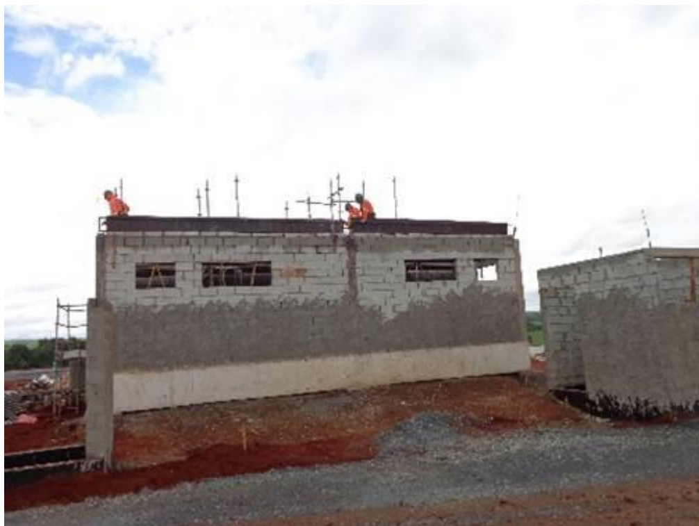
PP7 - Lançamento da laje pré-moldada – Depósito de Utilidades
