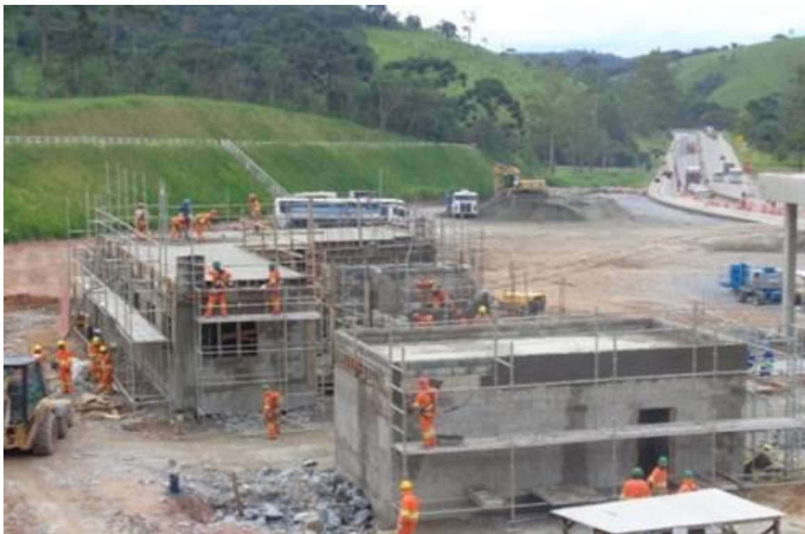
PP11 - Concretagem laje – Posto de Controle e Subestação
