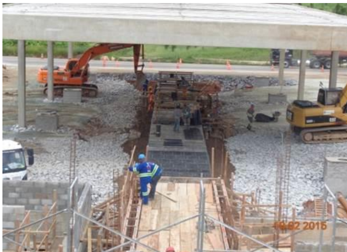
PP10 - Entrega pré-moldados da laje - Posto de Controle.
