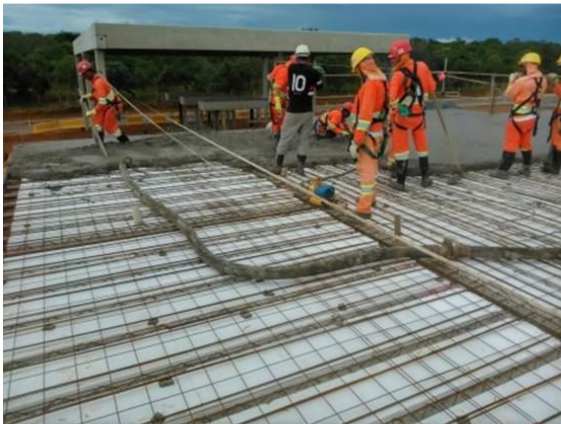
P2 - Concretagem da Laje Posto de Controle
