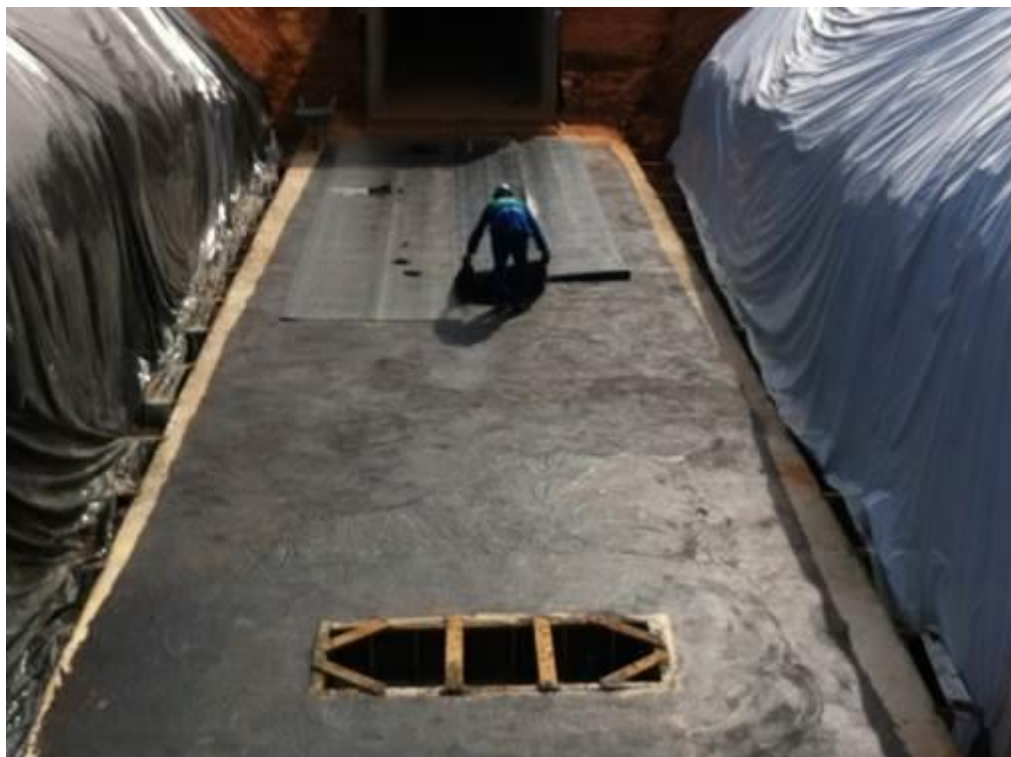
PP6 - Impermeabilização do radier – Túnel
