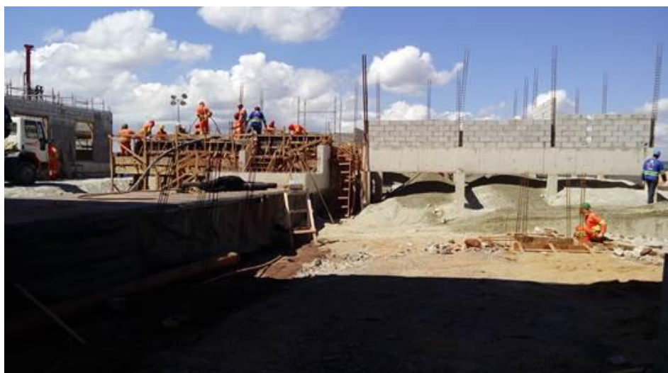
PP9 - Concretagem Vigas / Reaterro Posto de Controle.
