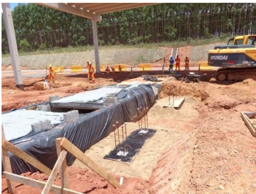
PP5 - Reaterro – Túnel e base das cabines
