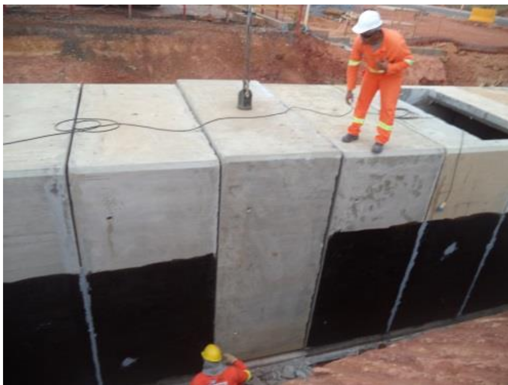
P5 - Impermeabilização - Túnel
