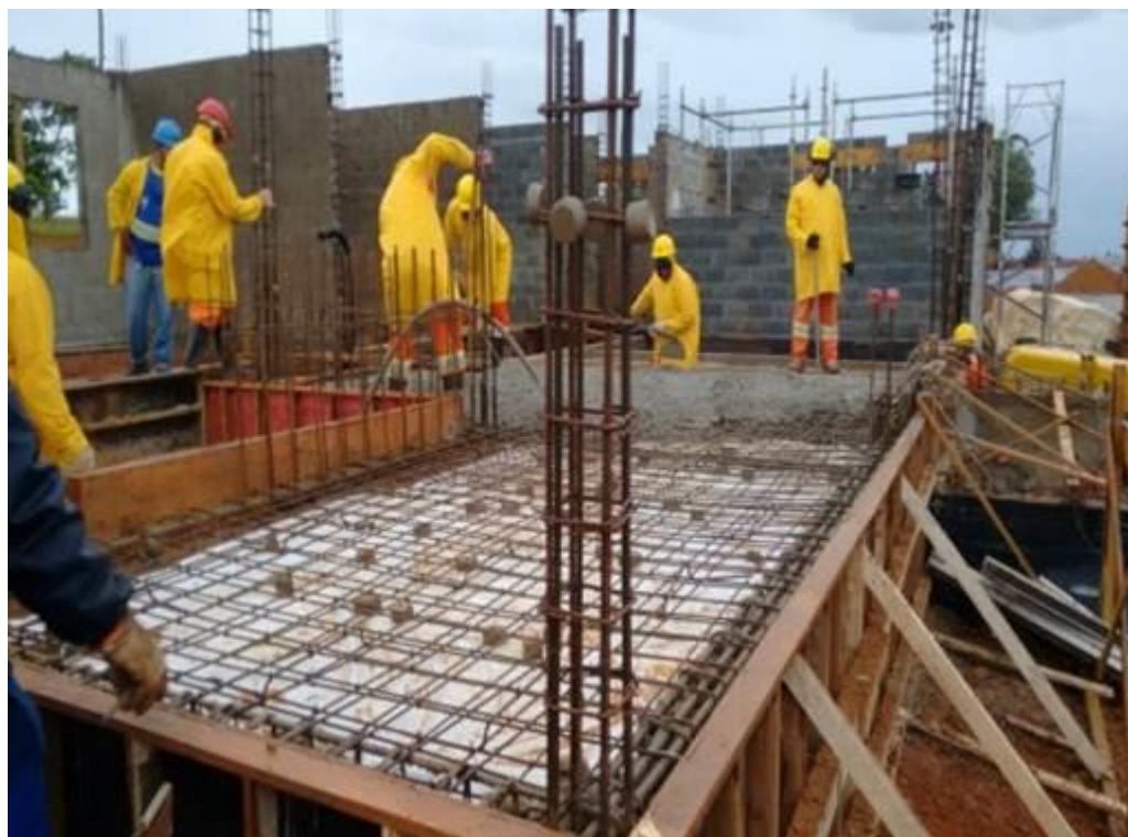
PP6 - Concretagem da L2 – Posto de Controle
