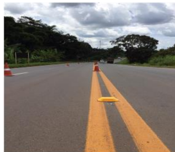
Sinalização Horizontal Implantação de Tachões – km 621
