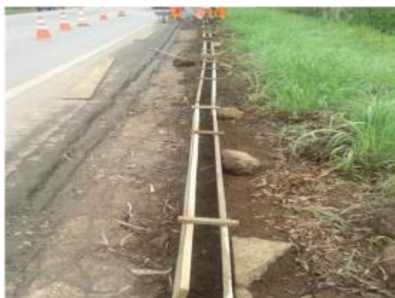
Trecho 03: Km 37/MG - Recuperação de Meio Fio
