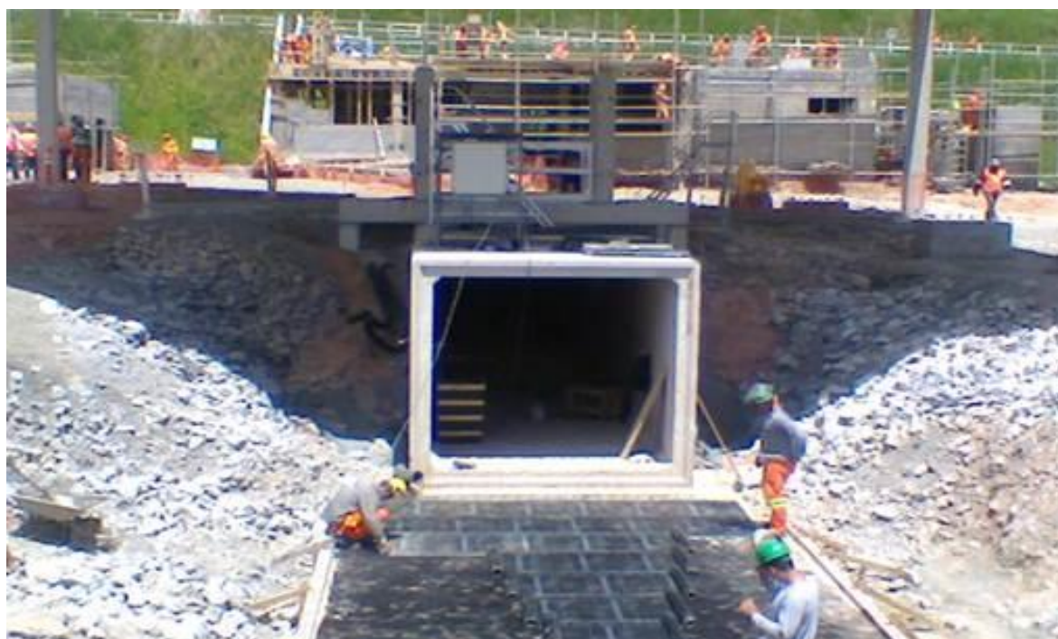
PP11 - Impermeabilização – Base Túnel.
