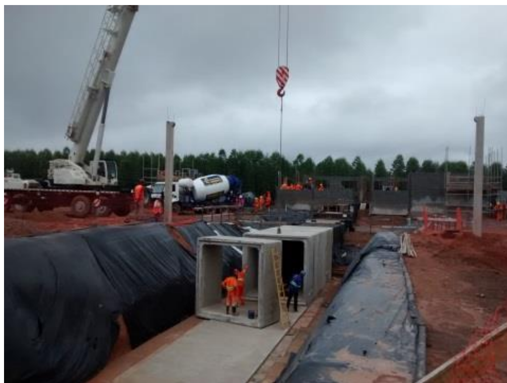
P4 - Lançamento das Aduelas – Túnel
