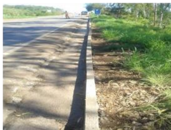
Trecho 03: Km 37/MG - Recuperação de Meio Fio
