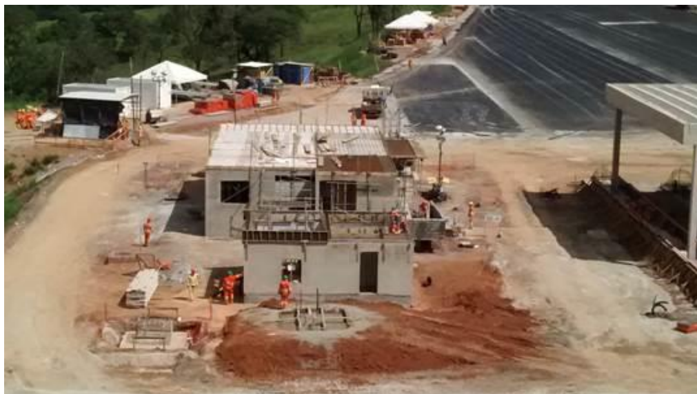
PP8 - Acabamento externo, montagem da laje - Posto de Controle / Depósito Utilidades.
