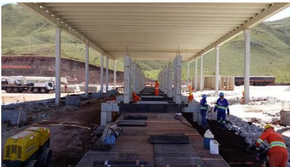
PP9 - Reaterro do Túnel e Lançamento Pilares - Cabines.
