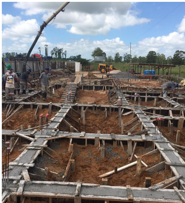
Figura 04 – Concretagem das vigas baldrame – Base Operacional - BR-392/RS – Trecho: Pelotas – Rio Grande / km 033,059
