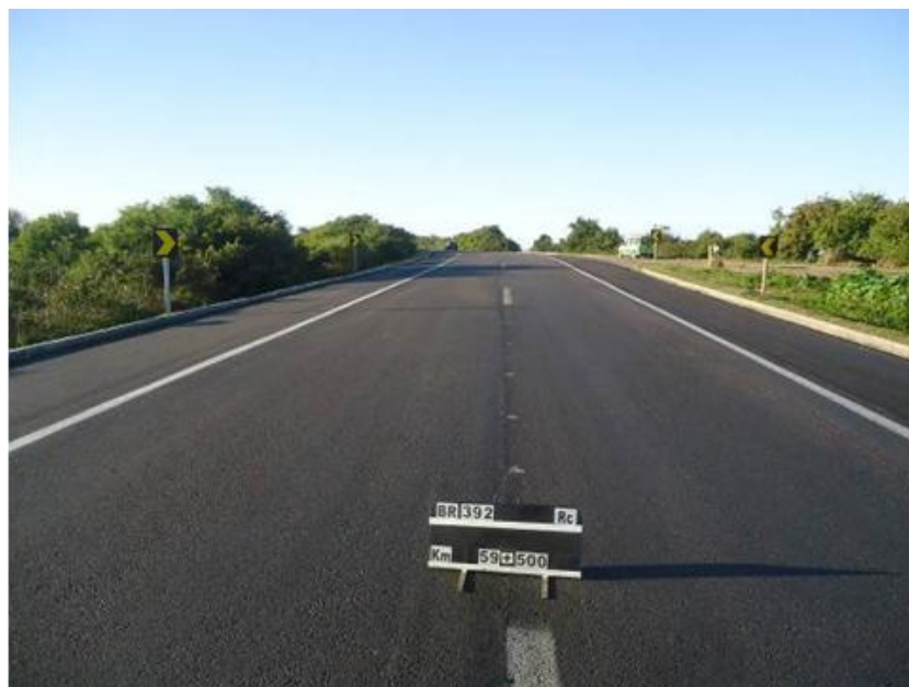
Figura 02 – Manutenção do Pavimento – BR-392/RS
