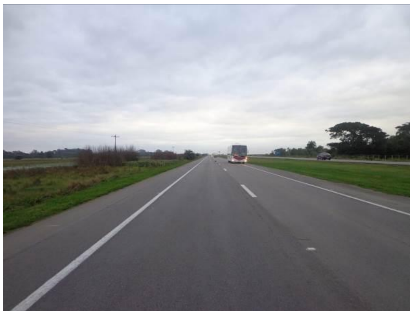
Figura 03 – Manutenção do Pavimento – BR-392/RS
