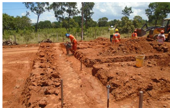
SAU 10 – Execução da infra da fundação da edificação e terraplenagem
