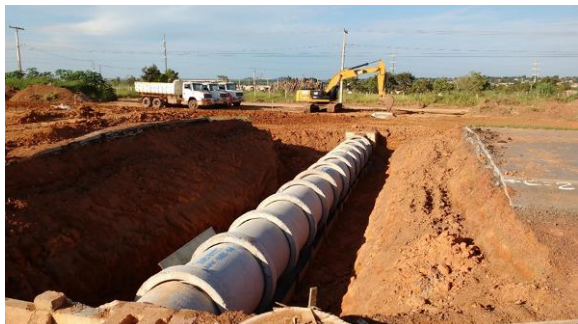
Execução de drenagem na marginal sul - Km 26+200/GO
