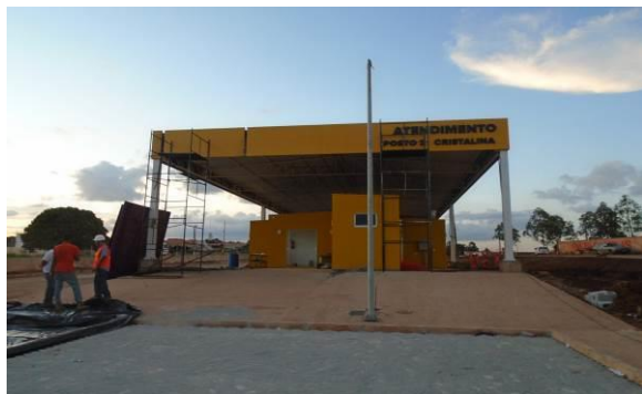
SAU 3 – Execução do piso intertravado e montagem da cenografia
