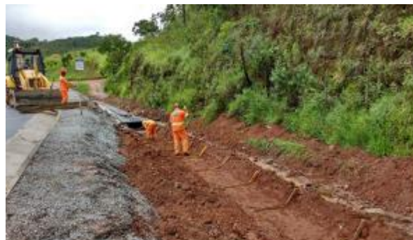
SAU 20: Execução de drenagem
