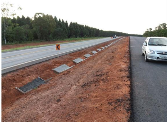
Execução de sarjeta no canteiro central - Km 162+800/MG
