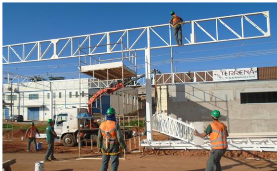
SAU 5 – Montagem da cobertura metálica
