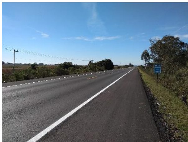
Figura 02 – Serviços de recuperação do pavimento BR-116/RS – Trecho Pelotas – Jaguarão / km 569+000
