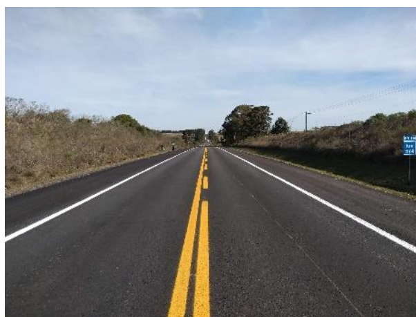
Figura 03 – Serviços de sinalização horizontal BR-116/RS - Camaquã – Pelotas – Jaguarão / km 574+000
