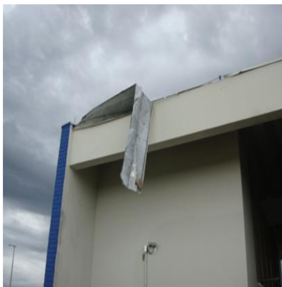
Conserto de Calha KM 85 Sul – Balança MG
