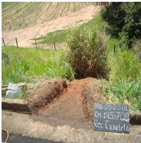
Construção de Descida D'água KM 145+706 Sul MG
