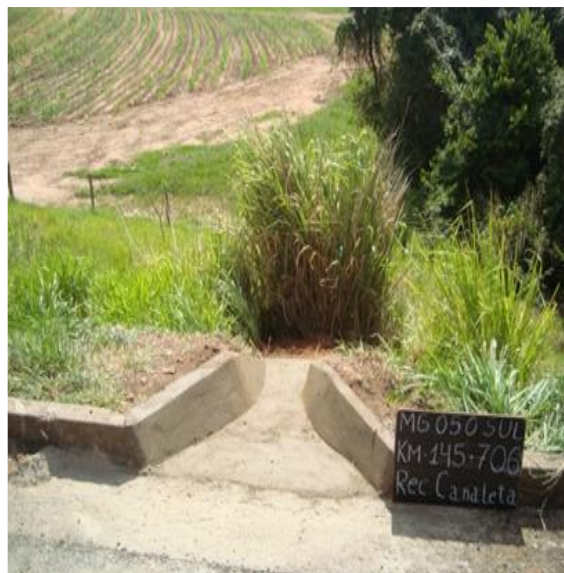
Construção de Descida D'água KM 145+706 Sul MG
