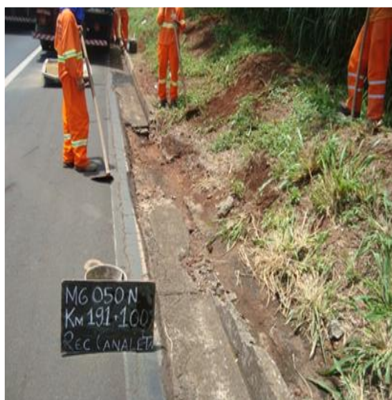
Recuperação do Meio Fio e Canaleta KM 191+100 ao 191+095 Norte MG
