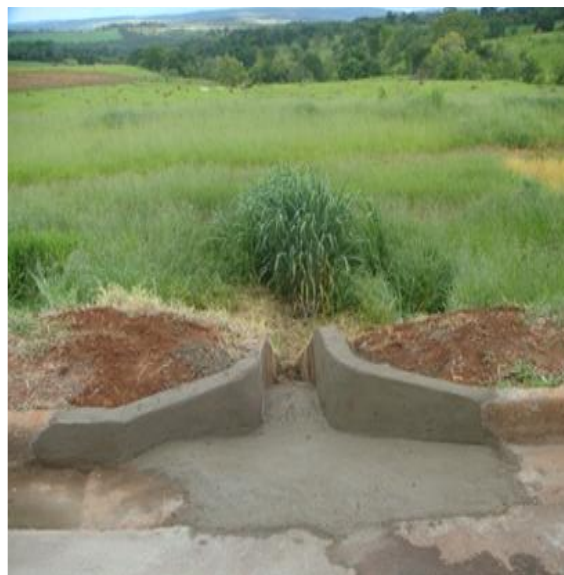
Recuperação de Descida D'água KM 243+280 Norte GO
