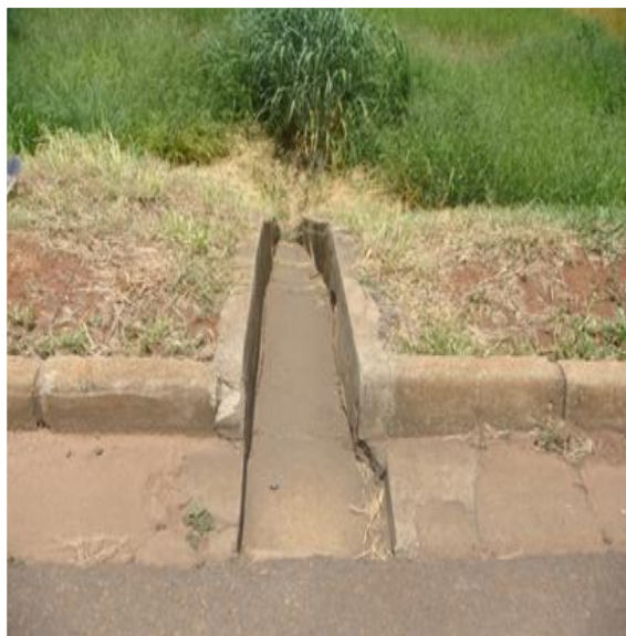
Recuperação de Descida D'água KM 243+280 Norte GO
