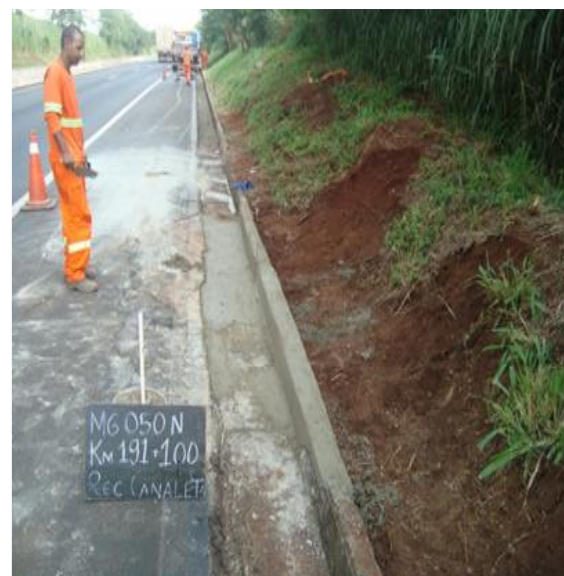
Recuperação do Meio Fio e Canaleta KM 191+100 ao 191+095 Norte MG
