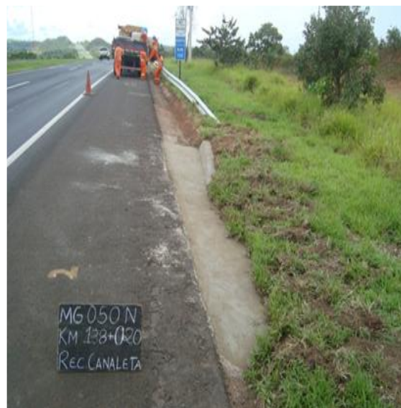
Recuperação de Canaleta KM 131+020 ao 131+010 Norte MG
