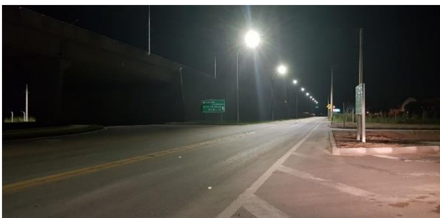
Figura 08 – Serviços de iluminação no Viaduto sobre a Av. Herbert Hadler BR-116 – km 523+562
