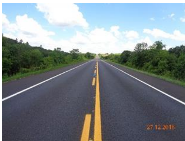
Figura 01 – Serviços de recuperação do pavimento BR-392 – km 176+000 ao 177+220
