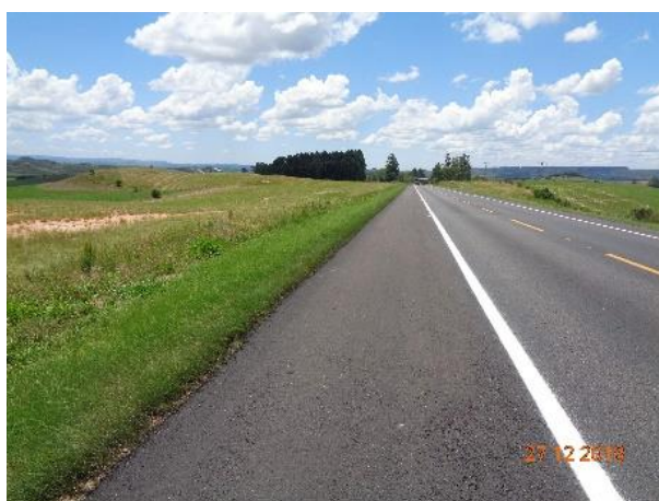
Figura 02 – Serviços de manutenção do acostamento BR-392 – km 170+000 ao 176+600
