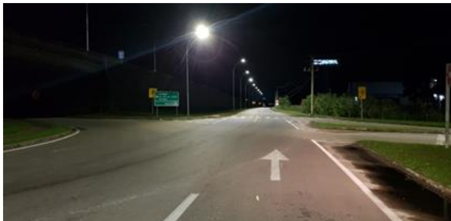
Figura 06 – Serviços de iluminação no Viaduto sobre a Av. 25 de Julho BR-116 – km 521+000
