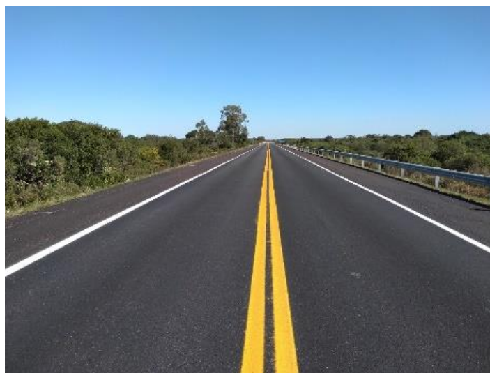
Figura 02 – Serviços de recuperação do pavimento BR-116 – km 556+000
