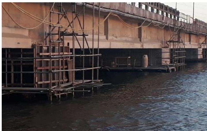
Figura 03 – Serviços de recuperação estrutural da Ponte sobre o Saco da Mangueira BR-392 – km 002+488
