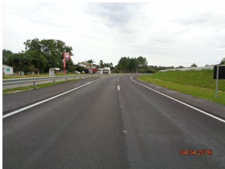
Figura 04 – Recuperação do Pavimento – BR-116/RS
