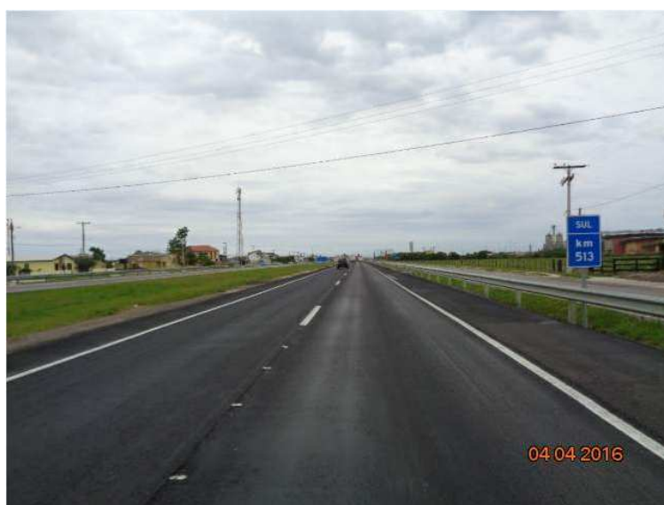
Figura 05 – Recuperação do Pavimento – BR-116/RS
