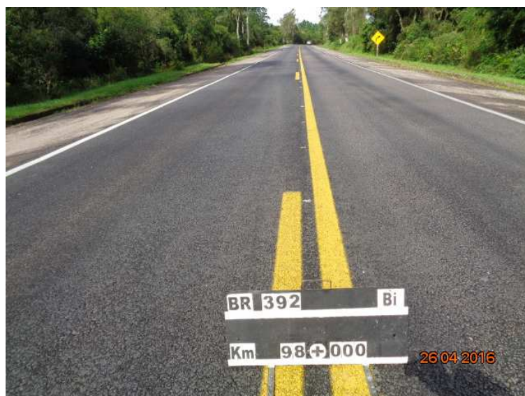
Figura 02 – Recuperação do Pavimento – BR-392/RS
