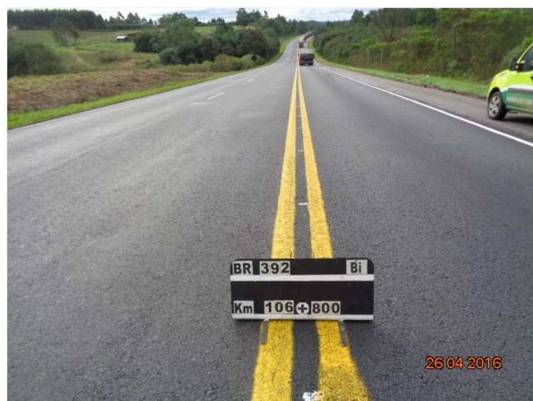
Figura 03 – Manutenção do Pavimento – BR-392/RS
