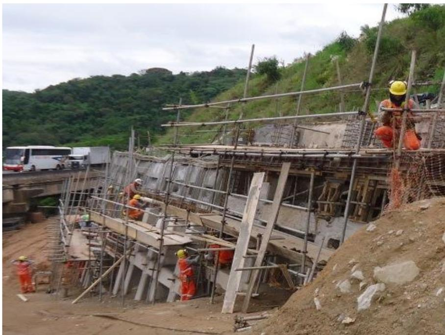
*Figura 01 – Armação das ferragens e formas do Painel F*
