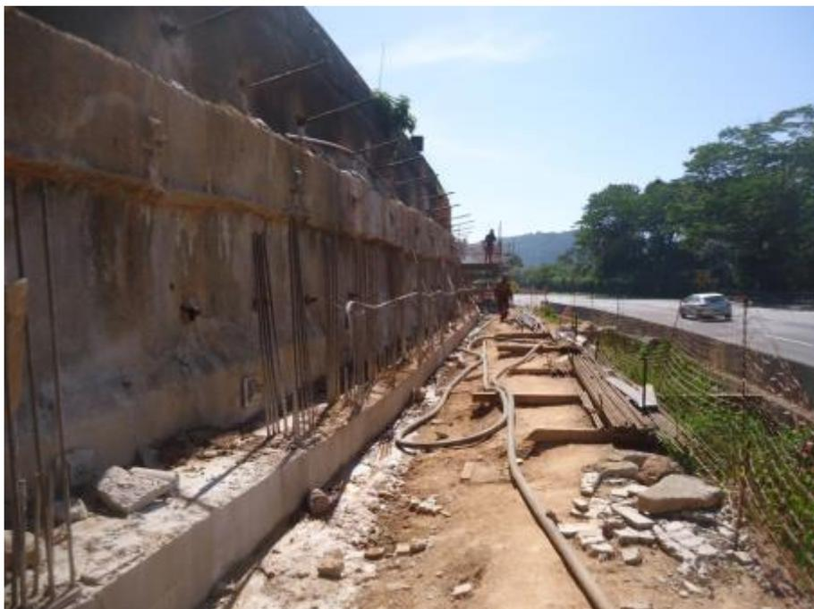
*Figura 01 – Viga de coroamento e armações dos pilares*
