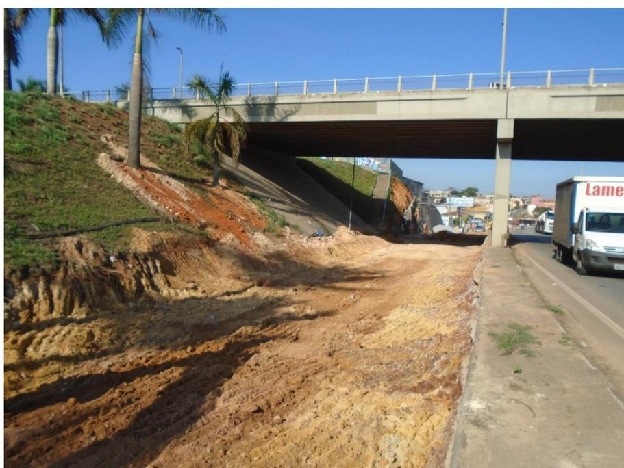
*Figura 06 – Execução de rebaixamento do pavimento.*
