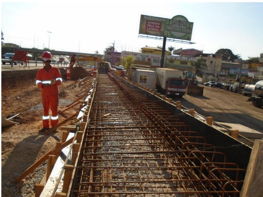
*Figura 02 – Execução da viga*
