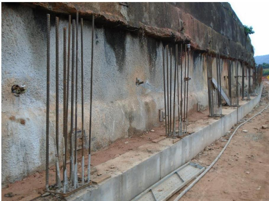
*Figura 04 – Viga de coroamento e armações dos pilares*
