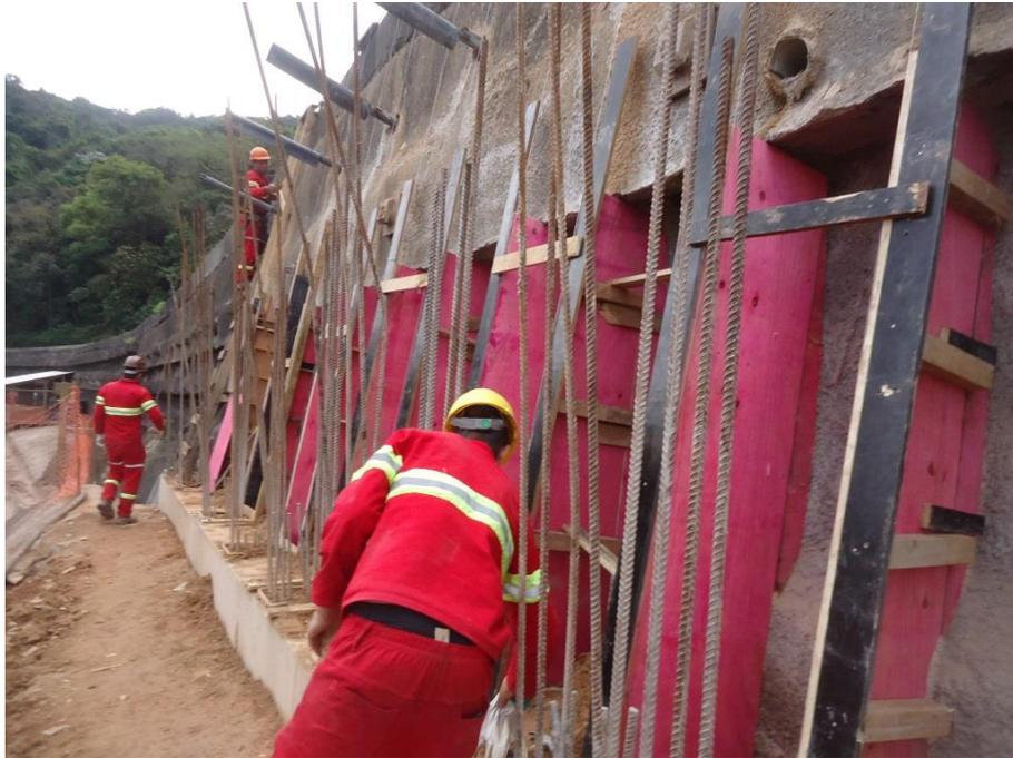
*Figura 03 – Montagem das formas dos pilares*
