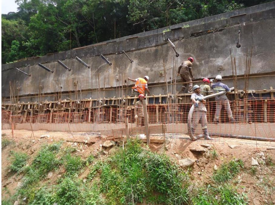
*Figura 01 – Montagem das armações e formas da viga de coroamento*
