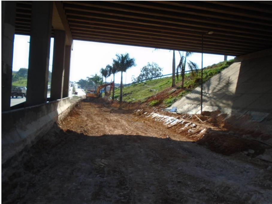
*Figura 03 – Execução de rebaixamento do pavimento*
