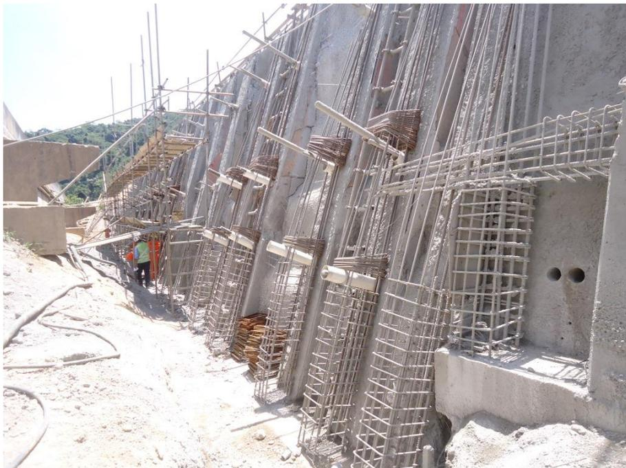
*Figura 05 – Armação das ferragens e formas do Painei B*
