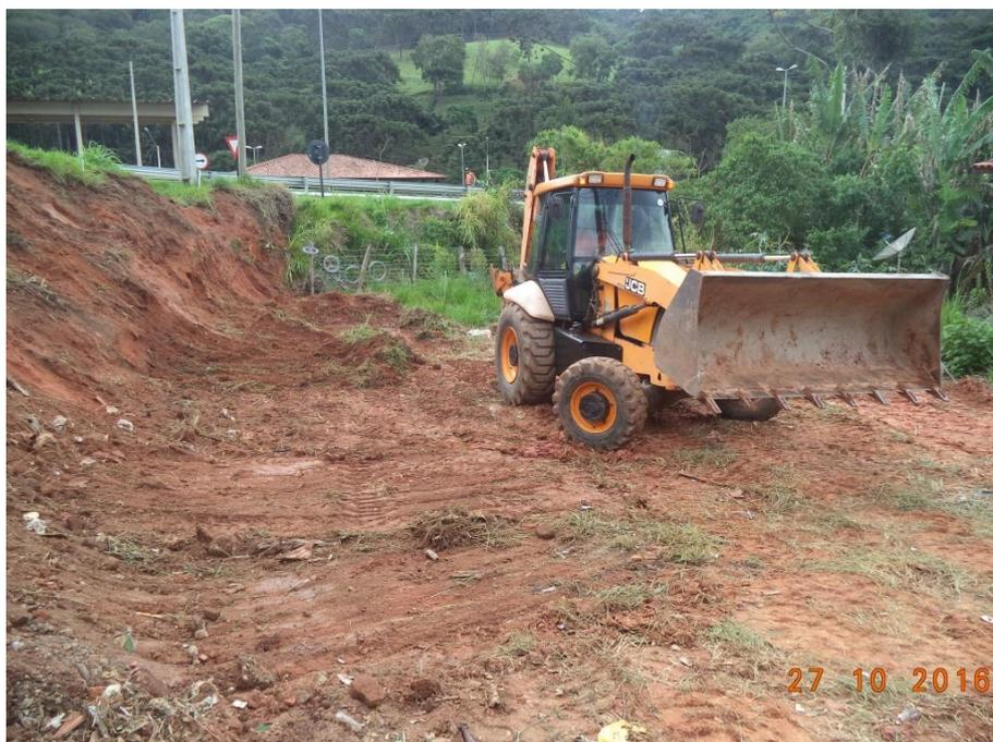
*Figura 05 – Terraplenagem para execução do muro de contenção*
