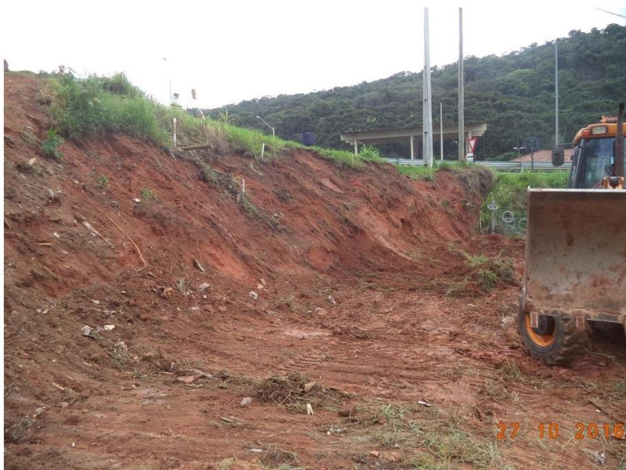
*Figura 04 – Terraplenagem para execução do muro de contenção*
