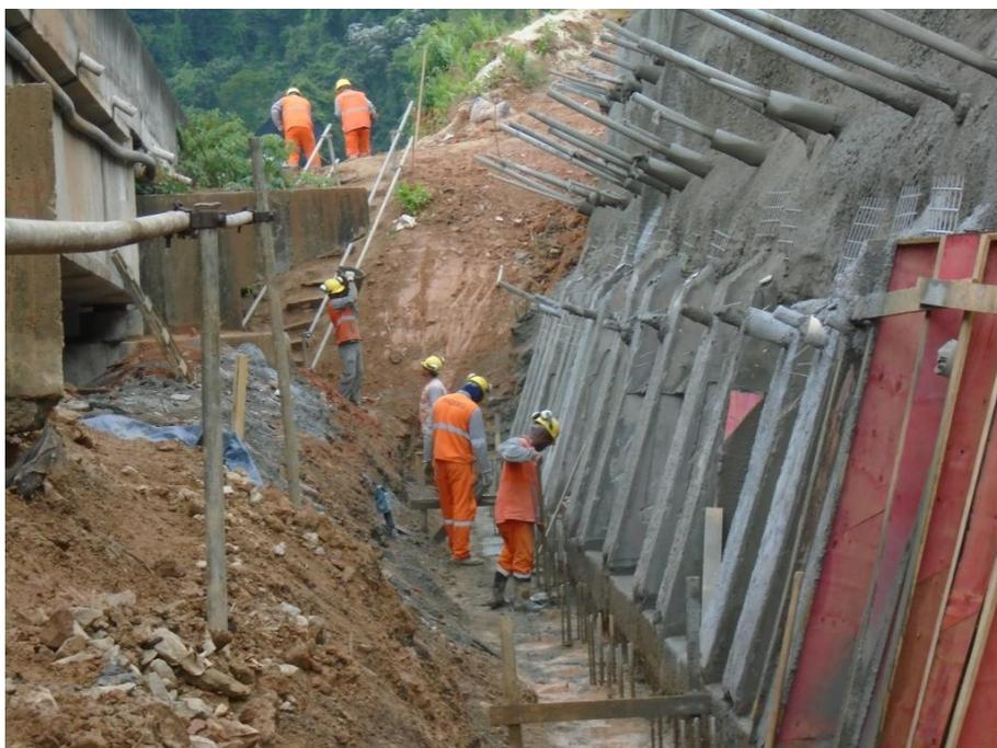
*Figura 06 – Concretagem dos pilares do Painei A*
