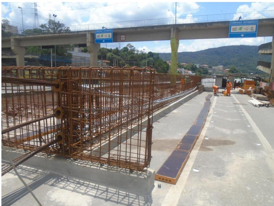
*Figura 02 – Montagem de forma da viga*
