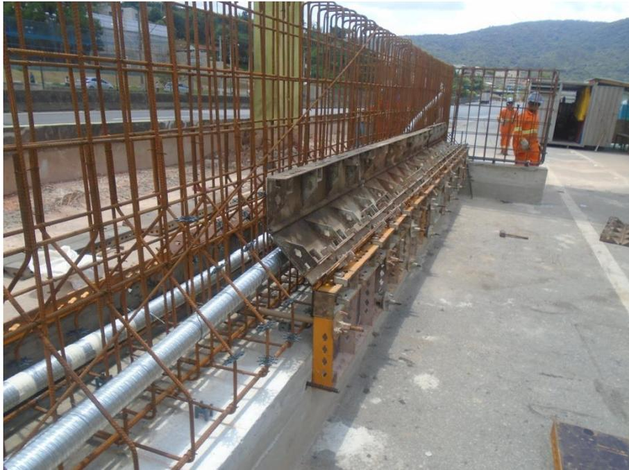
*Figura 03 – Montagem de forma da viga*
