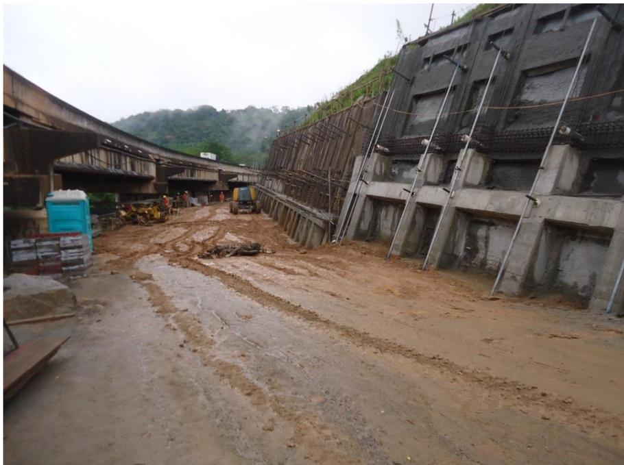
*Figura 03 – Armação das ferragens e formas do Painel C e D*
