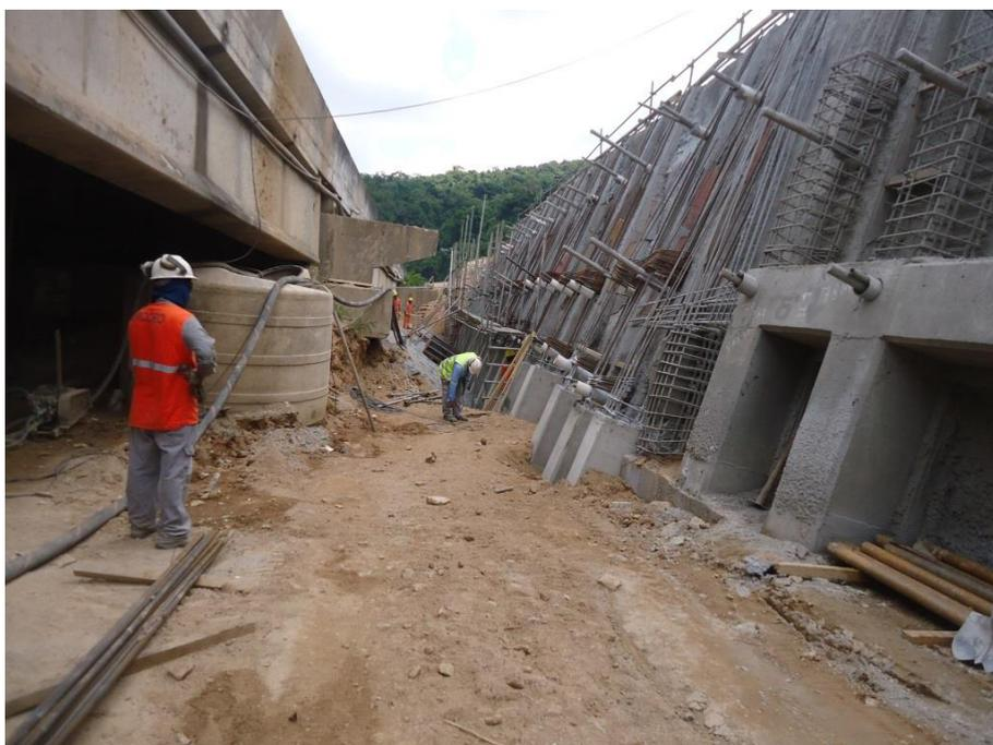
*Figura 04 – Armação das ferragens e formas do Painel B*
