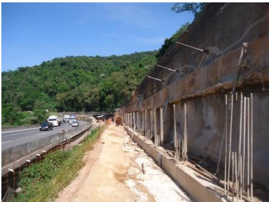
*Figura 03 – Viga de coroamento e armações dos pilares*
