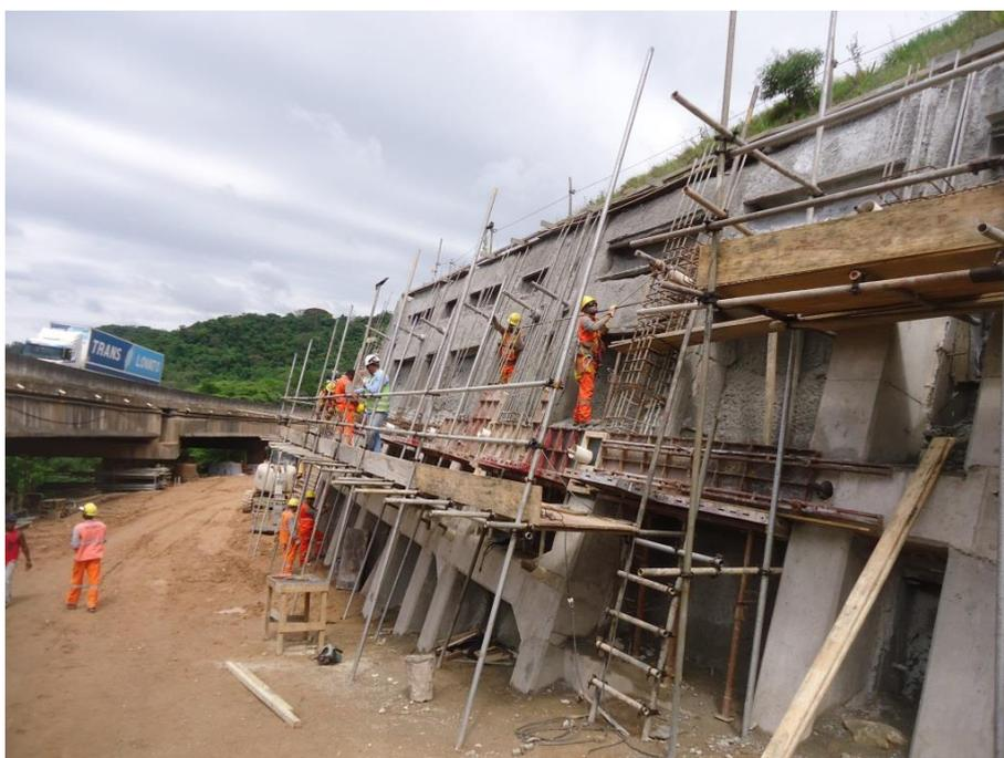
*Figura 02 – Armação das ferragens e formas do Painel E e F*
