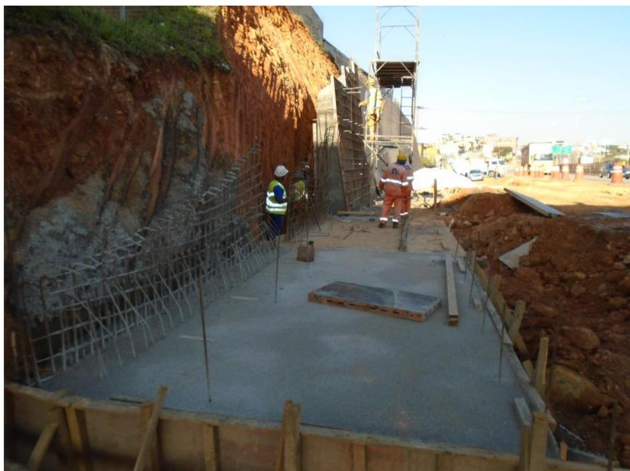
*Figura 05 – Escavação da base - Muro de contenção*
