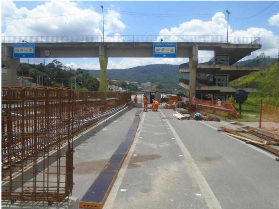
*Figura 01 – Montagem de forma da viga*
