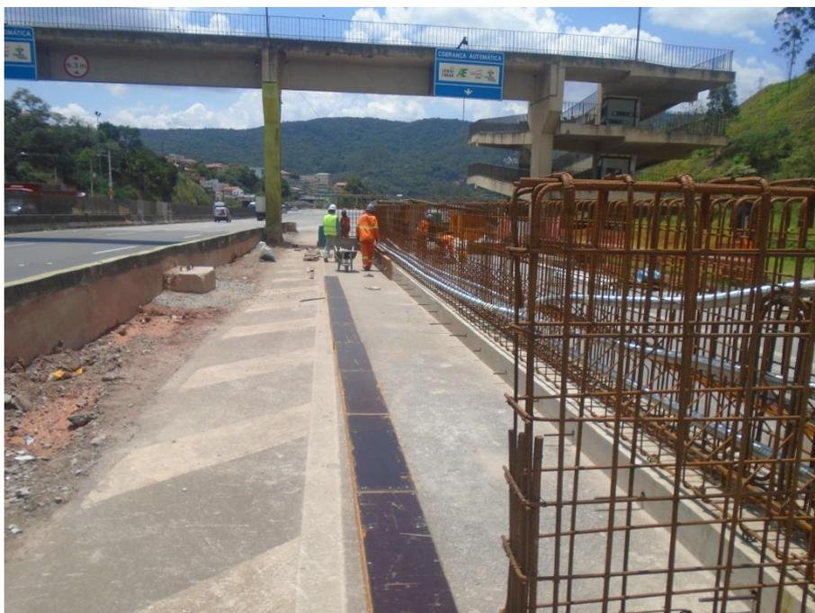
*Figura 04 – Montagem de forma da viga*
