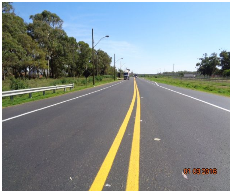
Figura 04 – Recuperação do Pavimento – BR-392/RS
