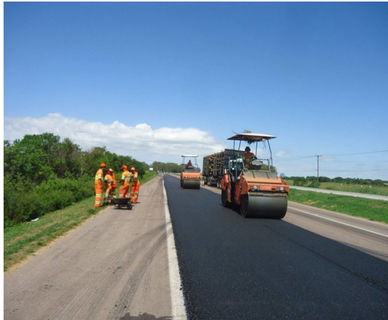
Figura 02 – Recuperação do Pavimento – BR-392/RS
