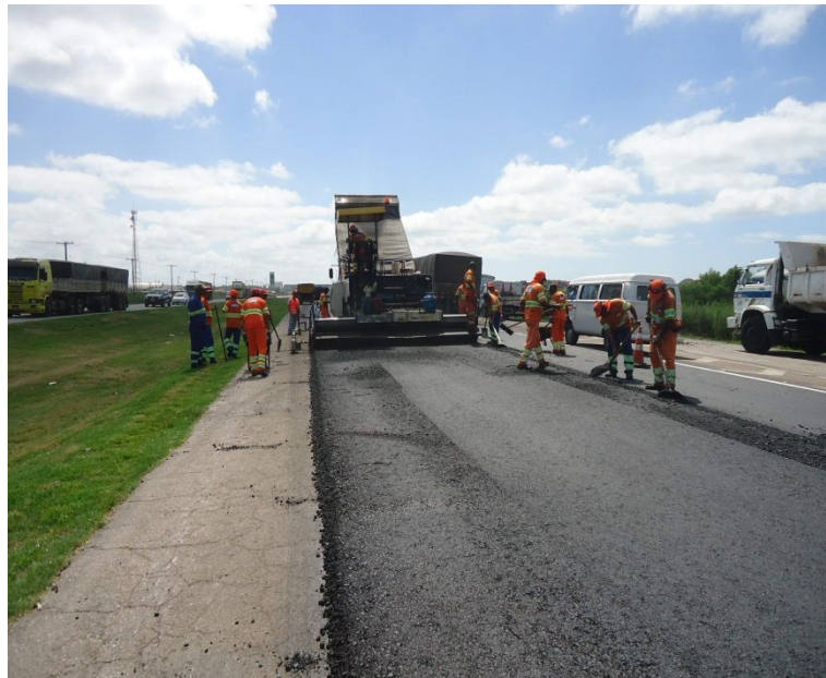
Figura 03 – Manutenção do Pavimento – BR-116/RS
