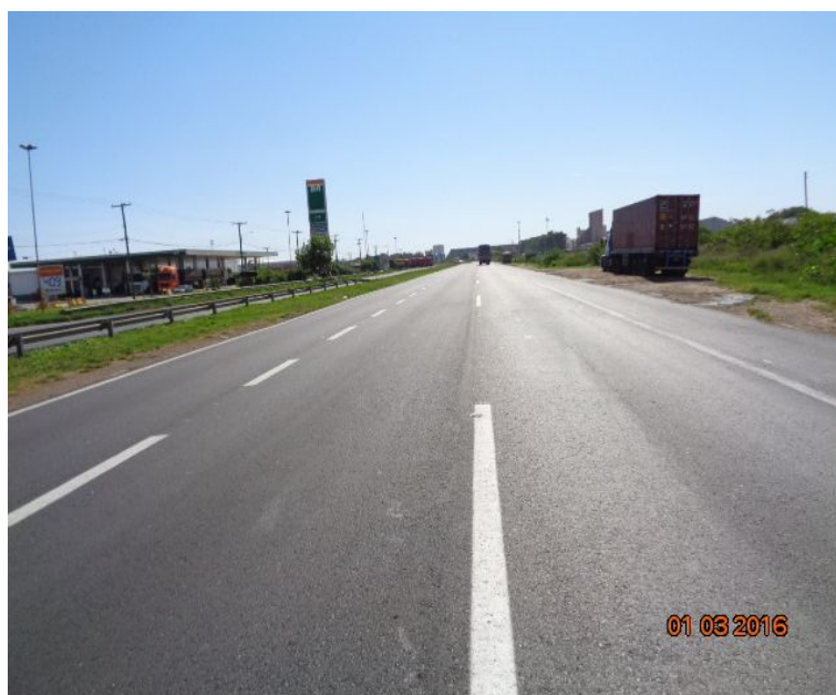
Figura 05 – Recuperação do Pavimento – BR-392/RS
