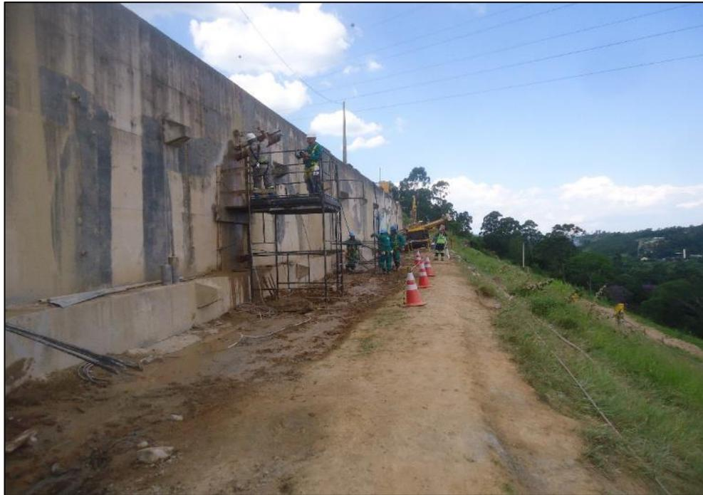
*Figura 03 – Execução de perfuração e injeção Tirante*
