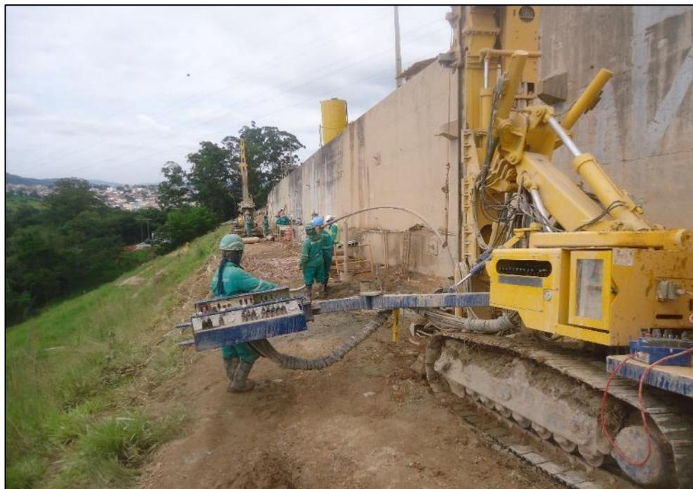
*Figura 01 – Perfuração e injeção de estaca raiz*
