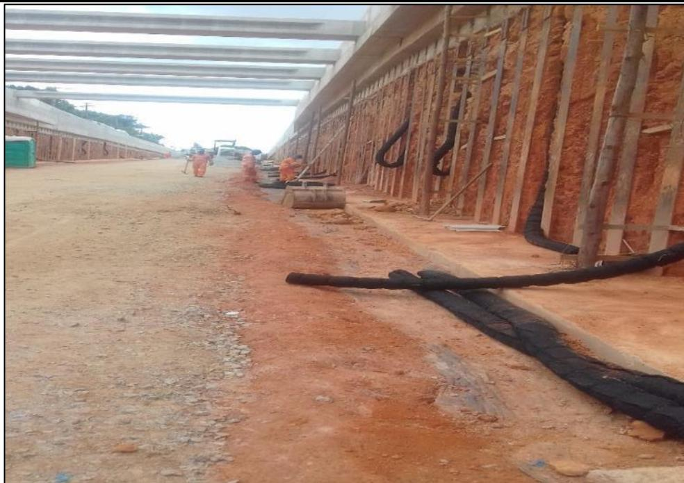
*Figura 03 – Sistema de drenagem*
