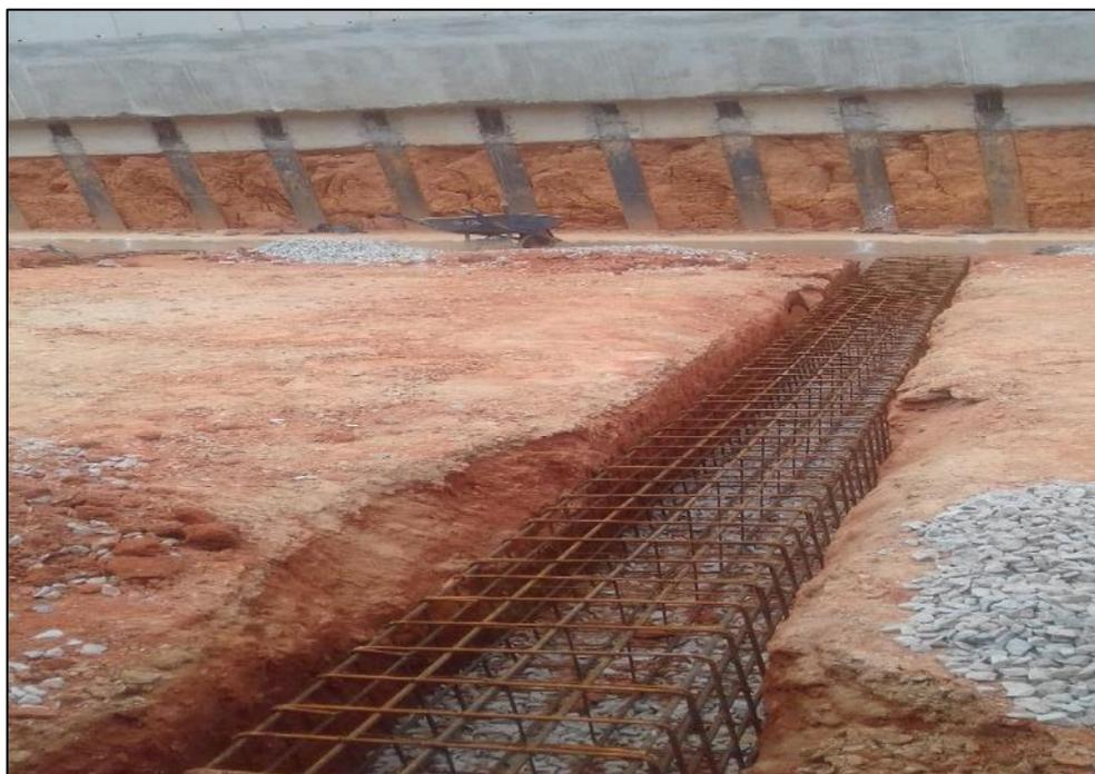
*Figura 04 – Estroncas inferiores*
