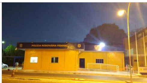
Reforma da PRF Paracatu - Concluído
