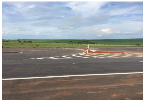
Retorno em Nível – Km 71+300/GO - Concluído
