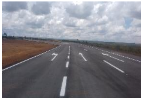
Retorno em Nível - Km 115+000/GO - Concluído
