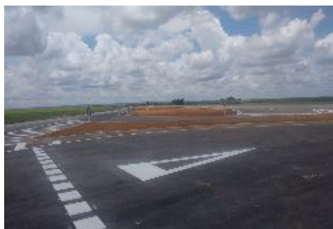
Retorno em Nível - Km 120+700/GO - Concluído
