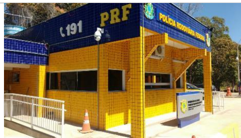
Reforma da PRF Três Marias - Concluído
