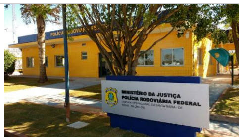
Reforma da PRF Santa Maria - Concluído
