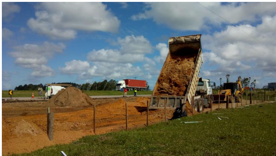
Figura 04: Serviços de Terraplenagem – Base Operacional BR-392/RS – Trecho: Pelotas – Rio Grande / km 033,057
