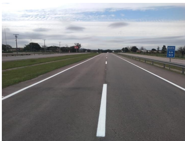
Figura 03: Serviços de Sinalização Horizontal BR-116/RS – Trecho: Pelotas – Jaguarão / km 513,000
