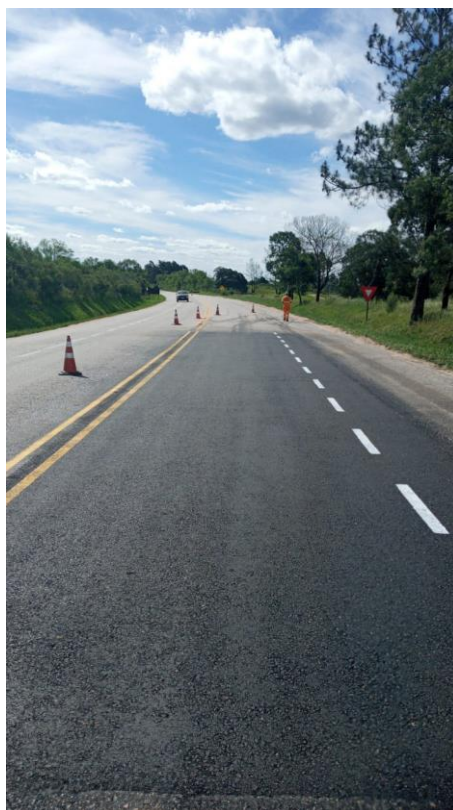
Figura 02: Serviços de Pavimentação BR-116/RS – Trecho: Pelotas – Santana da Boa Vista / km 140,600
