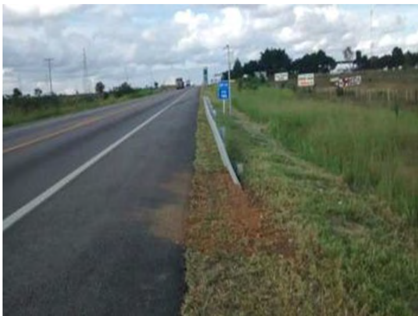
Figura 07 – Implantação de Defensas Metálicas
