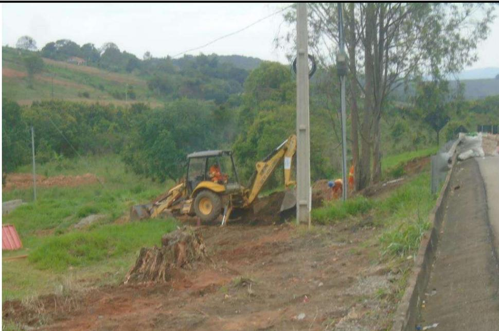
*Figura 02 – Limpeza e remoção da camada vegetal*
