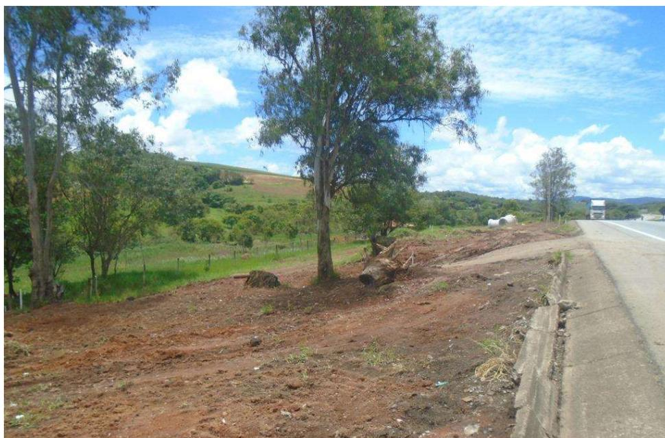
*Figura 01 – Limpeza e remoção da camada vegetal*
